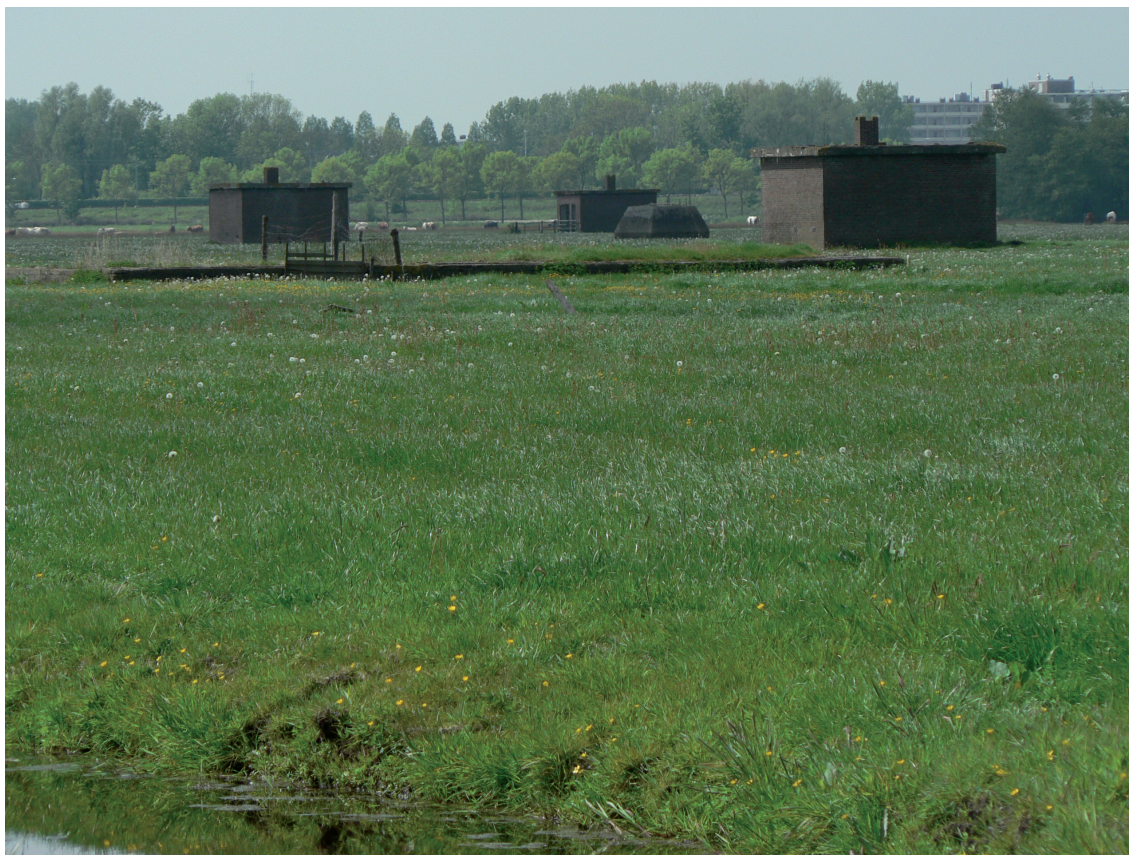
Figuur 5. Enkele gebouwen van het Duitse radarstation Seeadler bij Weesp (foto: Ruurd Kok, mei 2010).
