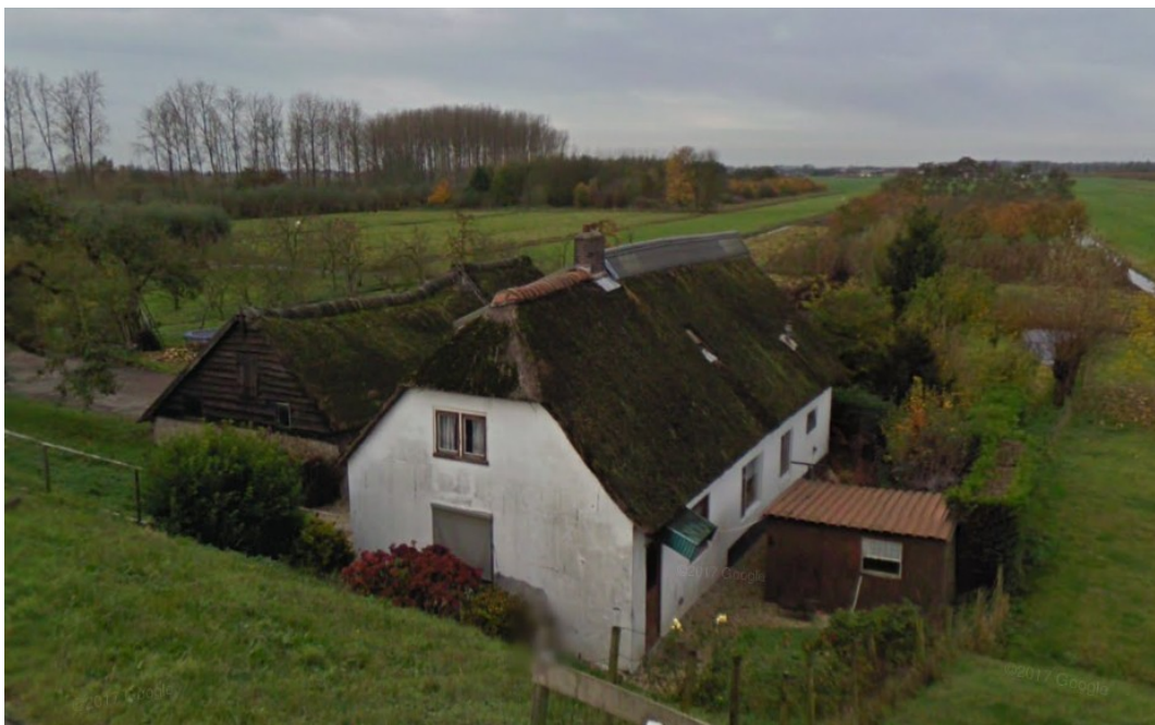
Figuur 7: Foto 2 plangebied vanaf Diefdijk (Google Street View).
