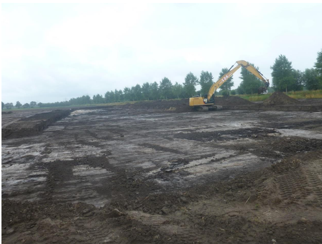
Figuur 3. Aanleg van het vlak in deelgebied 2.
