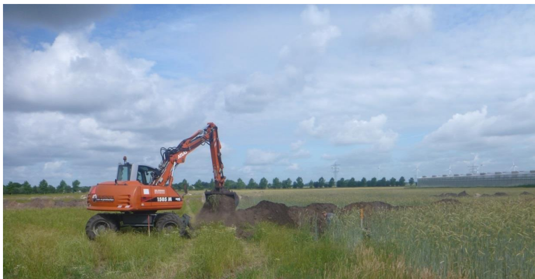
Figuur 2. Aanleg van het vlak in deelgebied 1.
