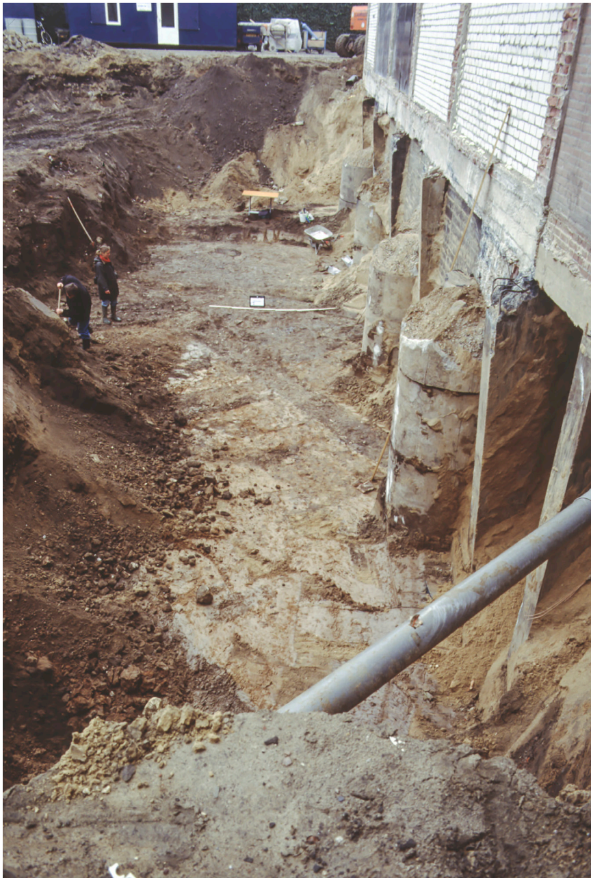
Figuur 35. Fundering van het westelijke deel van de Honig.
