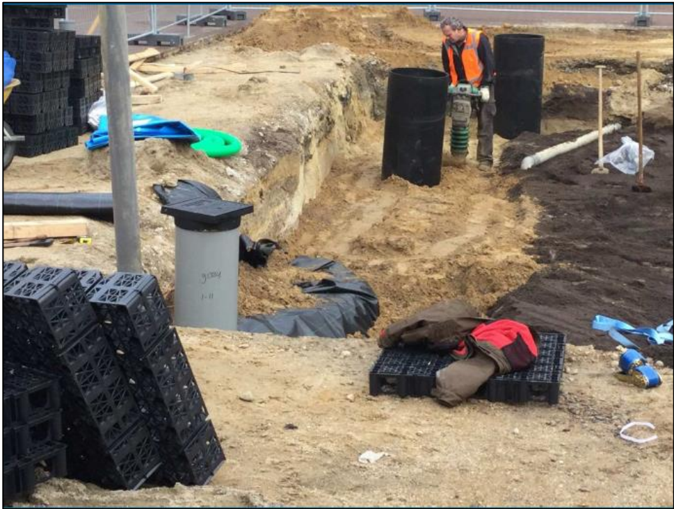
Figuur 18. De beschermde waterput. Bron: Wim Truyen.
