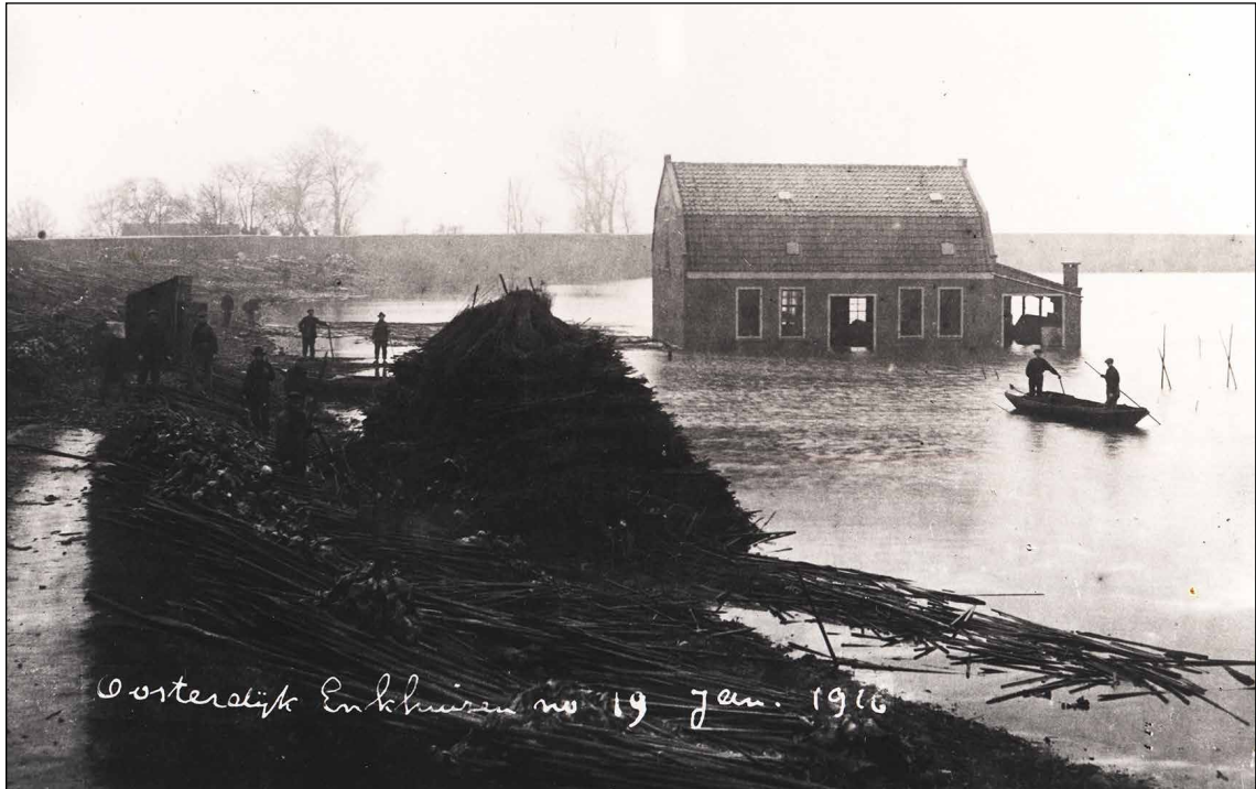
Afb. 12 Herstelwerkzaamheden in de Immerhornpolder na de overstroming van januari 1916. Digitaal archief Oud Enkhuizen.
