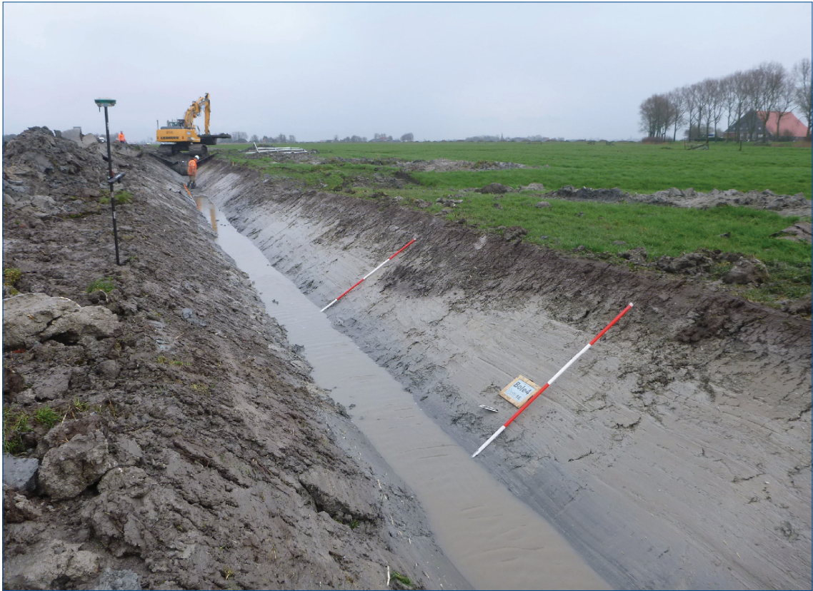
Figuur 4. Het nieuwe sloottalud.
