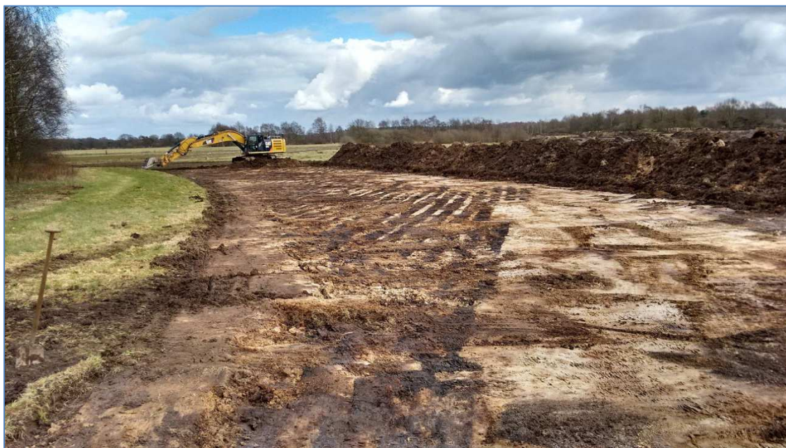
Figuur 7. Zicht op diepe ploegsporen in het vlak in een intensief te begeleiden zone (zicht op het westen).
