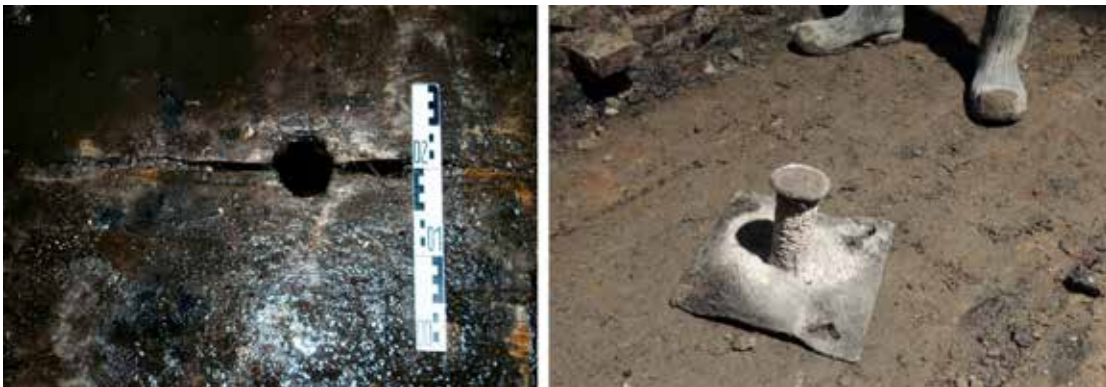
46 Links het gat in de houten bodem van de keldervloer (S 1), rechts een voorbeeld van de lodenbekleding van het lokgat van een keldervloer op het adres Prinsengracht 18 (vindplaats PR33, 2012)
