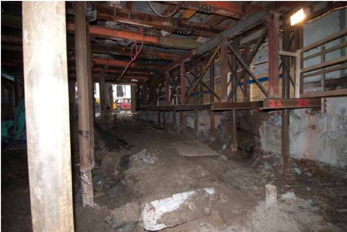
74 Perceel Kerkstraat 60 gezien richting de straat tijdens de eerste fase van de civieltechnische ontgraving. Ter hoogte van dit in 1977 verbouwde perceel was de ondergrond grotendeels verstoord
