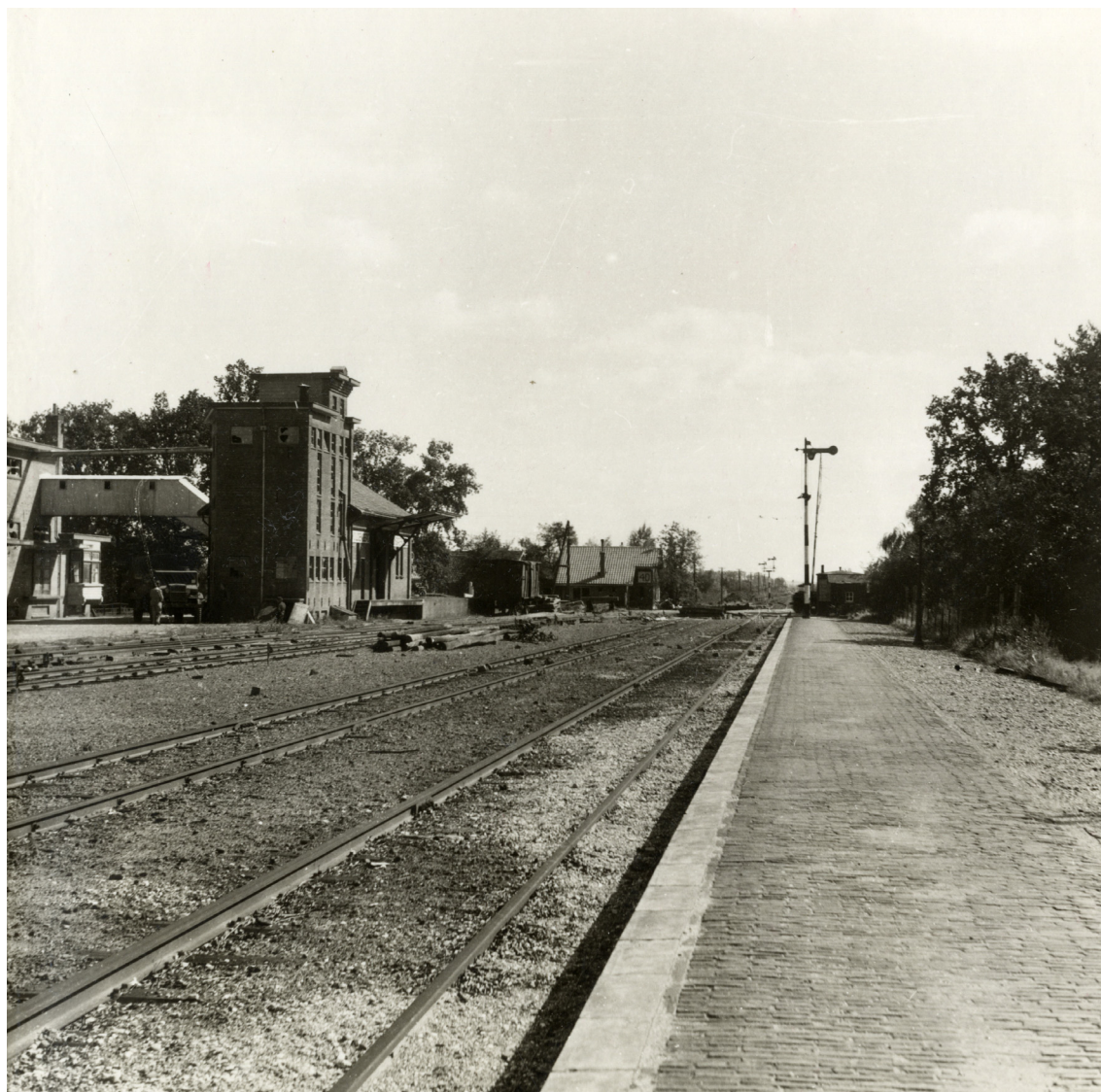
Figuur 7. Foto van het plangebied anno 1945 naar het zuiden; links van het spoor het nog bestaande industriële complex Parallelweg 2, in het midden de niet meer bestaande wachtpost 40 (bron: Utrechts Archief, beeldbank nummer 157929).
