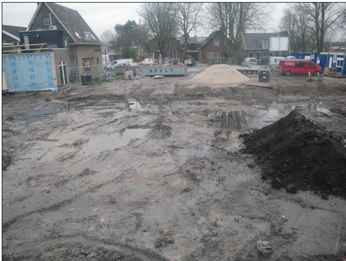
Figuur 2: Het plangebied aan de Dorpsstraat bij aanvang van het onderzoek.
