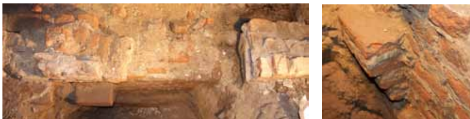
16, 17. Bakstenen console (boven- en zijaanzicht).
