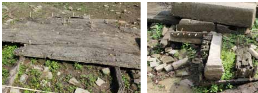
14, 15. Dekplanken op de dekbalken van het achterschip. Rechts de ijzeren bak waarin de motor lag. Er omheen betonnen ballaststukken.
