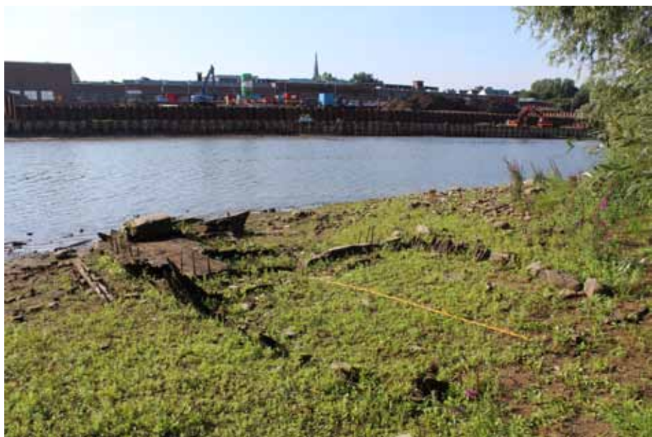
8, 9. Boven: achterschip met een deel van het dek. Beneden: van het voorschip zijn tussen de begroeiing alleen de koppen van de spanten te zien.
