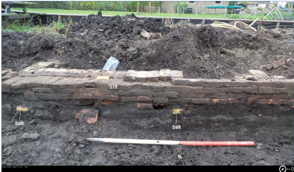
Figuur 13. Fundering jongere zijgevel (spoor 19) op houten balken.
