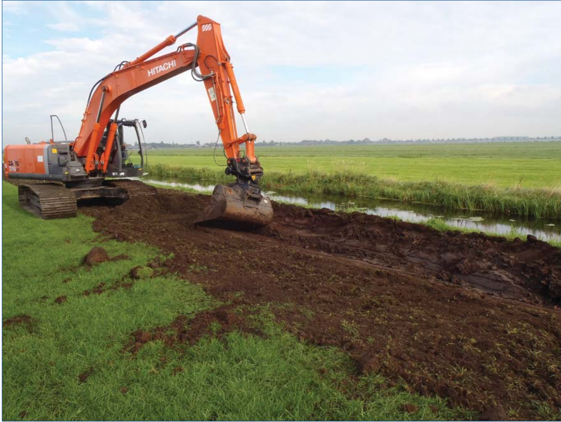
Figuur 4. Overzicht van de werkzaamheden op locatie 2: verbreden van de sloot met kantelbak en zeer flauw talud.
