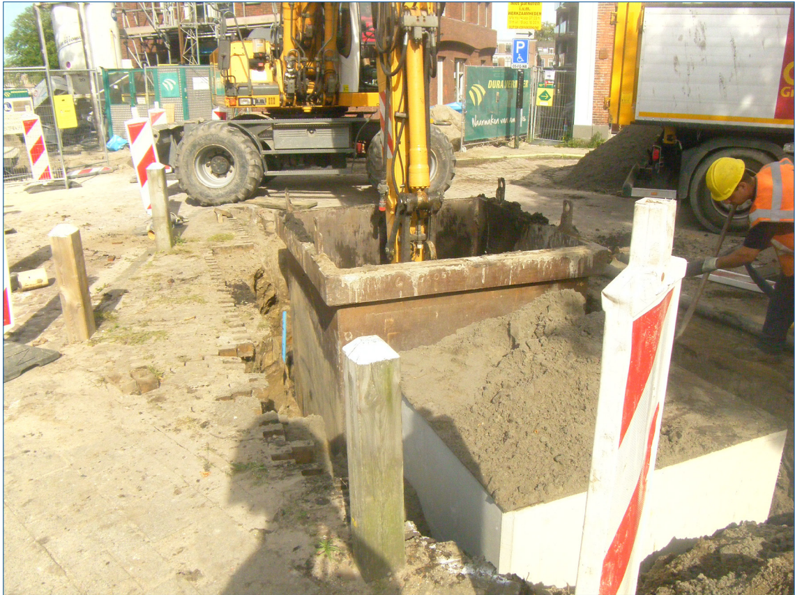
Figuur 8. Overzicht van de werkzaamheden, aanleg van de container binnen de graafmal op locatie H01 (Harmenjansweg 23).
