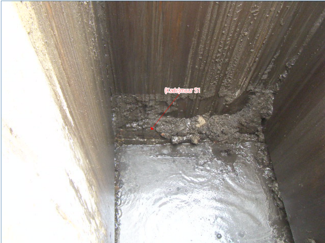
Figuur 12. Overzicht van de kademuur (S1), die bij de werkzaamheden op de Houtmarkt (locatie SD03; WP3) is gevonden.
