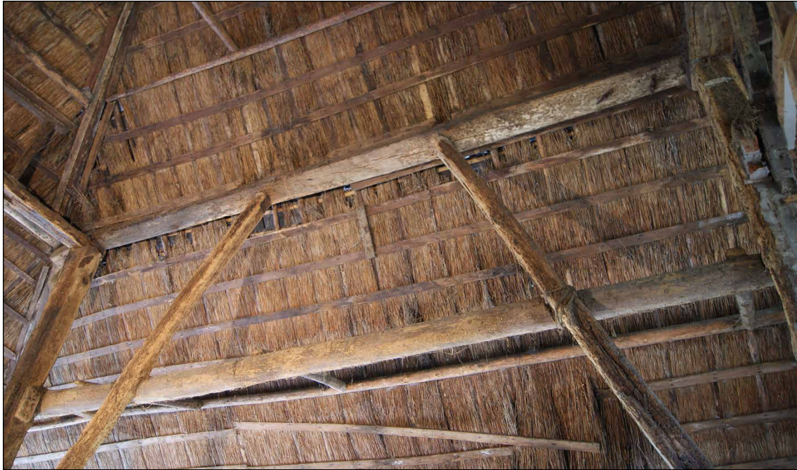
Afb. 81 De bovenbalk aan de zuidkant. Op een lager niveau de jaagbalk.
