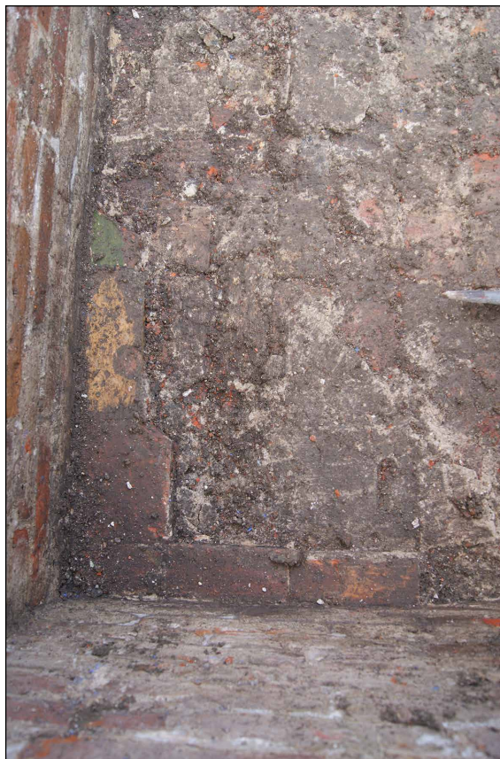
Afb. 129 Restant van de plavuizen vloer in de kelder, van boven gezien.
