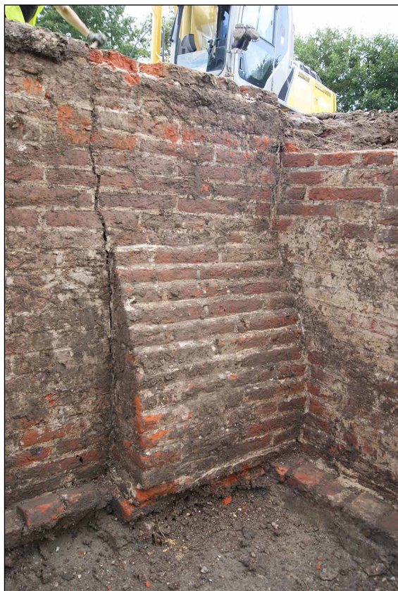
Afb. 130 De oostmuur van de kelder, om waterkelder S26 heen gebouwd.
