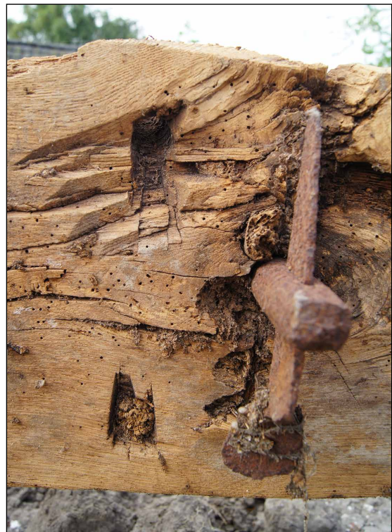
Afb. 85 Twee vlotgaten in de oostkop van de noordelijke bovenbalk. In een van de gaten zit een houten pen.
