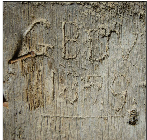
Afb. 100 GBDV 1879 op een van de stijlen.
