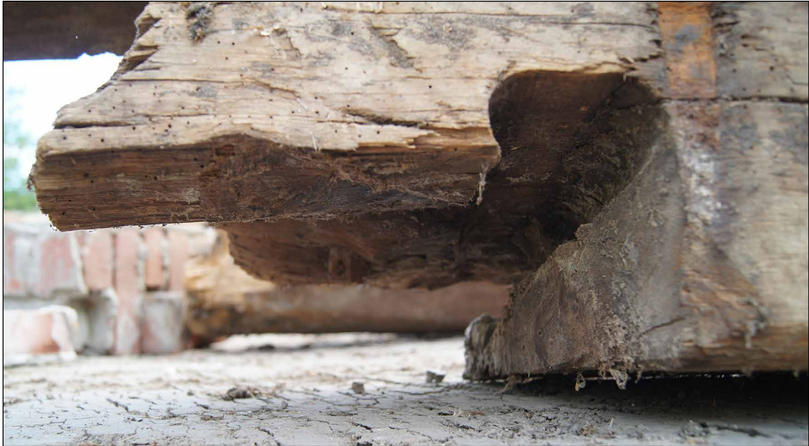
Afb. 105 Een van de sleufgaten. Het gat is schuin in de balk aangebracht.
