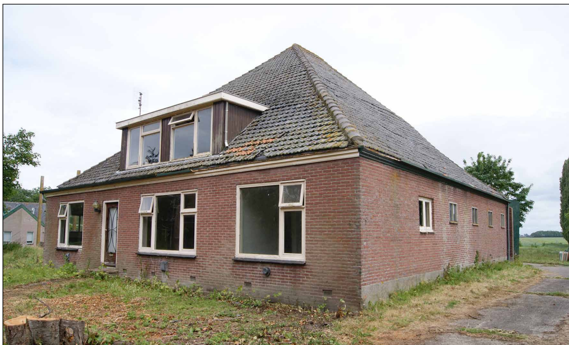
Afb. 60 Voor- en zuidelijke zijgevel van de stolp in 2015.
