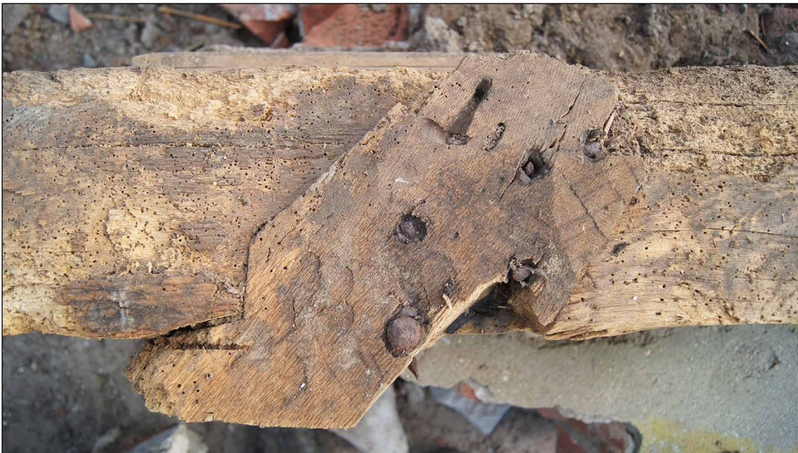
Afb. 91 Een lipverbinding met hak van een zwing op de oostelijke dekbalk.
