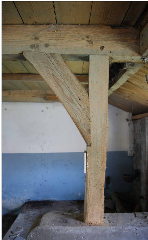
Afb. 67 Koestijl met zolderbalk en korbeel, met elkaar verbonden met een pen-gatverbinding en toognagels.
