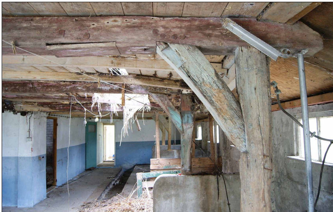
Afb. 68 Zolderbalk in de stal met dichtgemaakt pengat en toognagels (links), een aanwijzing voor secundair gebruikt hout.
