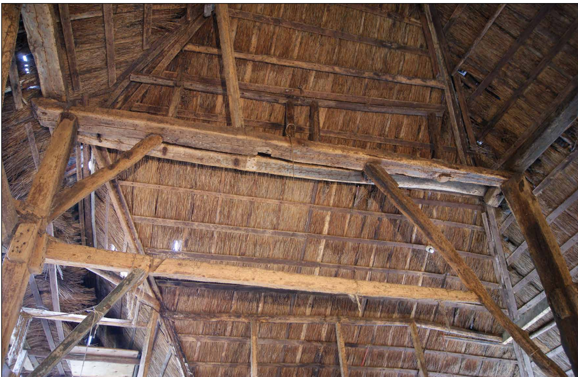
Afb. 78 De dekbalk aan de oostkant. Half erachter is de overstekbalk zichtbaar. Op een lager niveau bevindt zich nog een horizontale balk, de jaagbalk.
