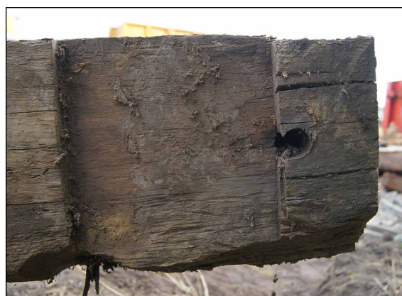
Afb. 89 Inkeping in de bovenkant van de verlengde bovenbalk. In de inkeping lag de overstekbalk. Beide balken waren verbonden door middel van een ijzeren spiebout. De spiebout is hier verdwenen, maar het ronde gat is nog zichtbaar.
