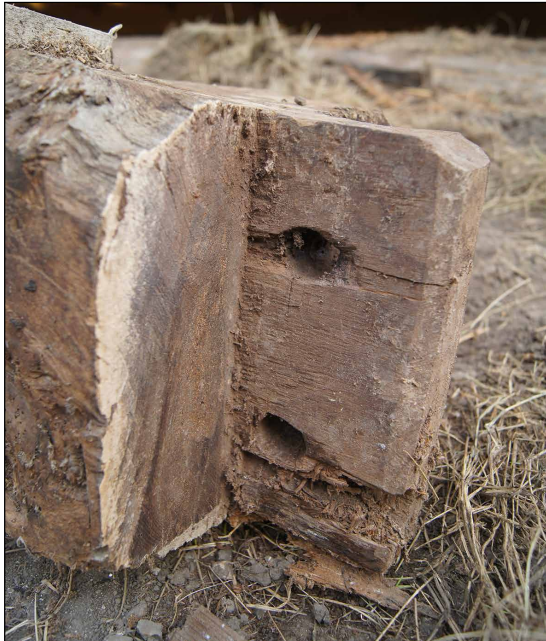
Afb. 76 Rechthoekige pen aan de bovenkant van een stijl, met twee ronde gaten voor toognagels.
