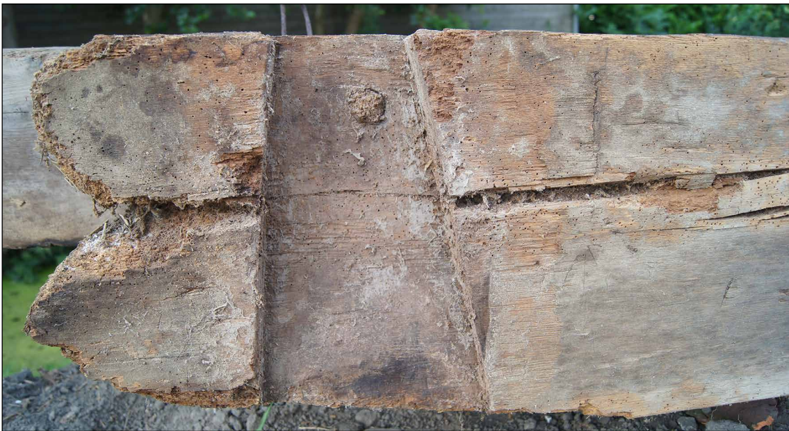
Afb. 82 Zwaluwstaartvormige inkeping in de onderkant van een bovenbalk. In de inkeping een houten pen waarmee de bovenbalk was verbonden met de dekbalk.
