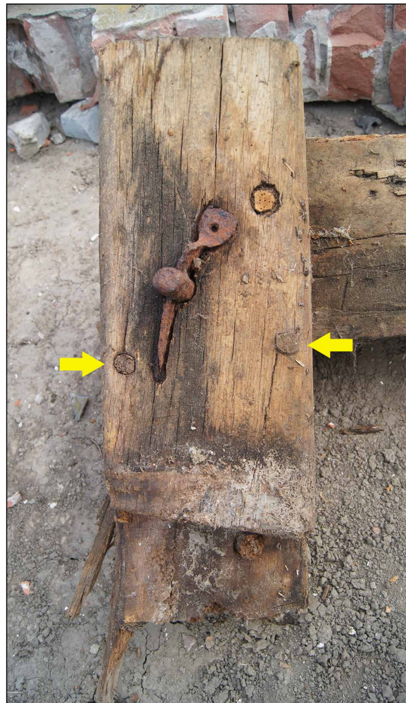
Afb. 106 Vlotpennen in de oostkop van de molenroede. De pen erboven hoort bij de houtverbinding tussen de bovenbalk en dekbalk.
