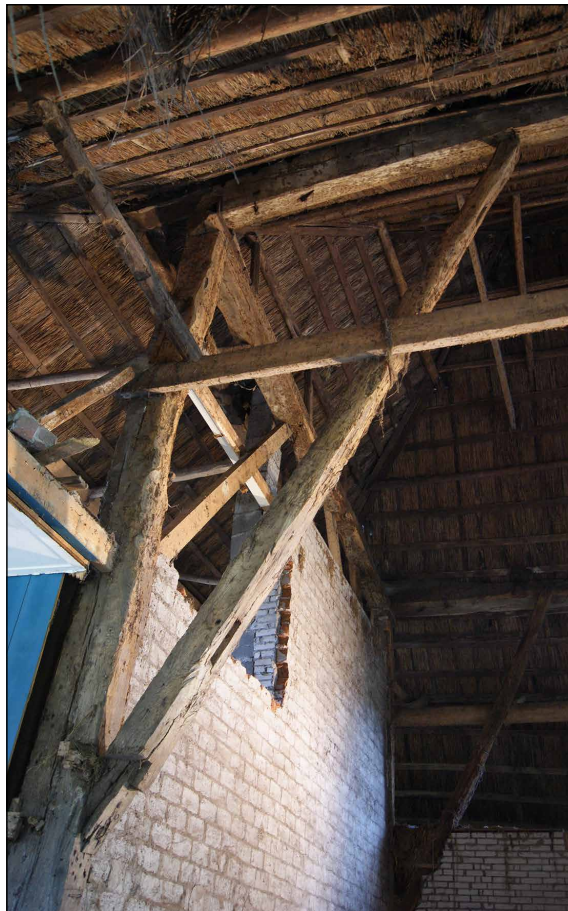
Afb. 94 Zwing van hergebruikt hout aan de zuidzijde.
