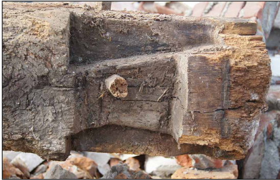
Afb. 83 Zwaluwstaartvormige uitsparing in de bovenkant van de oostelijke dekbalk.
