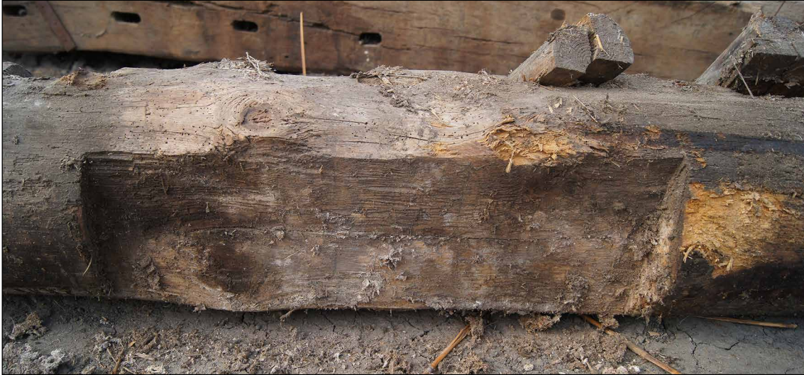
Afb. 90 Brede inkeping in de zijkant van de westelijke overstekbalk. Hier stond tot omstreeks 1980 het rookkanaal in.
