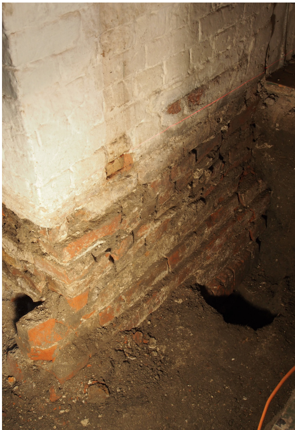
Afb. 29 De fundering van de oostgevel noordelijk gedeelte. Ook aan deze zijde begint de oude fundering op een rollaag en zijn vier lagen daarboven bewaard gebleven; dan volgt de uitlijnlaag en het nieuwere muurwerk.
