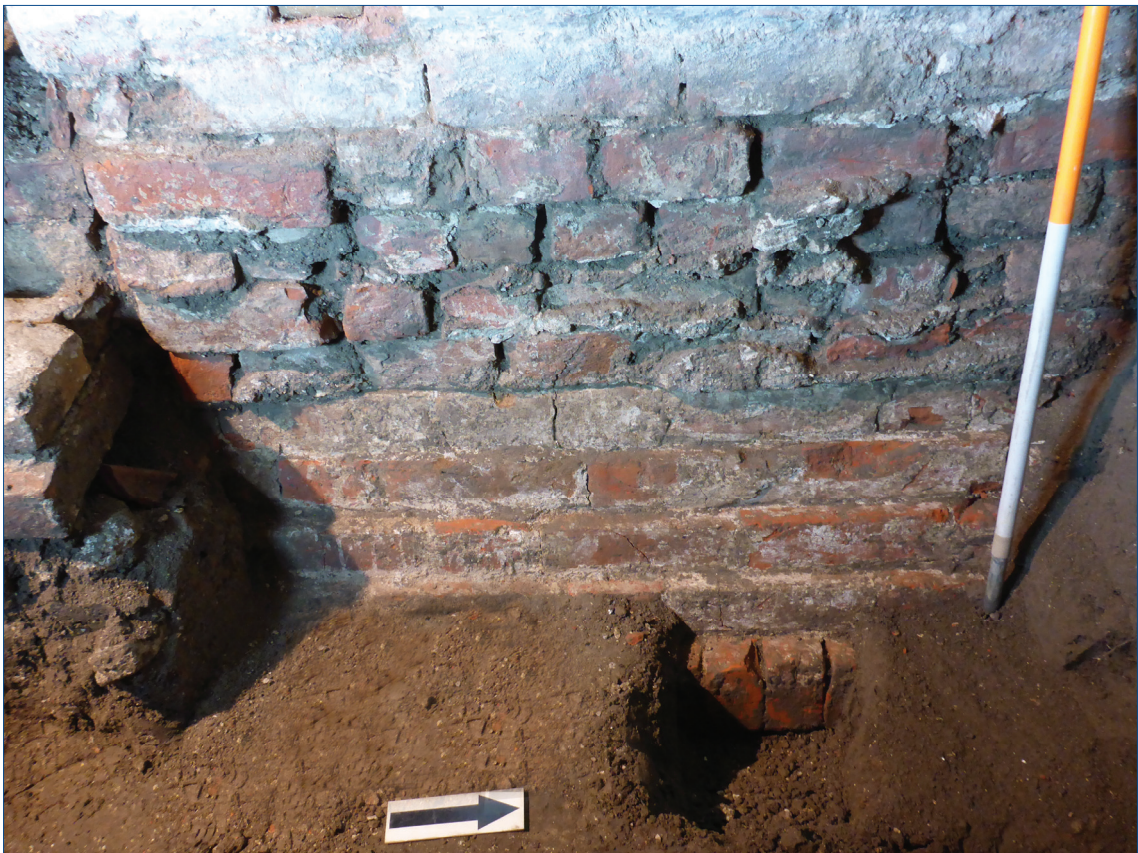
Figuur 4. Middeleeuwse fundering van de oostgevel van de toren.
