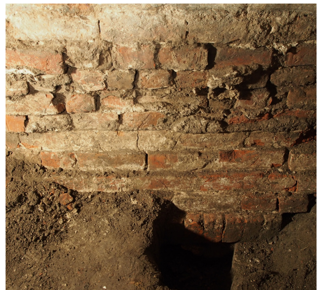
Afb. 29 De fundering van de oostgevel noordelijk gedeelte. Ook aan deze zijde begint de oude fundering op een rollaag en zijn vier lagen daarboven bewaard gebleven; dan volgt de uitlijnlaag en het nieuwere muurwerk.
