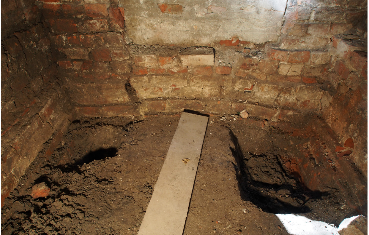
Afb. 25 Binnenkant fundering westgevel. De oude fundering is niet doorbroken voor een deur. Een laag boven de uitlijnlaag begint de onderkant van een vulling die onder de huidige deur zit.
