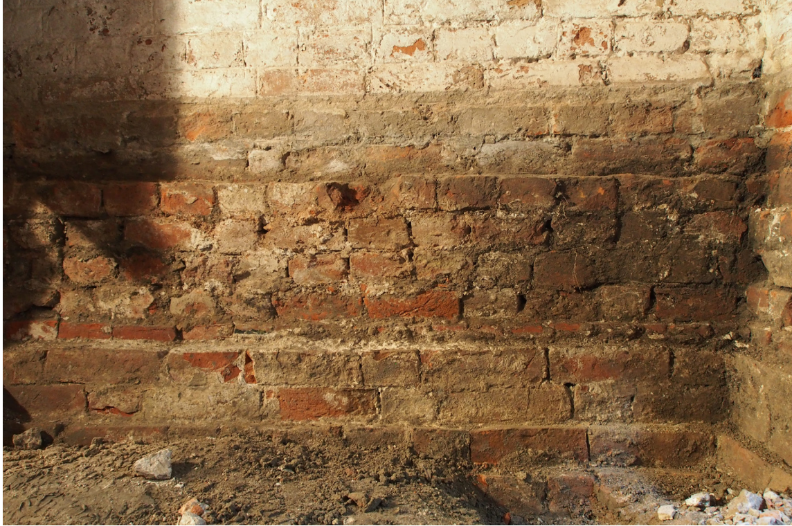
Afb. 22 Binnenkant fundering zuidmuur. Onderaan een rollaag, waarop de onderste 4 lagen vroeg baksteenwerk met versnijdingen, daarboven ziet men de uitlijnlaag met veel plavuizen; dan de 4 lagen met metselbaarden die eindigen met een versnijding en dan het strakkere werk met afwisselend koppen en strekken lagen.
