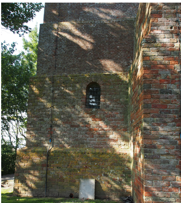
Afb. 21 De zuidgevel. Ook hier is veel vernieuwd. Boven de buitenschil van kloostermoppen zitten kleinere bruine stenen.
