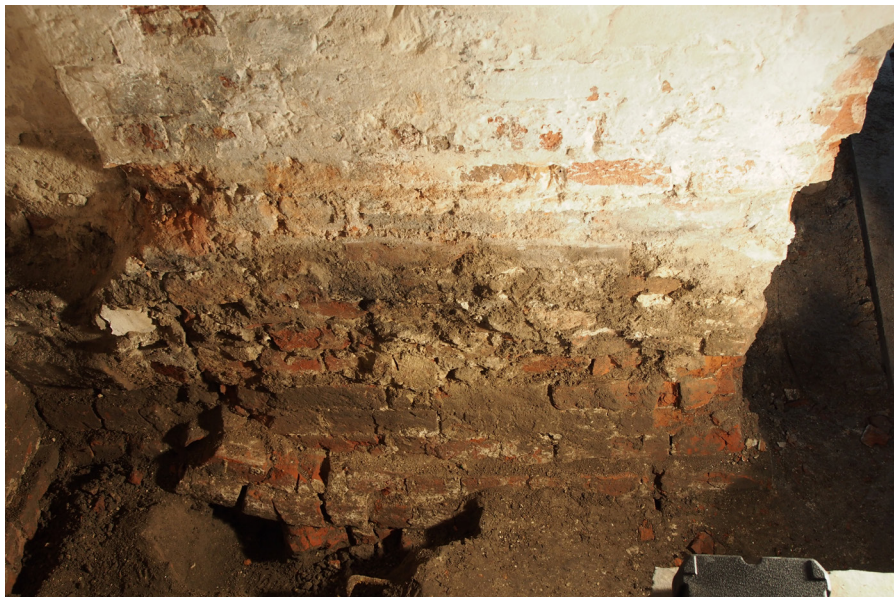
Afb. 36 Fundering oostgevel zuidelijk gedeelte. Boven de rollaag zitten 5 oude lagen. Verder is de opbouw gelijk aan de andere waargenomen gedeelten.
