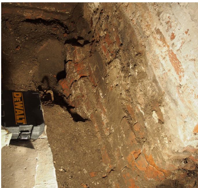
Afb. 33 Het zuidelijk gedeelte van de oostgevel van de toren met de binnenkant van de opening. Aan de zuidelijke binnenkant van de opening gaat een schil van het oude metselwerk nog wat hoger door.
