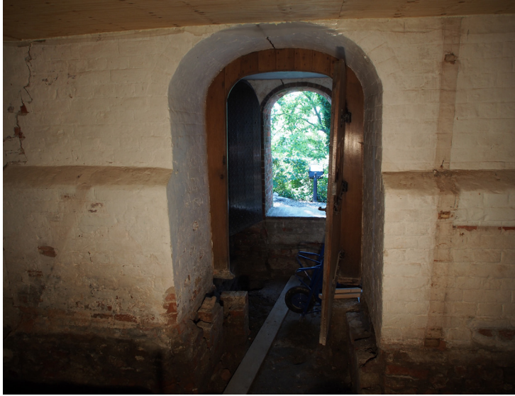
Afb. 27 De oostgevel aan de kerkzijde. De korbboog van de ingang komt overeen met die van de westgevel. Ook hier vrij regelmatig metselwerk van afwisselend koppen en strekkenlagen.
