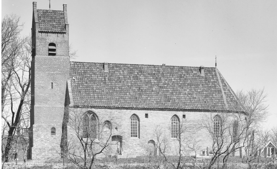
Afb. 4 Overzicht kerk en toren vanuit het zuiden in 1966 na de restauratie. Het is duidelijk te zien dat veel metselwerk van de toren is vernieuwd Foto RDMZ
