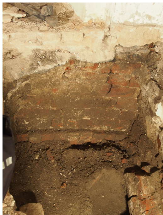
Afb. 38 Fundering oostgevel toren zuidelijk gedeelte: detail bij de aansluiting op de westgevel van de kerk. De uitlijnlaag wordt duidelijk dikker naar het zuiden, hetgeen bewijst dat de toren al voor de wederopbouw naar het zuiden is gezakt.
