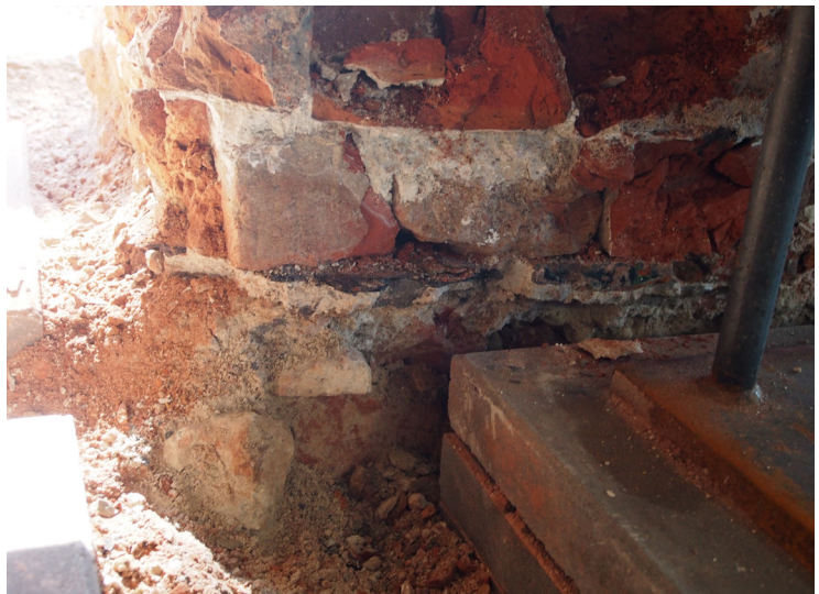
Afb. 24 Restant van de vulling van de zuidmuur. Er is een veldkeitje zichtbaar dat onderdeel was van de vulling van de fundering. Daarboven ziet men een restant van een tegel die onderdeel is van de uitlijnlaag.
