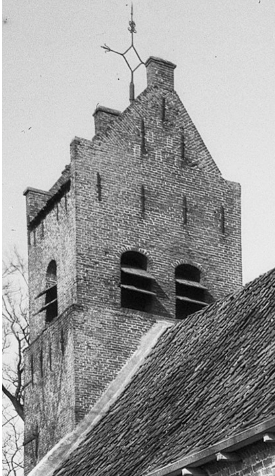
Afb. 16 De toren vanuit het zuidoosten. Men ziet nog de dichtzettingen van duivengaten in de topgevel van de toren. (uitsnede foto RDMZ Delemarre 1960).
