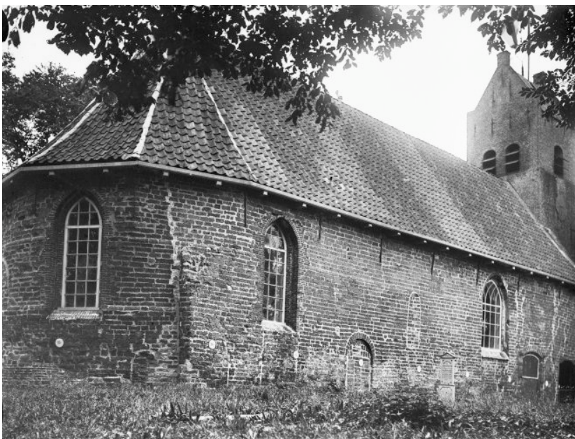
Afb. 15 De kerk vanuit het noordoosten; aan de noordkant van de toren ziet men een vulling waar vroeger een wijzerplaat heeft gezeten (foto Kramer datering?)
