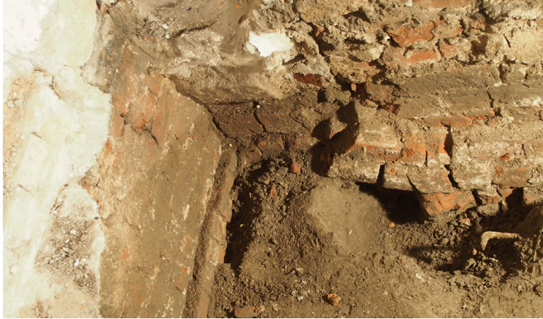
Afb. 40 Fundering zuidgevel kerk. Deze lijkt min of meer in verband te staan met de westgevel van de kerk die ook op een rollaag staat.
