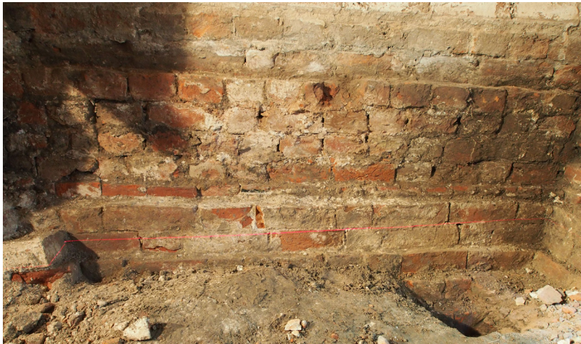
Afb. 23 Binnenkant fundering zuidmuur met horizontale laser waardoor men de goed de zakking naar het westen kan waarnemen.
