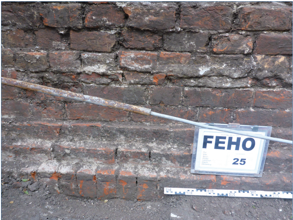
Figuur 6. Middeleeuwse fundering van de noordgevel van de toren.
