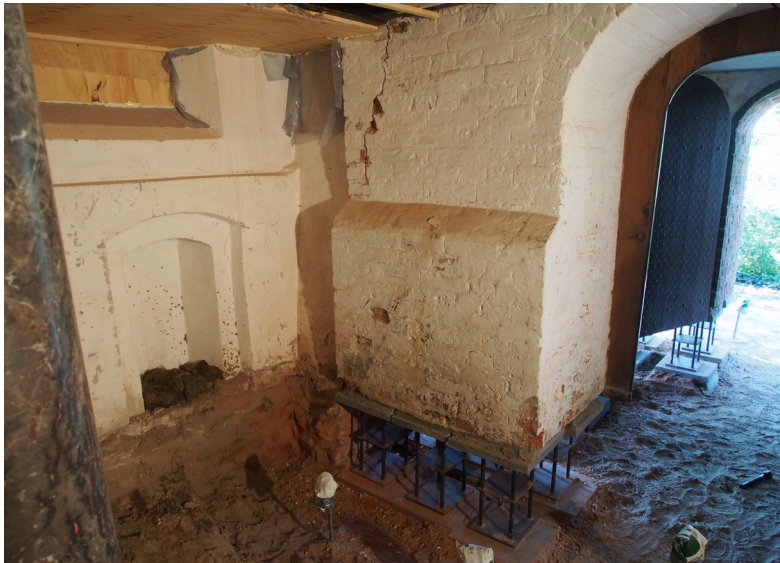
Afb. 32 Het zuidelijk gedeelte van de oostgevel van de toren aan de kerkzijde en het aansluitende deel van de west- en zuidgevel van de kerk. In de zuidgevel zit de nis van het dichtgezette spleetvenster. Ten tijde van het maken van deze foto was de toren al deels op stoeltjes gezet en is de fundering van de oostmuur van de toren verdwenen.
