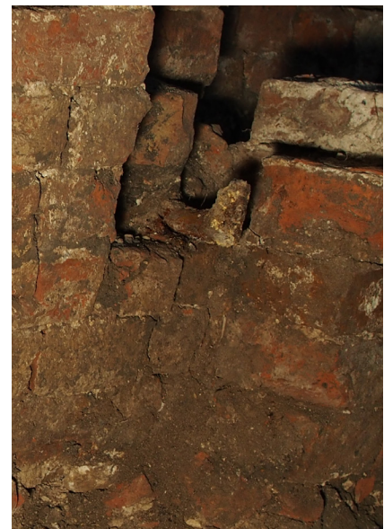
Afb. 33 Het zuidelijk gedeelte van de oostgevel van de toren met de binnenkant van de opening. Aan de zuidelijke binnenkant van de opening gaat een schil van het oude metselwerk nog wat hoger door.
