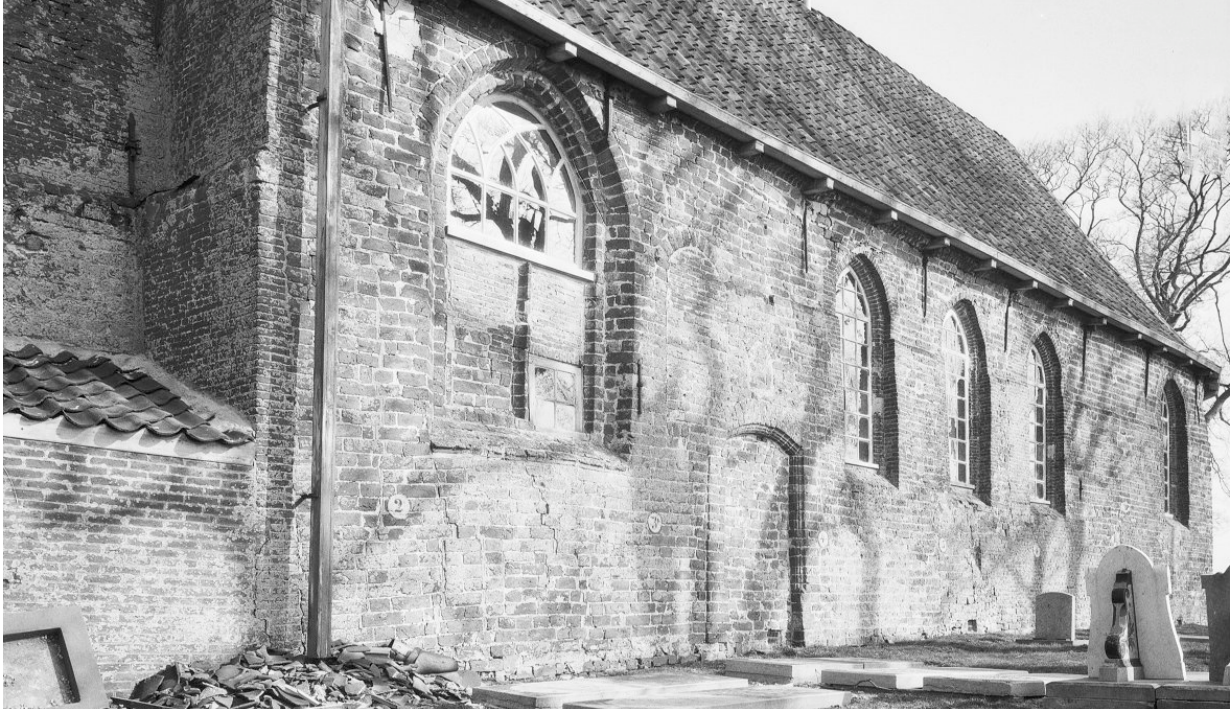
Afb. 13 Overzicht van de zuidelijke kerkgevel kerk in 1960 (RDMZ Delemarre) Vooraan links is nog het baarhuisje en een stuk van de toren en de westgevel van de kerk zichtbaar. In het oostelijke stuk van de onderste geleding van de toren zitten boven het baarhuisje nog kloostermoppen. De westgevel heeft een buitenschil van kleine baksteen. In de westelijke uitbreiding van de kerk ziet men nog het dichtgezette spleetvenster.
