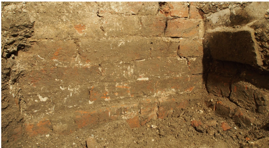
Afb. 41 Fundering zuidgevel kerk detail.
