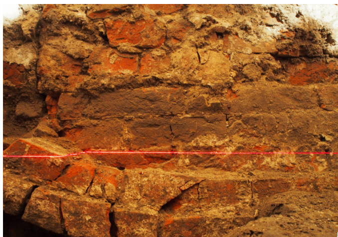
Afb. 38 Fundering oostgevel toren zuidelijk gedeelte: detail bij de aansluiting op de westgevel van de kerk. De uitlijnlaag wordt duidelijk dikker naar het zuiden, hetgeen bewijst dat de toren al voor de wederopbouw naar het zuiden is gezakt.
