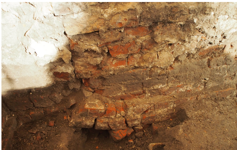
Afb. 37 Fundering oostgevel zuidelijk gedeelte.
