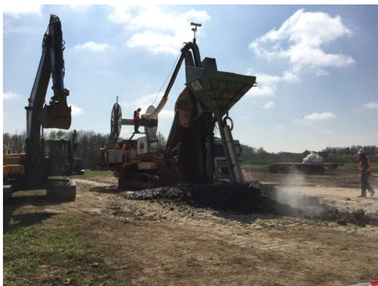
afbeelding 1: Grondfrees t.b.v. inbrenging geotextiel ( op de proeflocatie)
