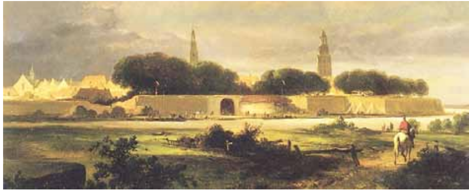
11. De sloop van het Marspoortbolwerk in 1856 (Wouter Verschuur). Geheel rechts het Bourgonjebastion, beter bekend als 'de Bult van Ketjen'.
