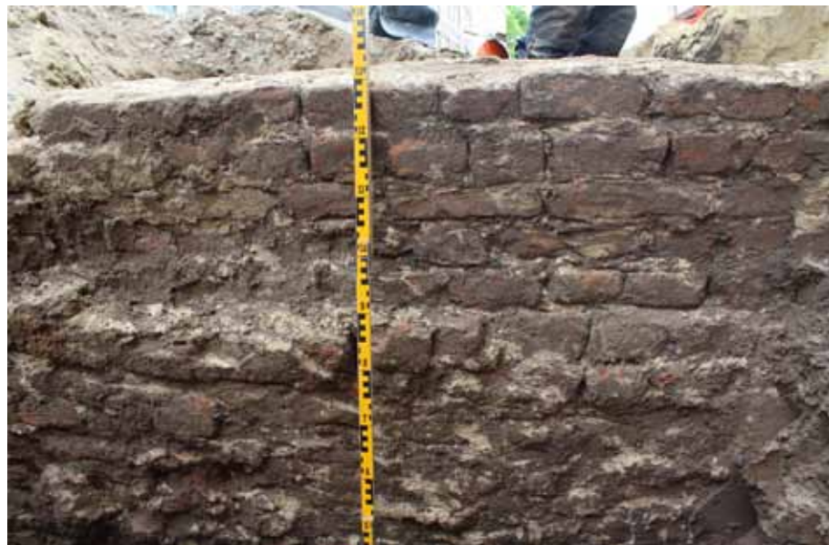
14, 15. Aanzicht van de veldzijde/walkant van het muurwerk. Hier is duidelijk te zien dat het muurwerk versmalt aan de bovenzijde. Op de onderste foto is goed te zien dat verschillende steenformaten door elkaar zijn gebruikt, en dat het muurwerk aan de onderzijde slecht is afgewerkt.
