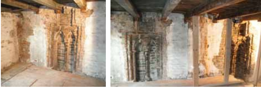
10, 11. Dichtgemetselde Romano-gotische vensters in Groenmarkt 3. Oorspronkelijk was dit de buitenkant van het nu gesloopte huis Groenmarkt 1.
