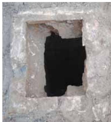
19-23. De waterput op de Groenmarkt. Linksboven afdaling door het nauwe mangat (linksonder). Rechtsboven de rechte schacht bovenin met daarlangs de loden pijp voor de pomp. Rechtsonder de uit meerdere gewelven samengestelde koepel boven de brede ronde put onderin.
