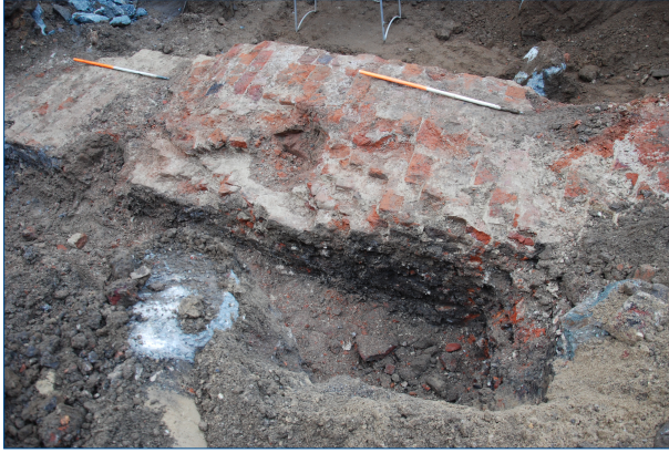
Figuur 3.6. Gestaakte boorgaten (2014) in de muur.
