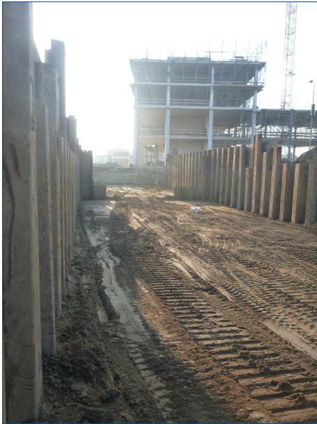
Figuur 3.2. Impressie van de bouwput op 3,5 m -Mv.
