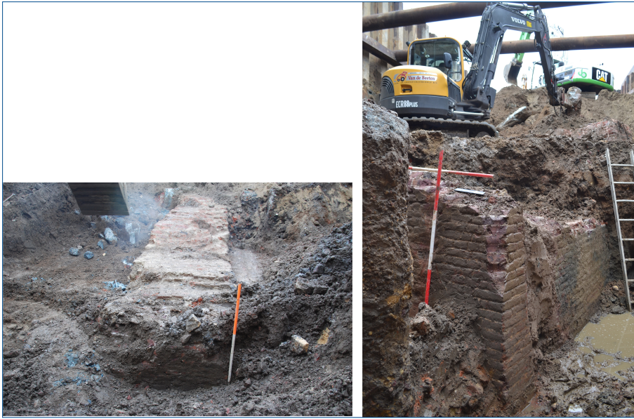
Figuur 3.4. Zij-aanzichten van het muurwerk.
