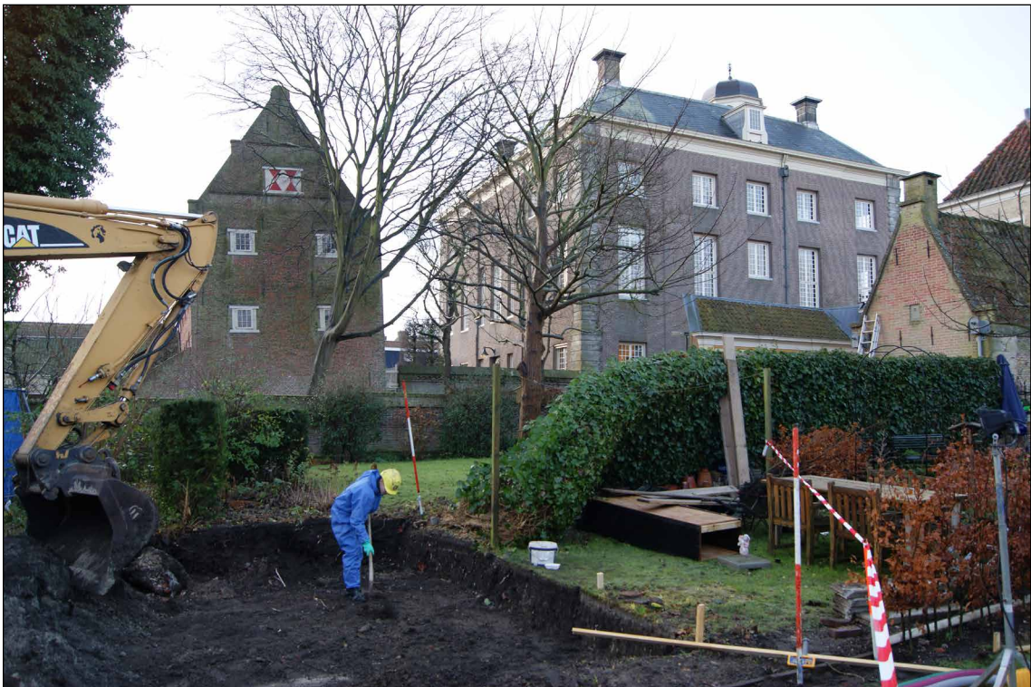
Afb. 10 De graafwerkzaamheden in volle gang. Op de achtergrond het stadhuis (rechts) en de Stadsgevangenis (links).
