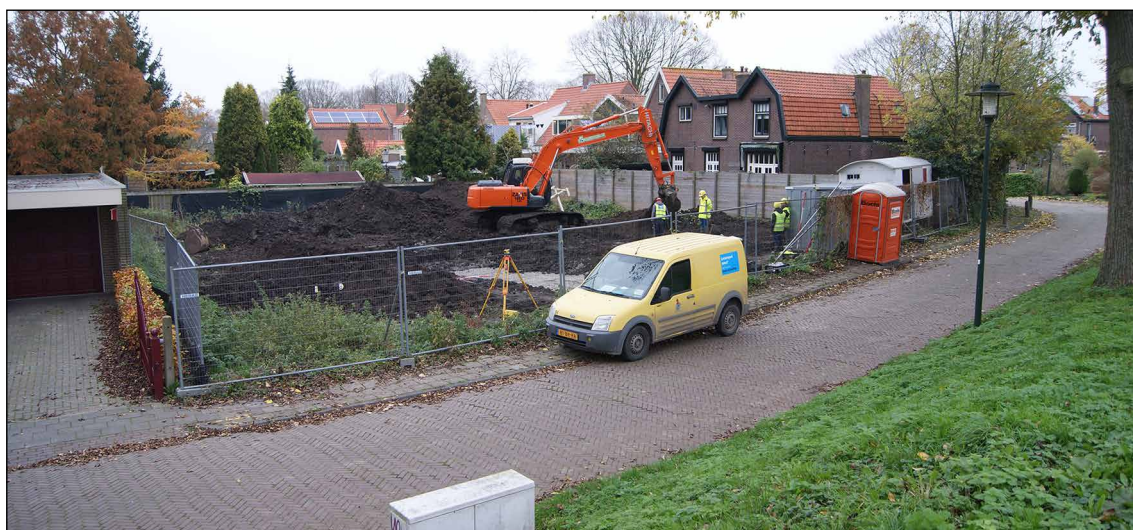
Afb. 9 De opgraving gezien vanaf de Omgelegde Burgwal.
