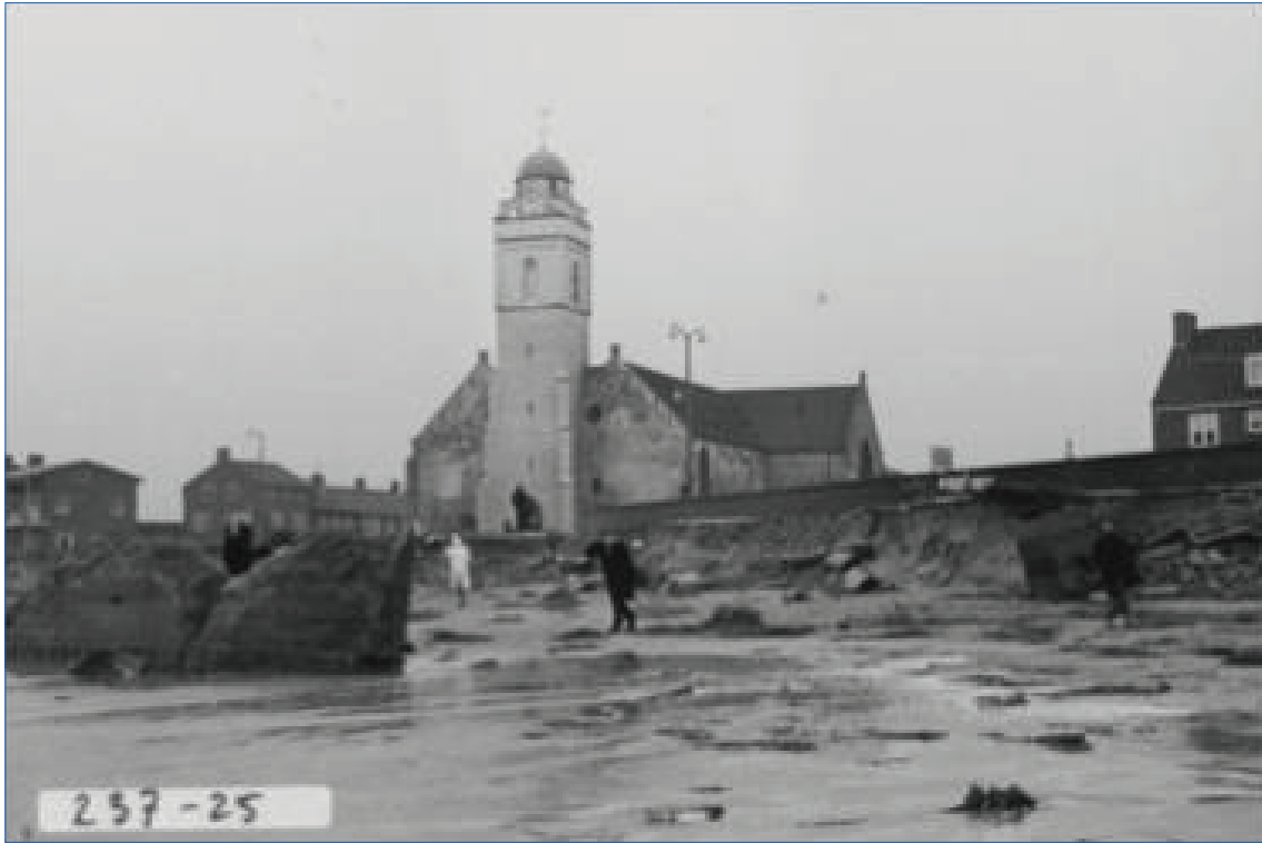
Figuur 6.12. De kustafslag als gevolg van de februaristorm in 1953. Op de voorgrond is een omgevallen bunker zichtbaar. Op de achtergrond de witte kerk (bron: www.katwijkinoorlog.nl ).
