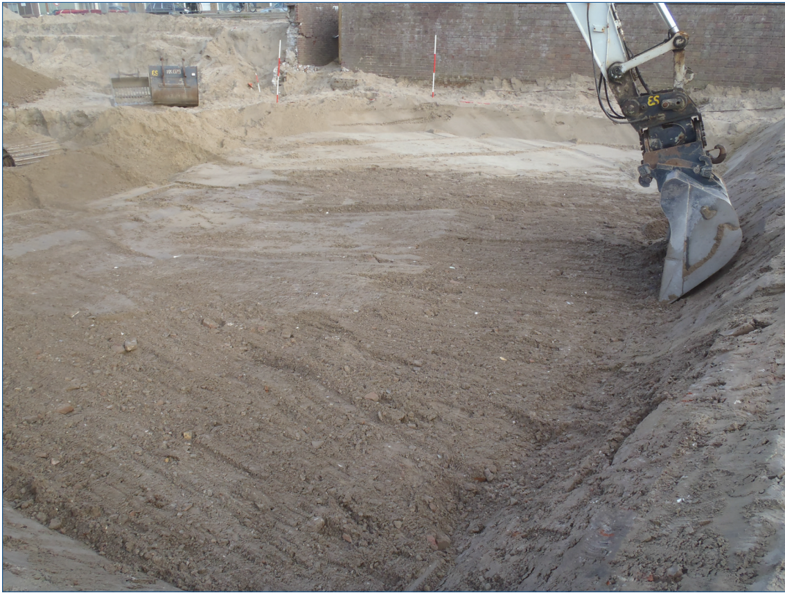
Figuur 6.2. De subrecente verstoring (S 1100: de bruine puinhoudende laag op de voorgrond) tijdens het uitgraven van de bezinkput.
