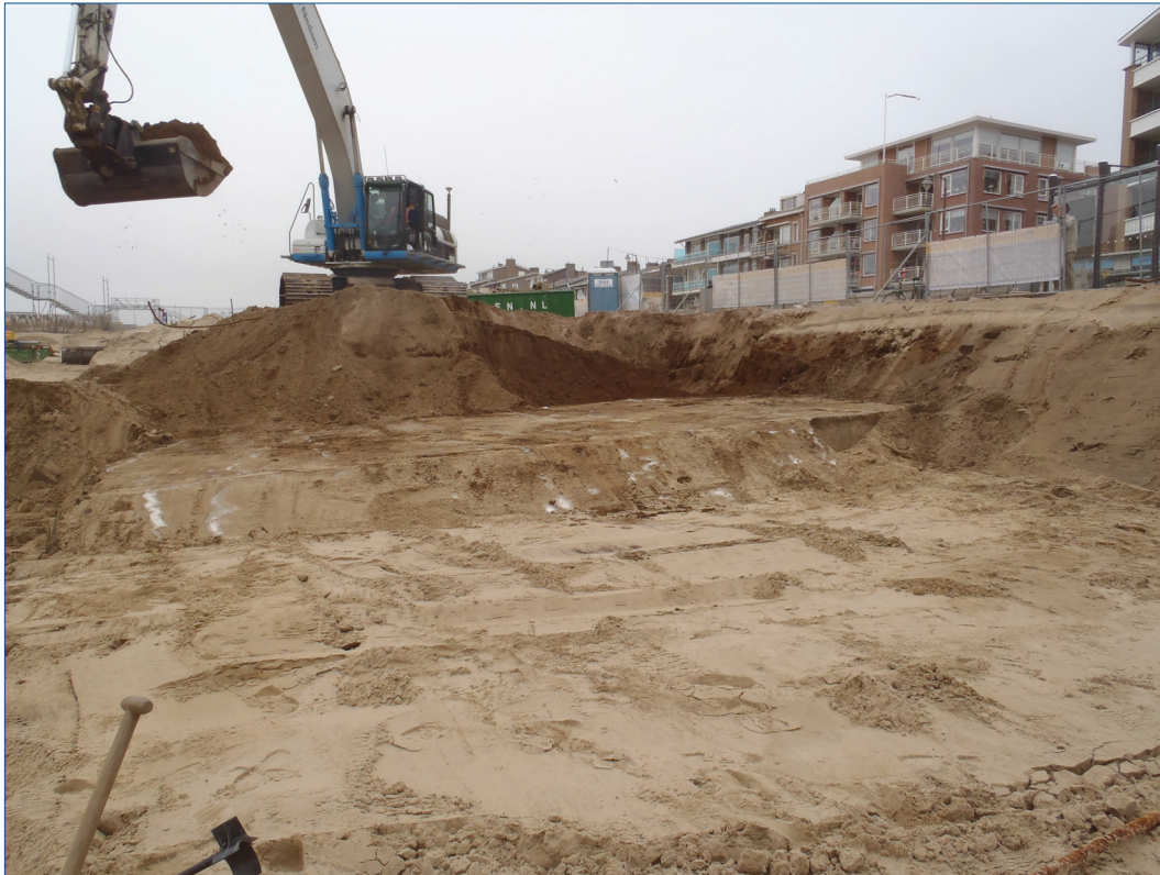
Figuur 5.3. Resten van één van de structuren uit 1946, in dit geval een botenhelling.
