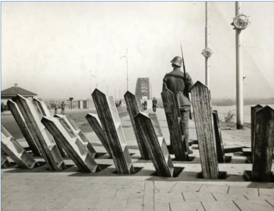
Figuur 5.12. Voorbeeld van een aspergeversperring in gebruik. In dit geval één van de Nederlandse aspergeversperringen die op de Waalbrug bij Nijmegen in gebruik waren en bij onderzoek aldaar zijn gevonden (bron: Flokstra, 2015).
