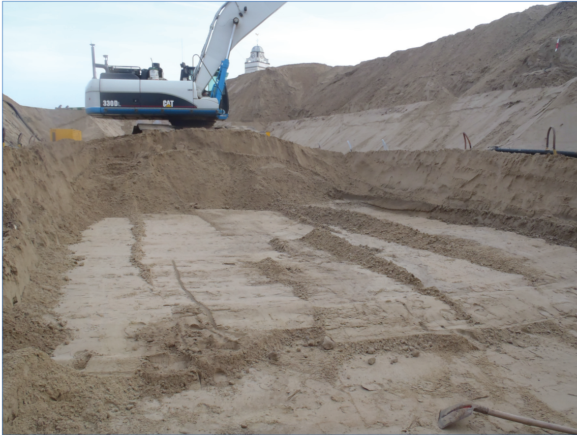
Figuur 4.5. Overzicht van de werkomstandigheden en werkput tijdens de archeologische begeleiding. De werkput is hier vrijwel op diepte. Op de achtergrond is de toren van de Witte Kerk nog herkenbaar.
