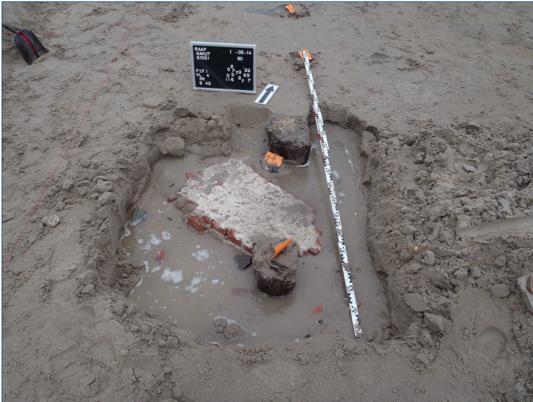
Figuur 5.17. Puinbros (S 24), dat ter versteviging aangebracht is tussen twee palen van de zeewering uit 1702.
