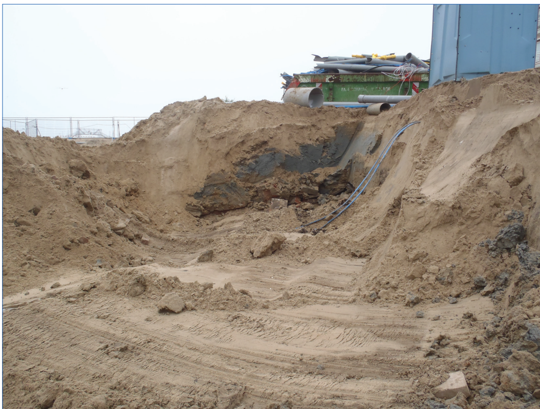
Figuur 5.2. De na de februaristorm van 1953 aangebrachte kleilaag (S 1100) in het profiel van de ontgraving.
