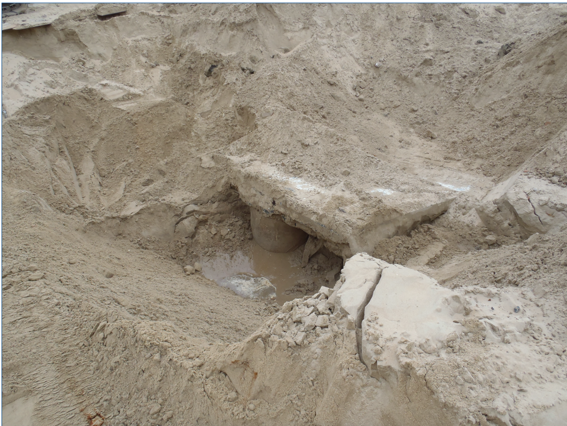
Figuur 5.6. Onderste deel van de fundering van de boulevardmuur uit 1950.
