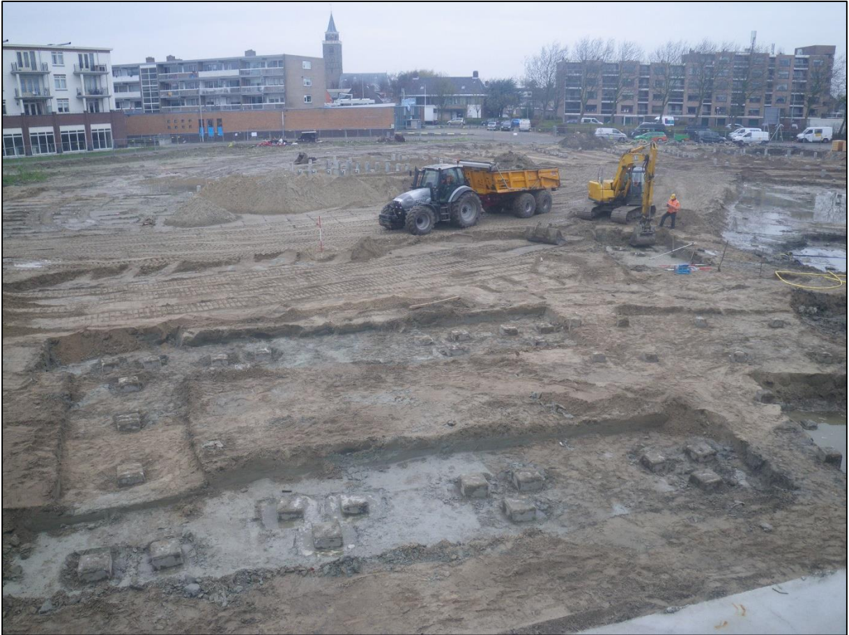
Figuur 2: Impressie van de begeleiding. Werkput 11 en 12 op de voorgrond.
