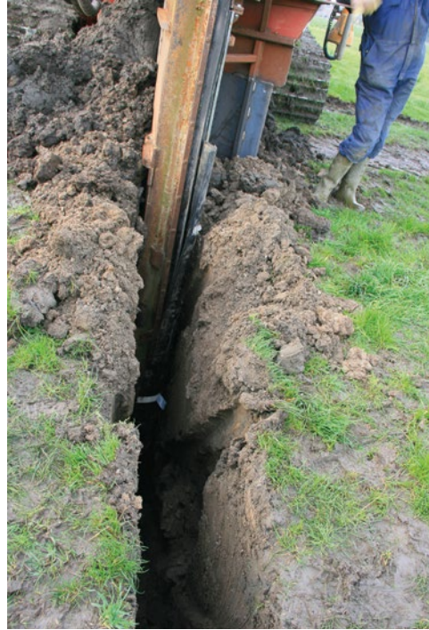
Afb. 7.5 De grondfrees trekt een sleuf van 30 cm breed. (foto B.P. Speleers)
