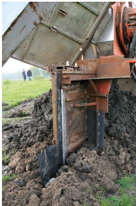
Afb. 7.4 Het plastic folie zit in de grond. (foto B.P. Speleers)
