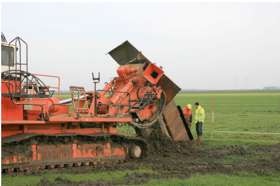
Afb. 7.3 Een grondfrees plaatst plastic folie rond het scheepswrak (foto B.P. Speleers)
