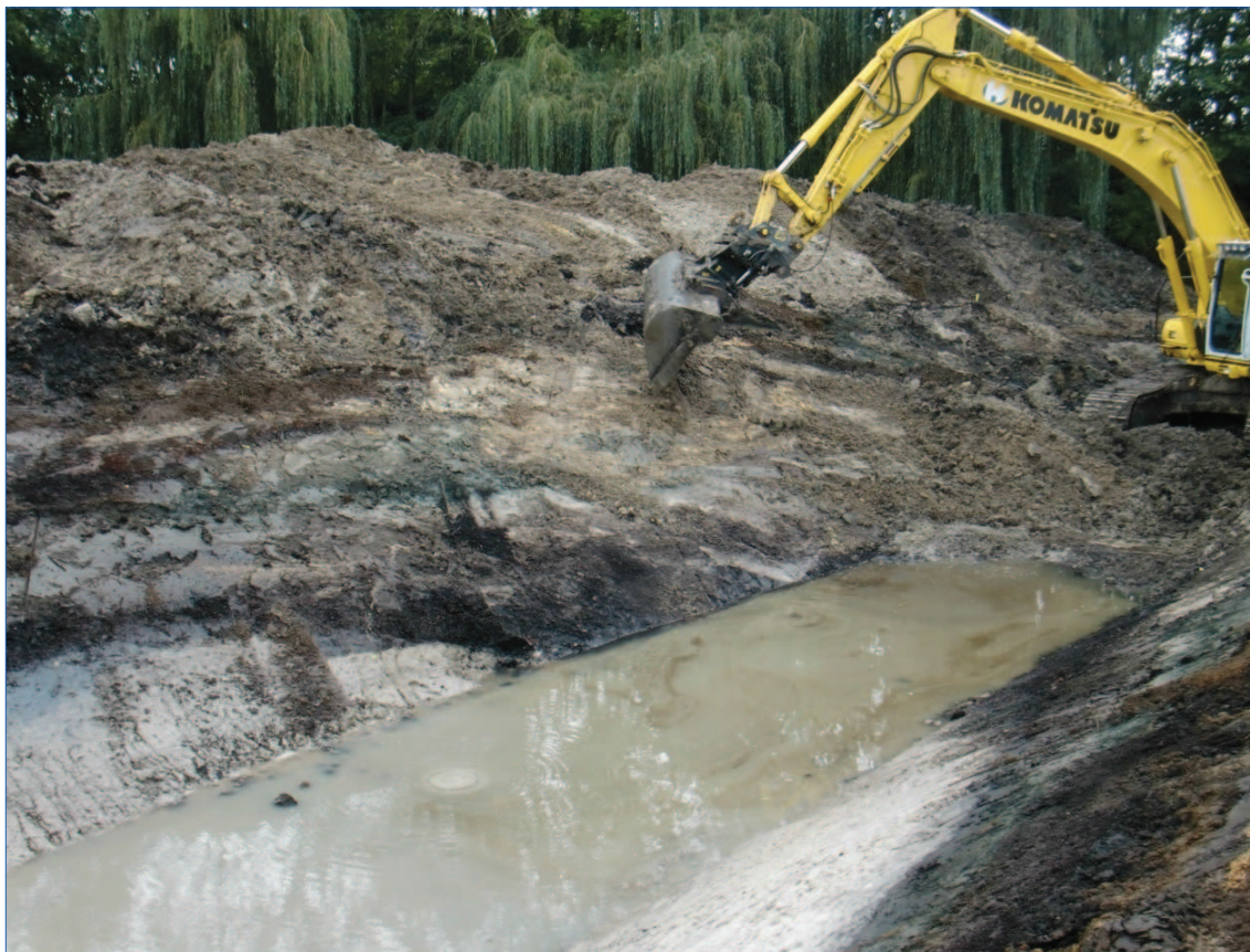
Figuur 4. Deel van de voormalige beekmeander met een recente vulling.
