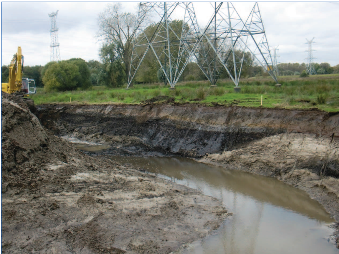
Figuur 8. Oude beekafzettingen nabij de gracht. De duidelijk ingesneden, meest recente meander met humusrijke vulling is ingemeten en aangegeven op figuur 5.
