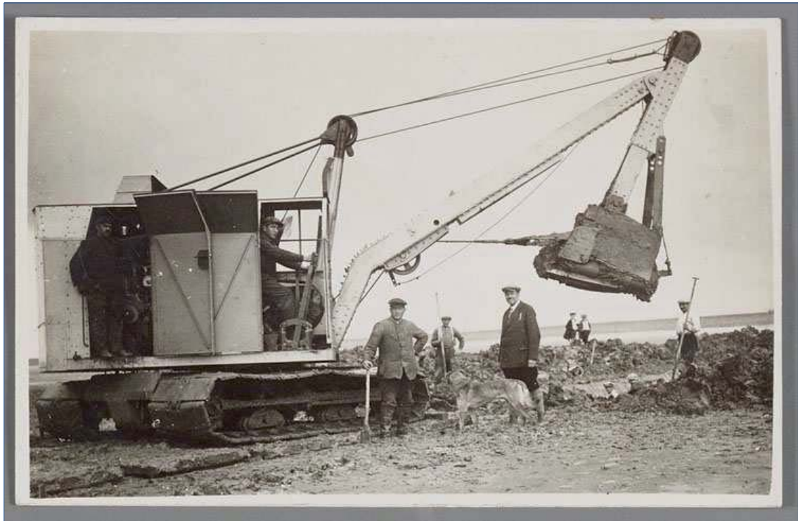
Figuur 23. Foto van een kraan bij de ontginning van de Wieringermeerpolder, met daarin een katrol zoals aangetroffen bij het huidige onderzoek (V10). Bron: www.geheugenvannederland.nl/?/nl/items/ZZM01:F022366 .
