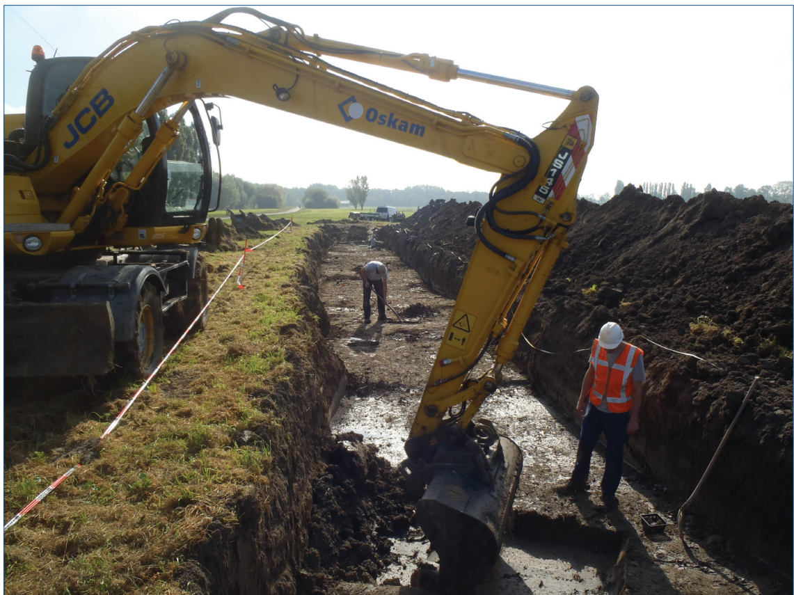
Figuur 4.3. Overzicht van de werkzaamheden in WP2, waarbij op de voorgrond één van de greppels wordt gecoupeerd met de graafmachine.
