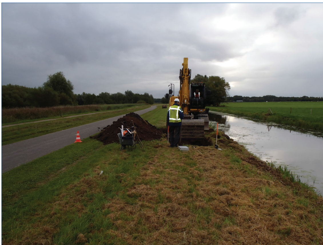
Figuur 4.2. De aanleg van het vlak in WP1. Hier is ook duidelijk de beperkte ruimte zichtbaar, die beschikbaar was voor het aanleggen van de proefsleuf en de uitgekomen grond.
