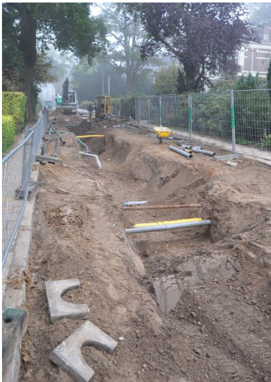
Figuur 2. Ontgraving van de leidingsleuf.
