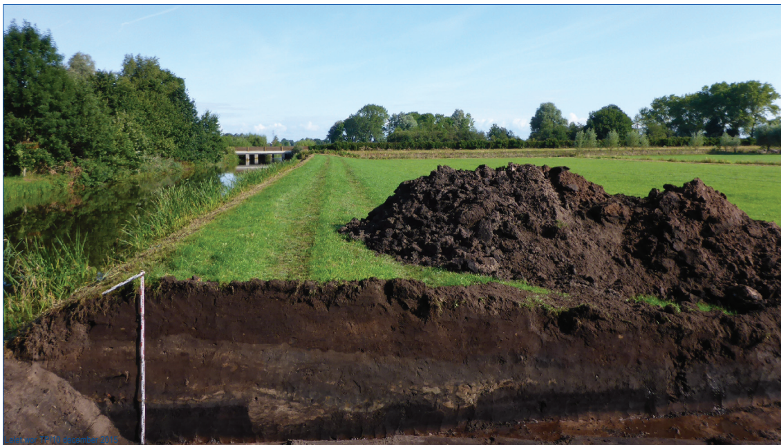
Figuur 4. De kadedoorsnede in WP 2.
