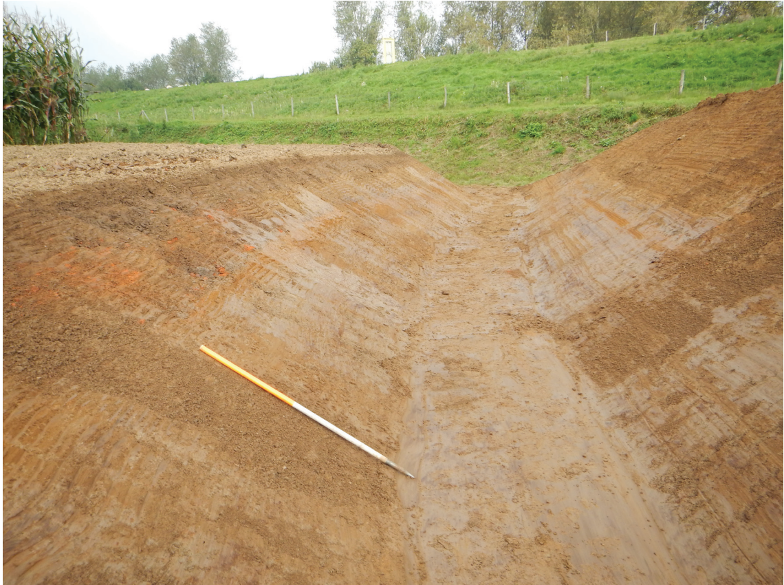
Figuur 10. Puinlaag in profiel van nieuwe sloot in deelgebied N280.
