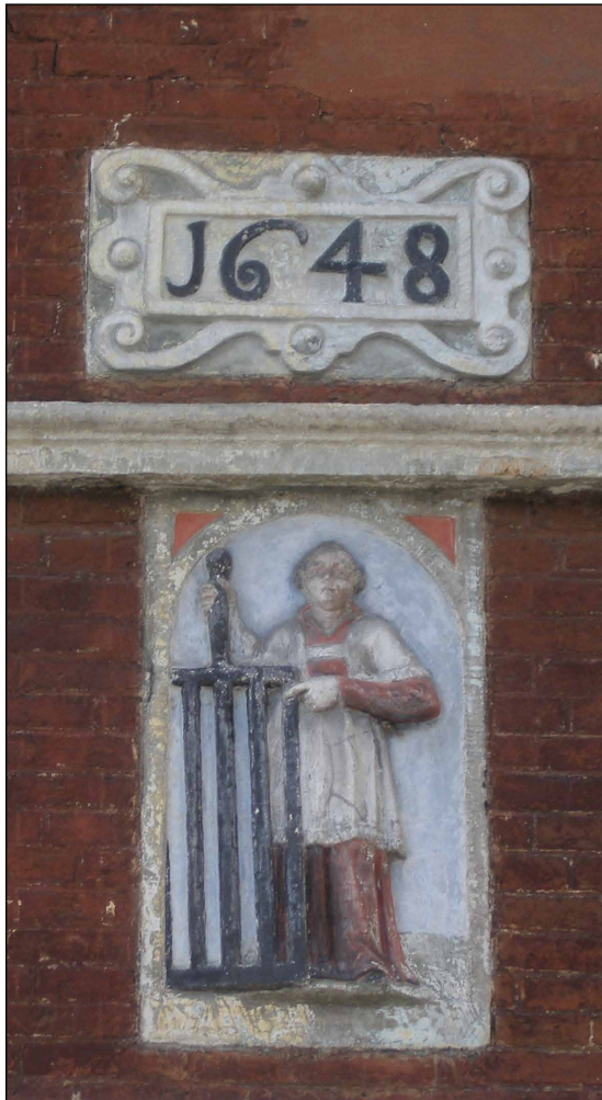
6. Gevelsteen van St. Laurentius met daar boven een jaartalsteen uit 1648 in de gevel van Koepoortsweg 5.
