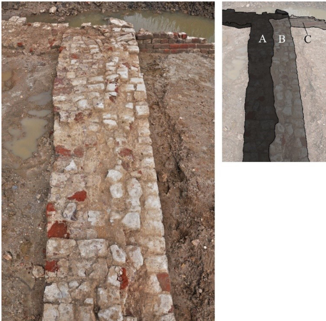
Figuur 9.10 Dezelfde muur als in de vorige afbeelding, maar nu gezien in oostelijke richting. Bij A het oorspronkelijke metselwerk van het bruggenhoofd. Bij B het metselwerk dat na de sloop van de gewelven tot stand is gekomen en bij C het metselwerk behorend bij de vulmuur, die na het verwijderen van de gewelven onder de boog in de noordgevel van de brug zijn geplaatst.
