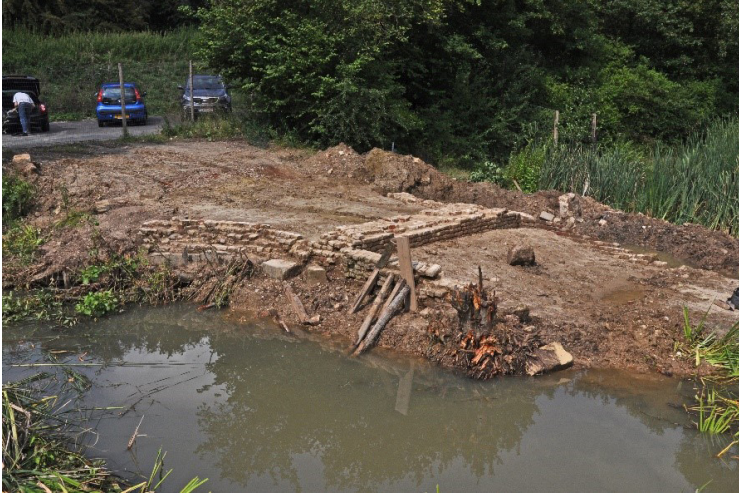
Figuur 9.6 Overzicht van het noordelijke deel van de brug. Bij A is het originele metselwerk van het bruggenhoofd. B zijn de beide sluitmuren, die geplaatst zijn na het wegvallen van de overwelling. De beide muren verkeren in een slechte toestand, de voorste halve steen is vrijwel volledig verloren gegaan. Alleen bij C is nog een klein deel van het oorspronkelijke geveloppervlak bewaard gebleven. Bij D is nog net een klein deel van de eerste brugpijler zichtbaar.
