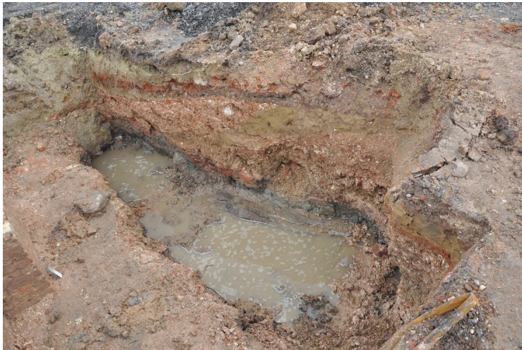
Figuur 9.31 Overzicht van de zuidelijke werkput binnen het poortgebouw, gezien naar het zuidwesten. In de westwand van de werkput is een klein deel van de fundering van een ouder gebouw teruggevonden. Het metselwerk daarvan is bij A zichtbaar. Dit metselwerk was vermoedelijk geplaatst op houten kespen, waarvan er bij B één te zien is. Behalve de hier afgebeelde kesp zijn geen andere exemplaren aangetroffen, zodat het niet zeker is dat overal kespen waren toegepast. De plaats en richting van de resten sluiten echter wel goed aan op de in het laatste kwart van de vorige eeuw vrijgelegde funderingen. Ook het afwijkende metselwerk in de oostwand van het poortgebouw zal vermoedelijk verband houden met de oudere bebouwing ter plaatse.
