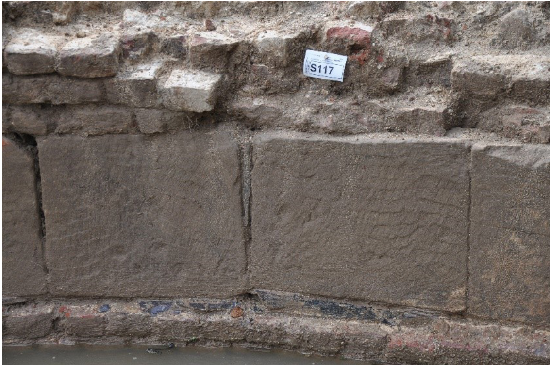
Figuur 9.14 Detail van de waterlijst. Onder de blokken zijn leien zichtbaar. Hiermee zijn de blokken gesteld. De voorzijde van de blokken zelf is voorzien van een onregelmatig uitgevoerde frijnslag.
