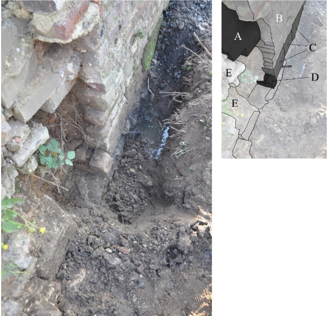
Figuur 9.23 Detail van de westelijke aansluiting van de brugconstructie op de poortoren. Het metselwerk ter plaatse van de brug sprong uit ten opzichte van de noordgevel van de bouwhoeve. Door de sloop-en consolidatiewerkzaamheden en de aanleg van de gracht is de hoeveelheid oorspronkelijk metselwerk sterk verminderd. Bij A is de kern van betonblokken van de consolidatiewerkzaamheden zichtbaar. Het metselwerk bij B is eveneens bij de consolidatie tot stand gekomen, hoewel de grens met het oorspronkelijke werk nog niet kon worden vastgesteld. De natuurstenen blokken bij C behoren wel bij het oorspronkelijke werk (zie hiervoor ook de foto's van vóór de sloop). Het metselwerk bij D is in baksteen uitgevoerd en steekt uit ten opzichte van het geveleppervlak. Vanaf dit punt ontbreekt ook het natuursteen. Dit is de overgang naar het vooruitspringende deel ter plaatse van de brug. Dit deel is ook niet voorzien van natuursteenblokken. Bij E is het oorspronkelijke 17de-eeuwse metselwerk zichtbaar.
