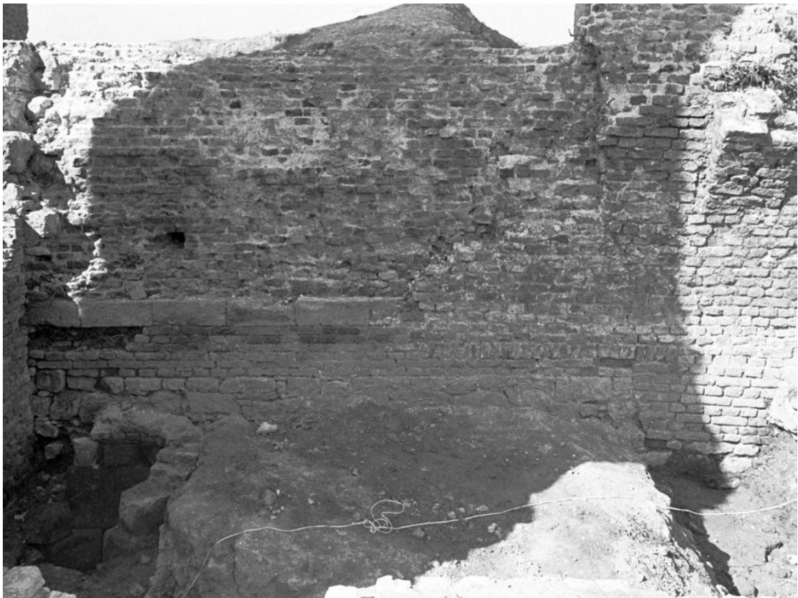
Figuur 6.3 De noordelijke kasteelkelder tijdens de opgraving van TH Delft. Rechtsboven is in de westelijke keldermuur de aanzet van de ingemeten spaarboog (S66) zichtbaar (bron: TH Delft).
