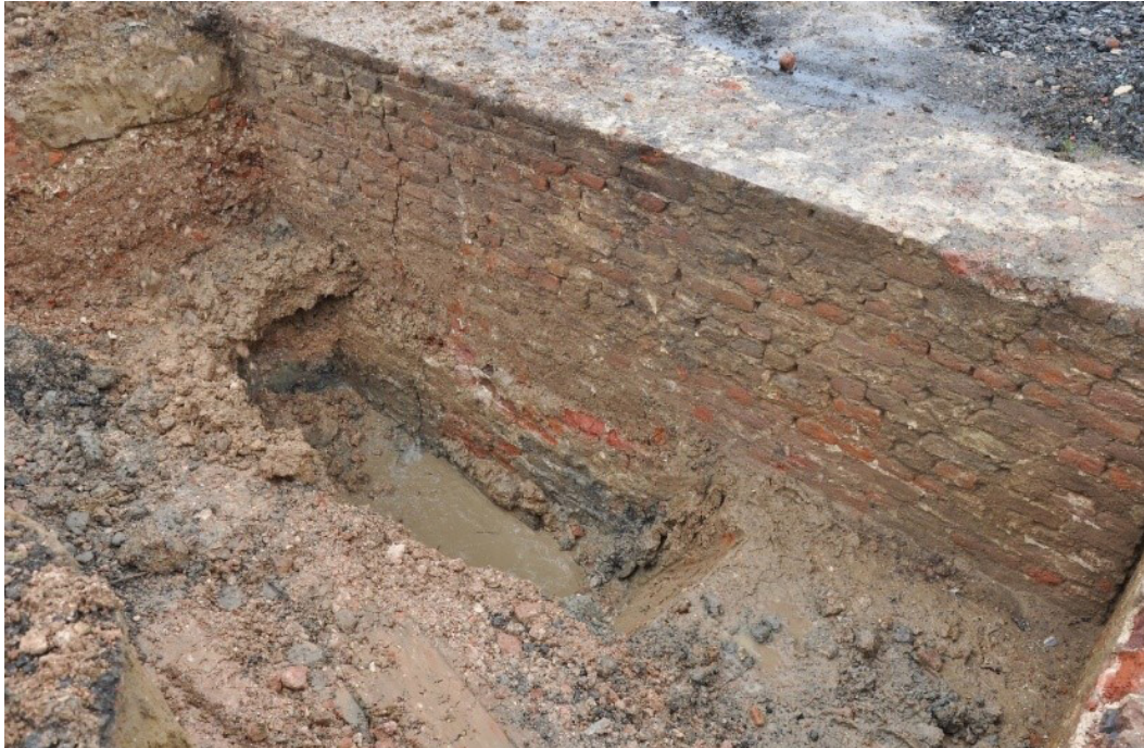
Figuur 9.28 De westwand van het poortgebouw. Hoewel het relatief hoge waterniveau het onmogelijk maakte om de fundering goed te bestuderen zijn er aan deze zijde geen sporen aangetroffen die erop duiden dat er houten palen onder het metselwerk waren geplaatst. Waarschijnlijk zijn de beide zijwangen van het poortgebouw op staal gefundeerd.
