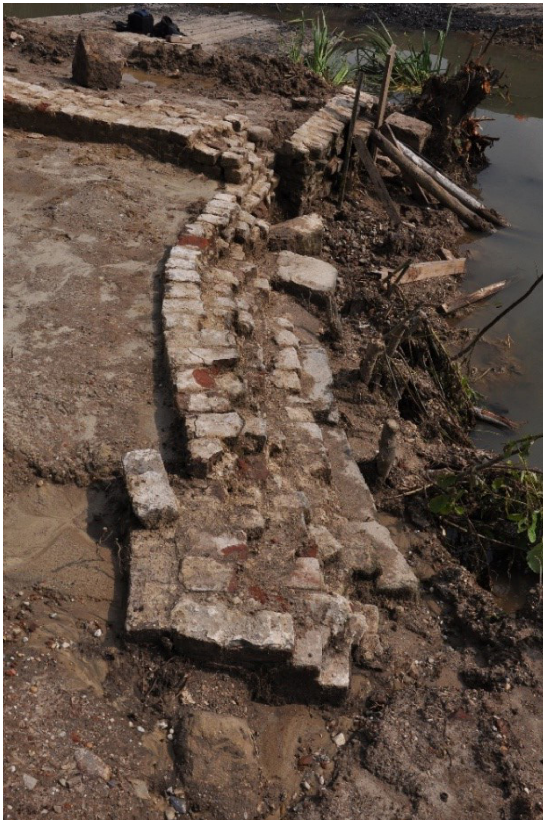
Figuur 9.16 Overzicht van de westelijke keermuur van het landhoofd gezien vanuit het noorden.
