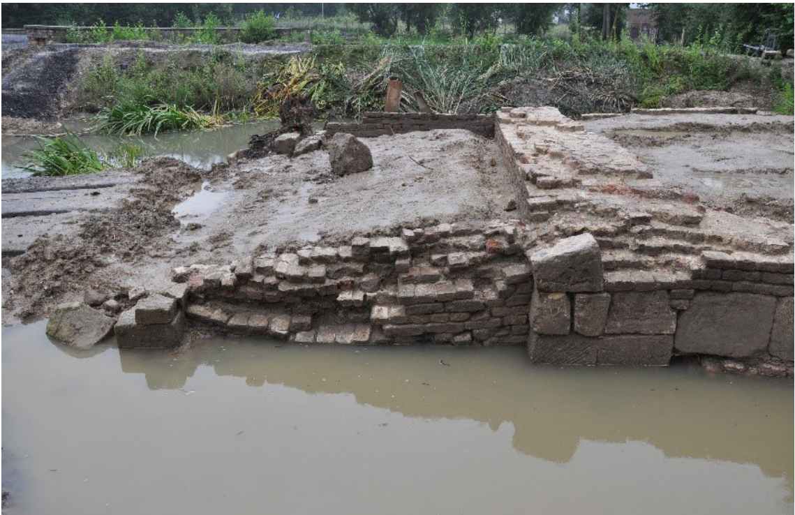
Figuur 9.18 De dichtgezette doorgang van de brug gezien vanuit het oosten. Bij het bruggenhoofd is nog net de aanzet van de overwelling van de doorgang zichtbaar.
