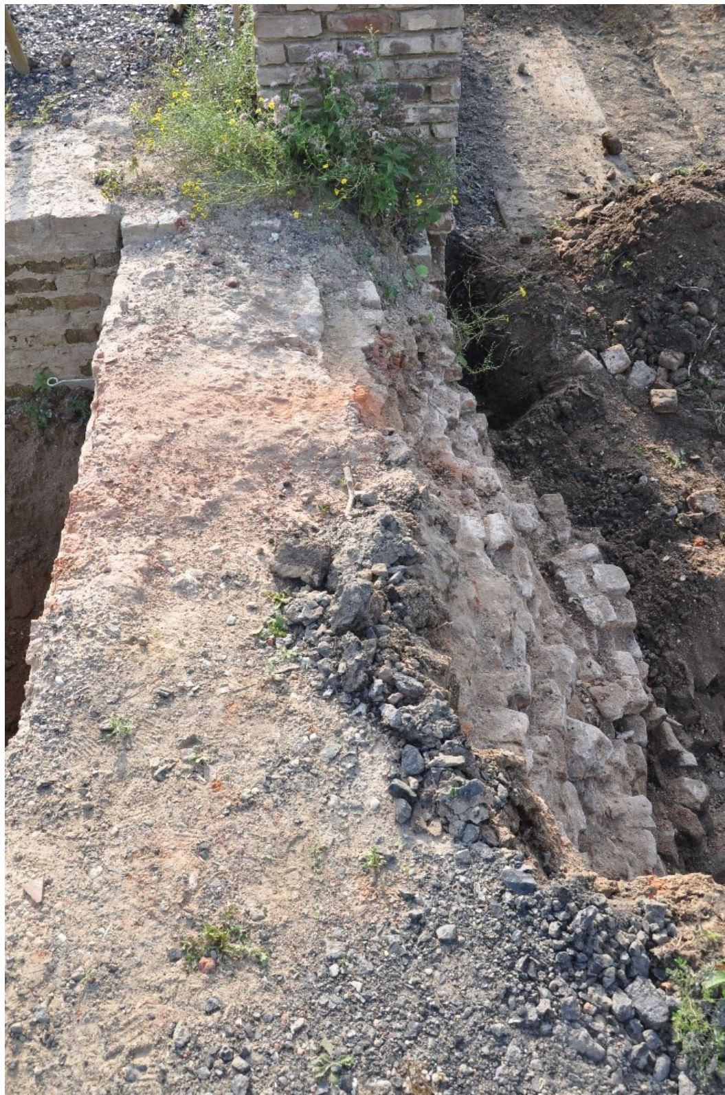
Figuur 9.24 Bovenaanzicht van de noordgevel van de poorttoren. Hier is goed zichtbaar dat het metselwerk ter plaatse van de brug uitspringt ten opzichte van de noordgevel van de bouwhoeve. Tevens is hier goed zichtbaar dat de muur aan de noordzijde aanzienlijk minder goed bewaard is gebleven dan aan de zuidzijde. Links is nog een klein deel van de werkput binnen het poortgebouw zichtbaar.
