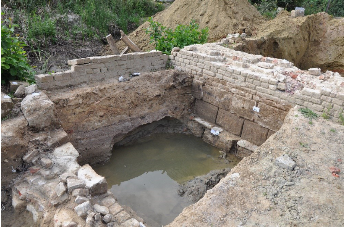
Figuur 9.11 De meest noordelijke overspanning van de brug. De grens van het oorspronkelijke metselwerk ten opzichte van het vervangen metselwerk bevindt zich op de overgang tussen het natuursteen- en het baksteenmetselwerk. Dit niveau komt overeen met de aanzet van het gesloopte gewelf. De baksteenformaten van de vulmuur zijn 23/25 x 11,5/12 x 6 cm, met een dikte van 36 tot 40 cm. Er is een okerkleurige, zandige mortel toegepast. Op de stenen bevinden zich mortelresten, hetgeen duidt op hergebruik. De baksteenformaten komen grotendeels overeen met de rest van het landhoofd. Aan te nemen is dat bij het herstel van het metselwerk, na het verloren gaan van de gewelven, gebruik is gemaakt van de bakstenen van de gewelven.
