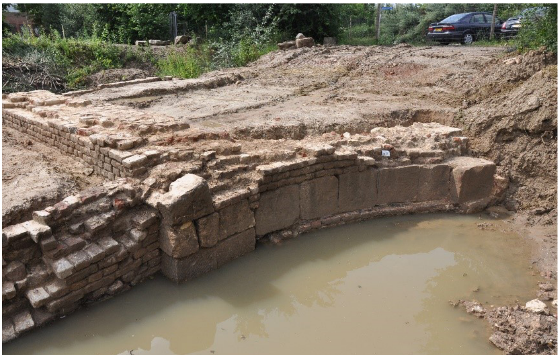
Figuur 9.11 De meest noordelijke overspanning van de brug. De grens van het oorspronkelijke metselwerk ten opzichte van het vervangen metselwerk bevindt zich op de overgang tussen het natuursteen- en het baksteenmetselwerk. Dit niveau komt overeen met de aanzet van het gesloopte gewelf. De baksteenformaten van de vulmuur zijn 23/25 x 11,5/12 x 6 cm, met een dikte van 36 tot 40 cm. Er is een okerkleurige, zandige mortel toegepast. Op de stenen bevinden zich mortelresten, hetgeen duidt op hergebruik. De baksteenformaten komen grotendeels overeen met de rest van het landhoofd. Aan te nemen is dat bij het herstel van het metselwerk, na het verloren gaan van de gewelven, gebruik is gemaakt van de bakstenen van de gewelven.
