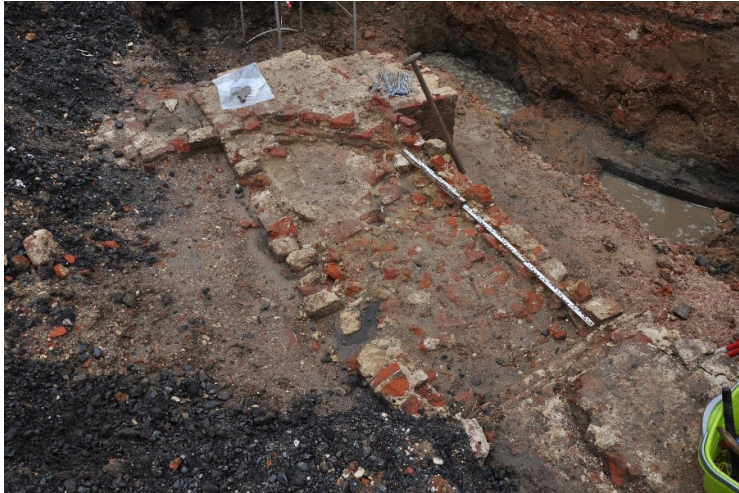
Figuur 9.30 Bovenaanzicht van de oostwand van het poortgebouw. Bij A is het deel van het metselwerk aangegeven dat correct is uitgevoerd. Het deel bij B daarentegen bestaat uit een soort kistwerk met aan de buitenzijden een halve steen metselwerk. De klamp is nog redelijk zorgvuldig uitgevoerd. Het inwendige van de muur bestaat volledig uit een stort van baksteenbrokken met mortel. Mogelijk is er een verband met de funderingsresten die bij C zichtbaar zijn. Deze behoren bij een ouder gebouw met een afwijkende oriëntatie.
