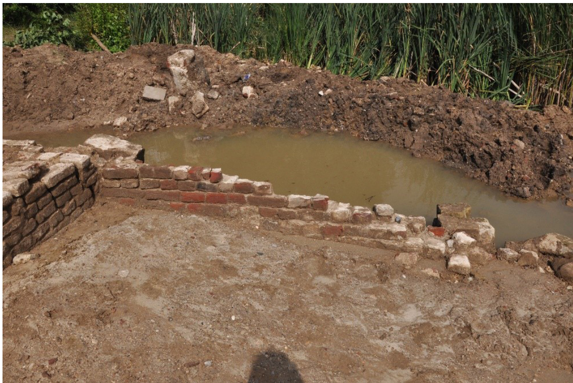
Figuur 9.19 De oostelijke vulmuur gezien vanuit het westen.
