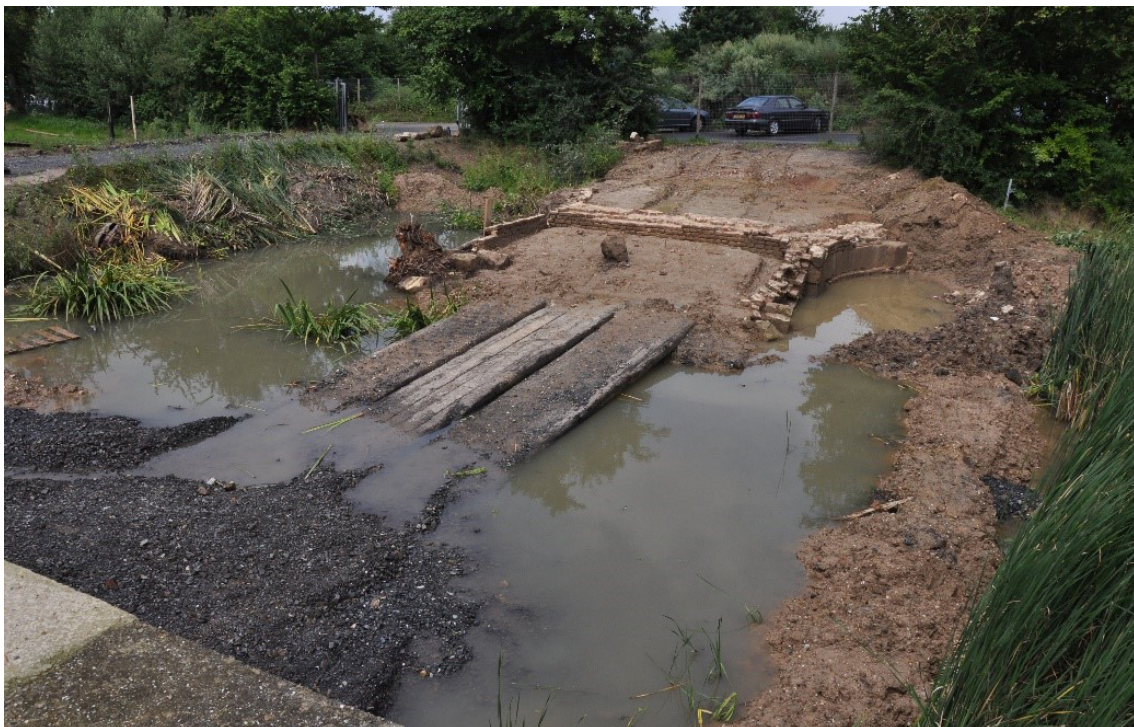
Figuur 9.5 Overzicht van de brugrestanten, gezien vanaf het terrein van de bouwhoeve in noordelijke richting.
