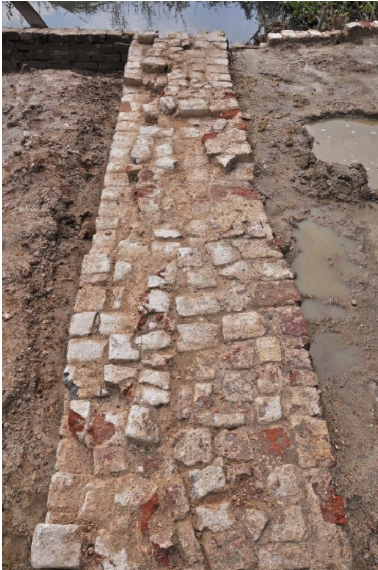
Figuur 9.9 De muur van het bruggenhoofd, gezien in westelijke richting. Bij A is het originele metselwerk van het bruggenhoofd zichtbaar (baksteenformaat 24 x 11/12 x 6 cm). Oorspronkelijk bevond zich ter plaatse van B de aanzet van de overwelling. Vermoedelijk zijn de gewelven in bouwkundige zin gebreken gaan vertonen, waardoor men genoodzaakt was om deze te verwijderen. In plaats daarvan is het bruggenhoofd aan de zijde van het gewelf recht opgemetseld (baksteenformaten: 24/25 x 11,5/12 x 5,5/6 cm; vier lagen metselwerk is 26 cm). Gezien de mortelresten op de voorzijde van de stenen zal er sprake zijn van hergebruik. Tegelijk is onder de boog, die ter plaatse van de zijgevels werd gehandhaafd, een anderhalf steens zware vulmuur geplaatst. Hiervan is een deel bij C nog zichtbaar. De ruimte tussen de muren zal met aarde zijn opgevuld. Vermoedelijk zijn in plaats van de gewelven ijzeren liggers gelegd, met daartussen bakstenen troggewelven.
