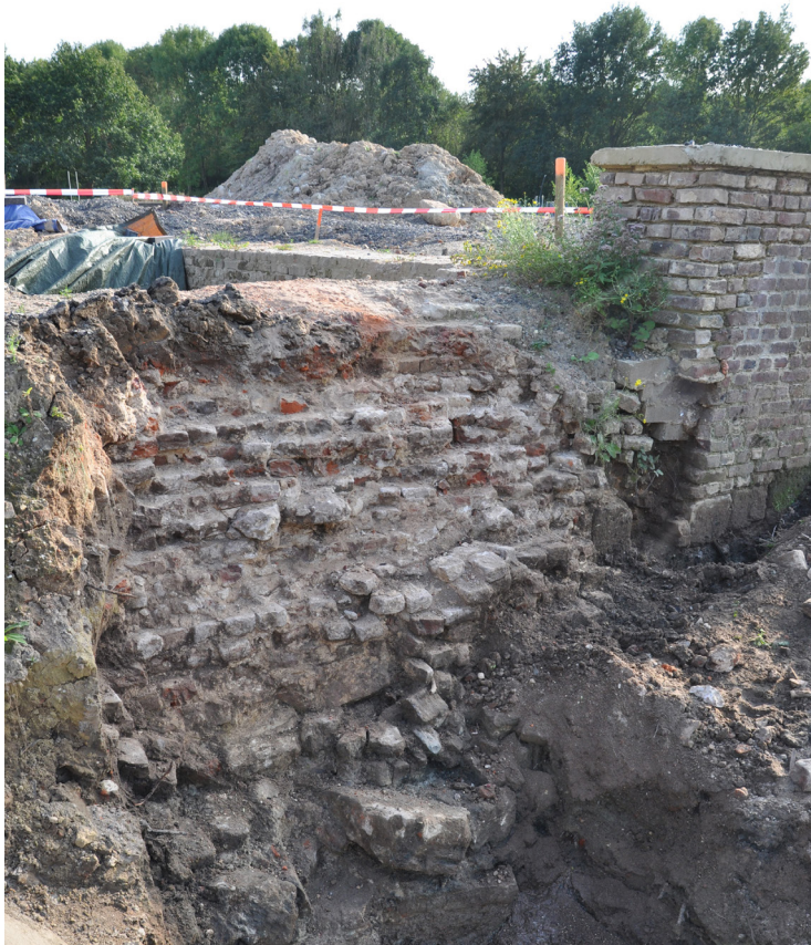
Figuur 9.22 Overzicht van het bewaard gebleven deel van de brugaanzet ter plaatse van de poort. Bij het uitgraven van de gracht heeft is het voorste deel van het metselwerk gesloopt. Daarbij is tevens het achterliggende metselwerk beschadigd, hetgeen het 'verwongen' uiterlijk van het metselwerk (A) verklaart. Bij de huidige werkzaamheden is het bij de consolidatie toegevoegde metselwerk verwijderd. Ter plaatse van de aansluiting op het overige deel is het metselwerk hersteld (B). Bij C zijn de betonblokken zichtbaar, die de kern van het consolidatiewerk vormt. Het metselwerk D zal ook voor het grootste deel bij de consolidatie tot stand zijn gekomen. Bij E zijn de natuursteenblokken van de waterlijst zichtbaar. Het onderste deel van de fundering bestaat hier uit blokken mergel en Kunrader steen (F) Het hoger gelegen deel is met baksteen opgetrokken ?? x 11,5 /12 x 5,5/6 cm. De mortel is een homogene okerkleurige kalkmortel). Bij G lijkt het metselwerk een vlakke voorzijde te bezitten. Dit zou de voorzijde van het naar voren geplaatste stuk metselwerk kunnen zijn. Hiervoor is echter nog aanvullend onderzoek noodzakelijk. Het detail van de volgende foto bevindt zich hier aan de rechterzijde.
