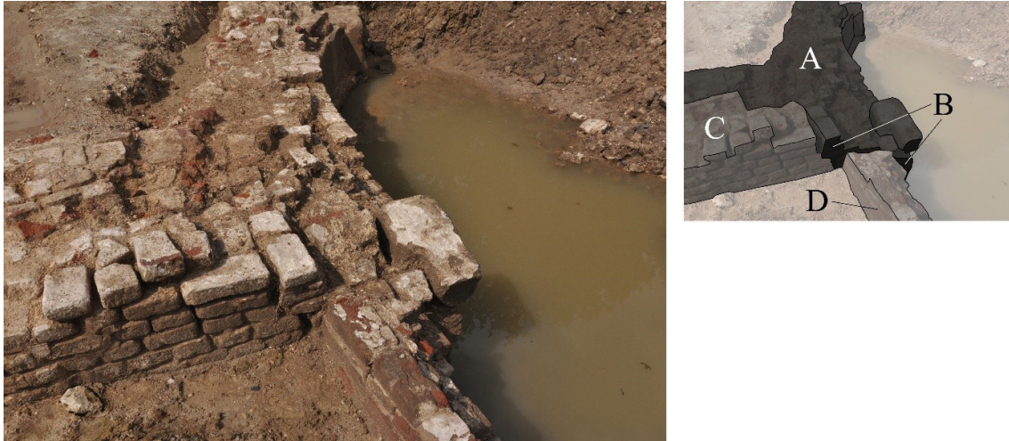
Figuur 9.13 Detail van de aansluiting van de vulmuur op het bruggenhoofd aan de oostzijde van het bruggenhoofd. A is het oorspronkelijke (17de-eeuwse) metselwerk van het bruggenhoofd. Omdat het metselwerk aan deze zijde beter bewaard is gebleven dan aan de westzijde is hier - bij B - nog net de aanzet van de overwelling zichtbaar. Het bij C zichtbare metselwerk vervangt het metselwerk dat de aanzet vormde van de overwelling van de doorgang. Aangezien dit metselwerk van een rechte dagkant is voorzien, in tegenstelling tot het restant van de oorspronkelijke overwelling, zal het geplaatst zijn op het moment dat de overwelling werd vervangen door een recht brugdek. Bij D is de vulmuur onder de brugboog zichtbaar.
