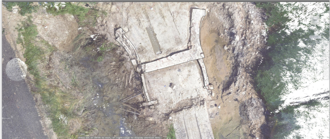
Figuur 9.2 Orthofoto van het bruggenhoofd aan de veldzijde. Voor de betere herkenbaarheid zijn de contouren van het metselwerk met zwarte lijnen geaccentueerd. De foto is geleverd door Constructiebureau H. Hagnaars. Een orthofoto is een tweedimensionale projectie van een deel van de puntenwolk die door 3D scannen is verkregen.
