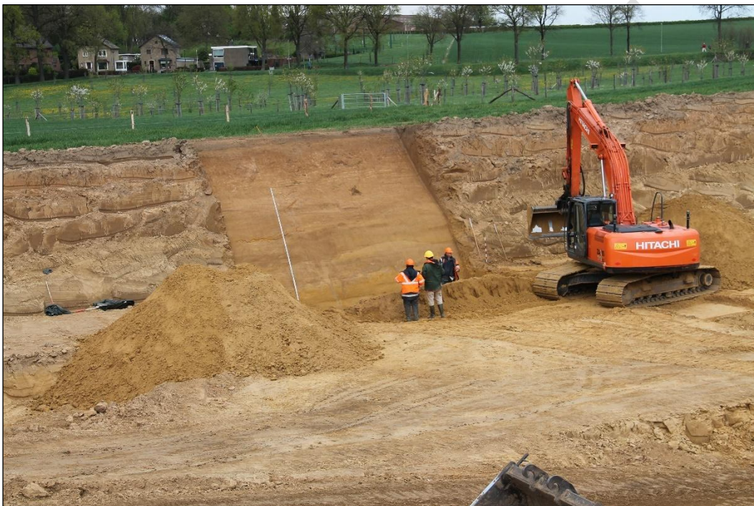
Afb. 11. De bovengrond is voorafgaande aan het onderzoek verwijderd.
