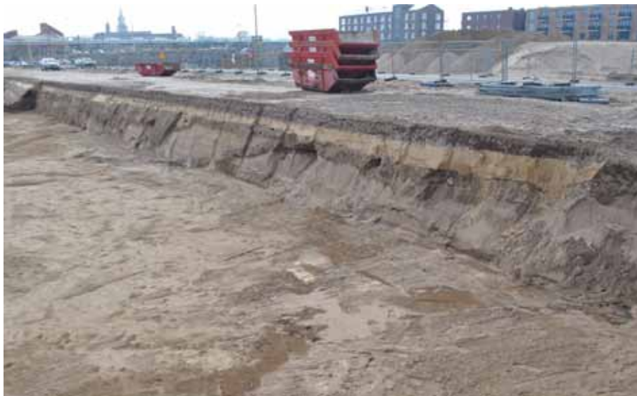
27. Bouwput aan de Dreef. In het westprofiel is de insteek van de oude Noorderhaven zichtbaar.
