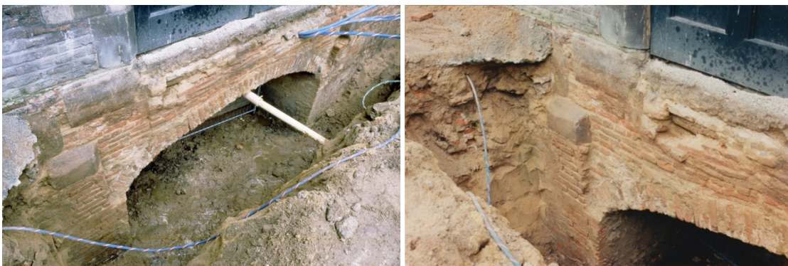
35 Noordgevel met de doorgang in 1993. De ontlastingsboog is hier nog intact
