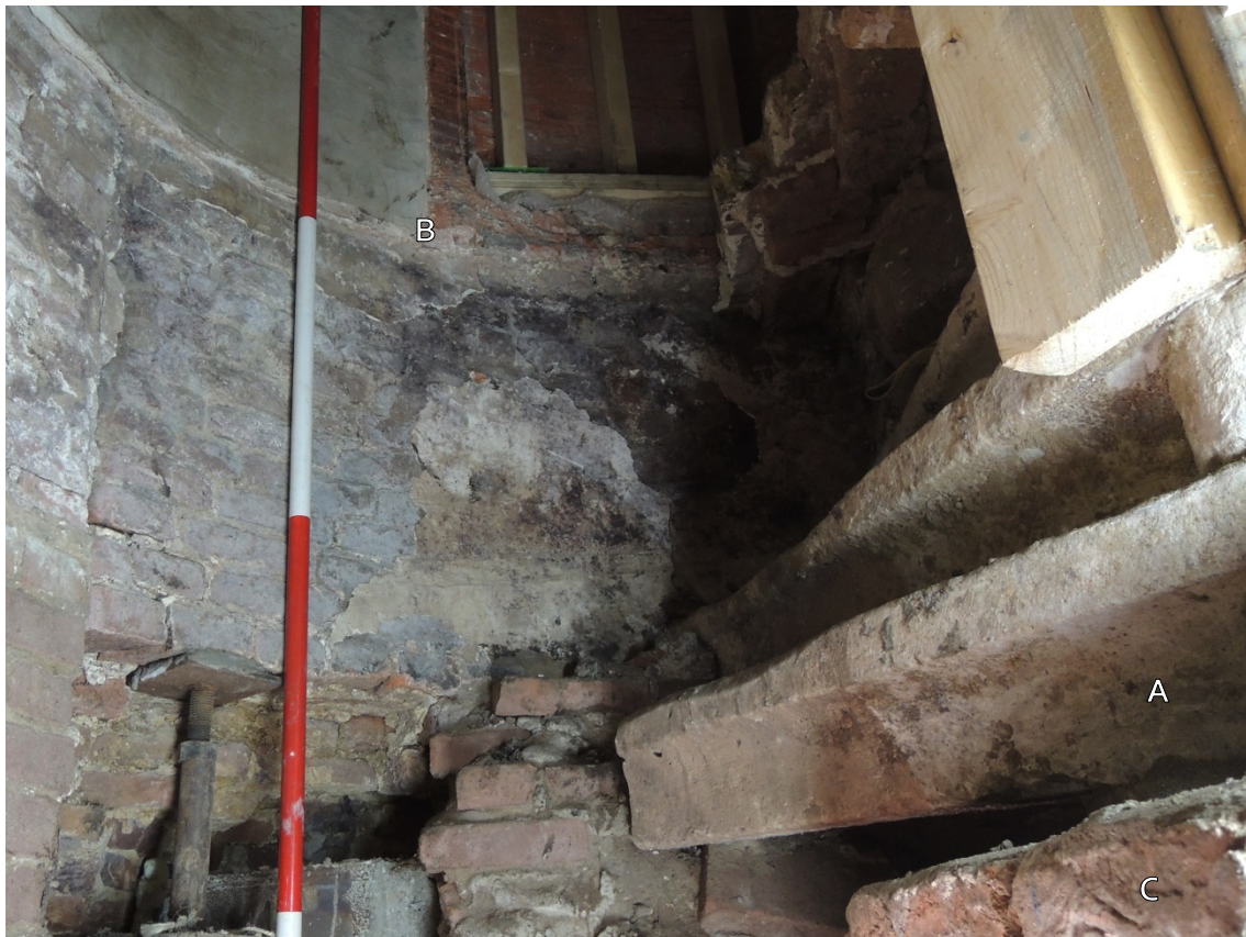
46 Binnenzijde Metselaarstoren, spiltrap met zandstenen treden
