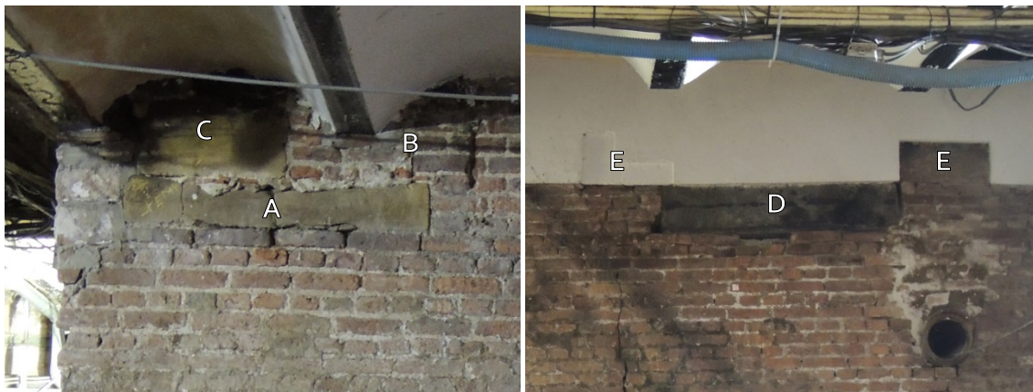
40 Dichtgezette doorgangen met zandstenen (links) en hardstenen (rechts) onderdorpel
