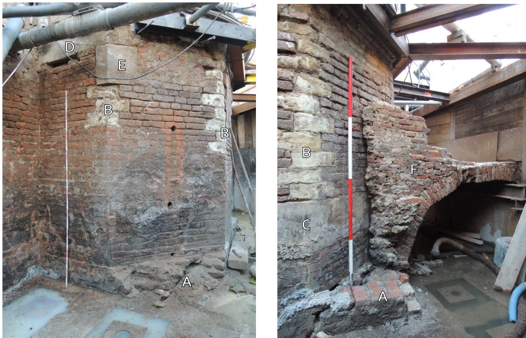
47 Links: Noordgevel (links) met de Sint-Lucastoren (rechts). Rechts: Sint-Lucastoren (links) met het gewelf (rechts)
