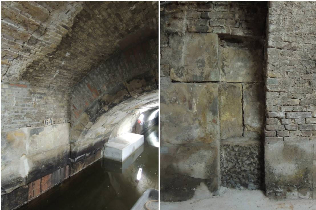
25 Links: Duiker gezien naar oostelijke boog Rechts: sleuf die in zandstenen plint is aangebracht. De plint is aan de kant van de Geldersekade (links) hoger uitgevoerd dan die aan de kant van de Kloveniersburgwal (rechts)
