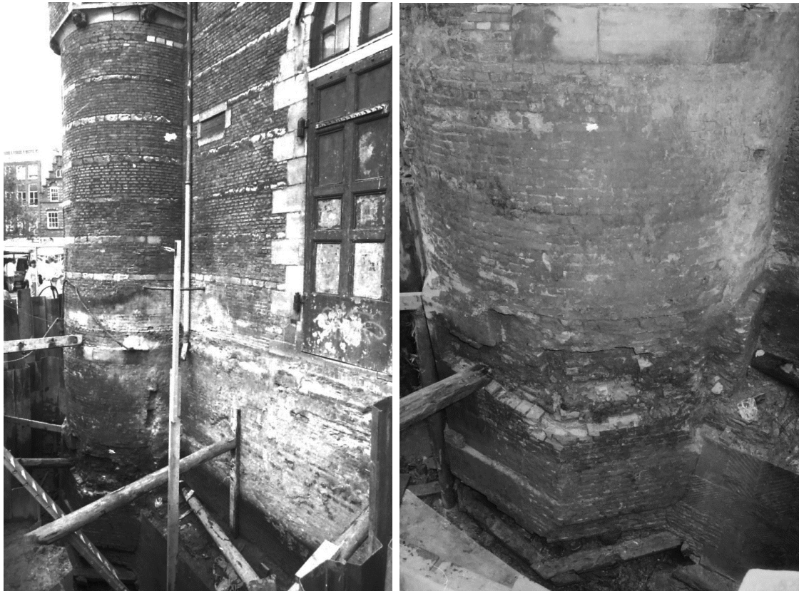
14 Links: Overzichtsfoto van de in 1987 gegraven funderingsput met de Klompenmakerstoren (links) en zuidgevel van de voorpoort (rechts). Rechts: De Klompenmakerstoren met rechts de natuurstenen schil die tegen de zuidgevel was aangebouwd
