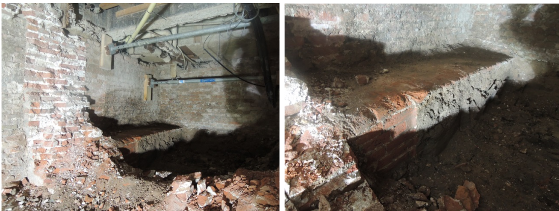
26 Links: de dwarsmuur tussen het midden (links) en westelijke (rechts) compartiment tijdens de sloop. Rechts: uitgemetseld blok van het westelijke compartiment.
