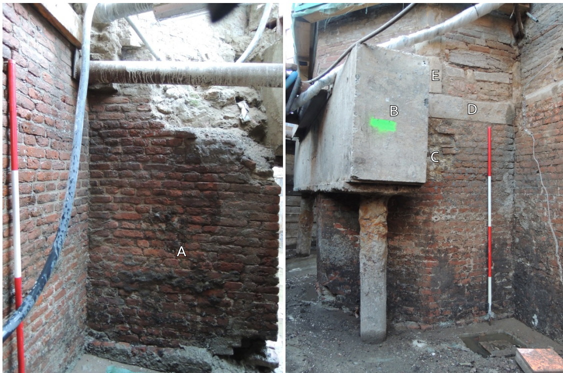
45 Links: De binnenhoek van de oostgevel (links) met de Metselaarstoren (rechts). Rechts: De binnenhoek met de Metselaarstoren (links) met de noordgevel (rechts). Naast de betonbalk is een dichtzette doorgang zichtbaar.
