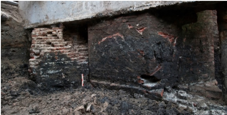
33 De noordelijke stadsmuur, zicht op de achterzijde van de steunbeer (links) en de Metselaarstoren (rechts)
