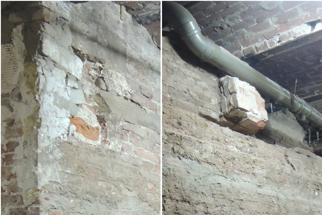
43 Boogaanzetten in de oostelijke zijbeuk
