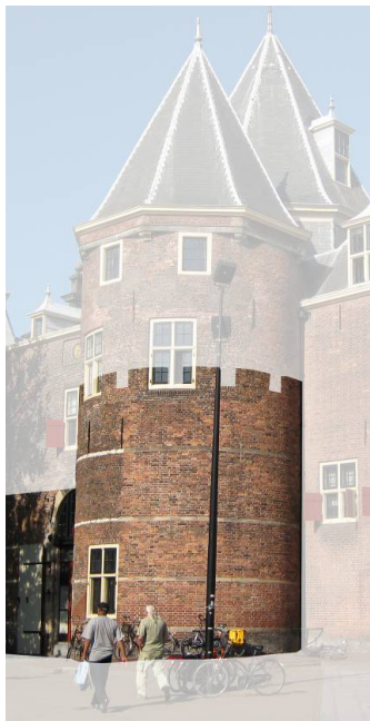
16 Het bouwvolume van het oorspronkelijke gebouw met daarbij aangegeven de kantelen in het muurwerk van de Sint-Eloytoren (foto en bewerking: Jacqueline de Graauw).
