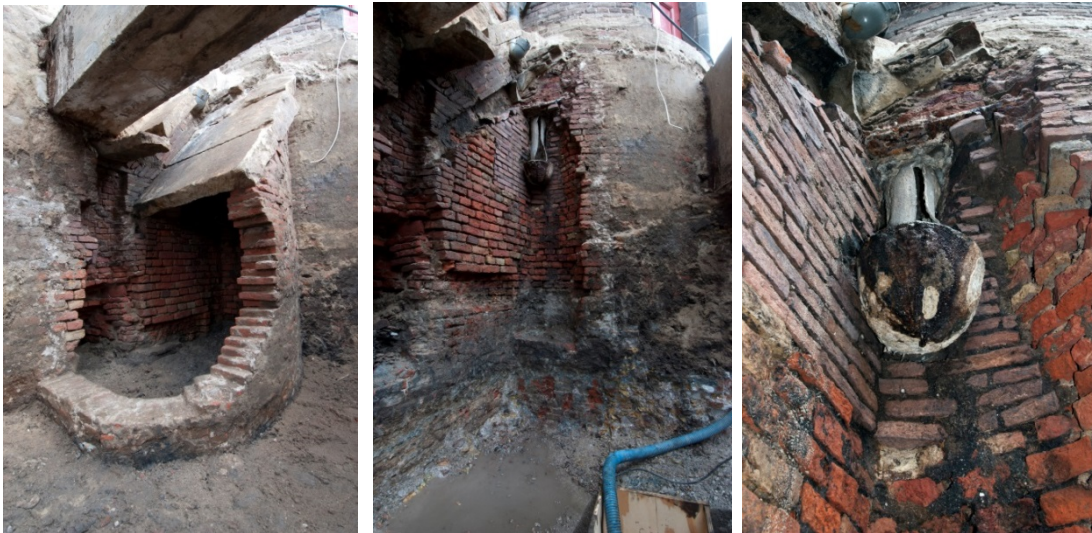
66 Latrine in de hoek van de Theatrum Anatomicumtoren in verschillende fasen van ontmanteling. Links is het gat naar de duiker zichtbaar evenals de natuurstenen glijgoot, midden de positie van de secreetrecter tegen de toren en rechts een detail hiervan
