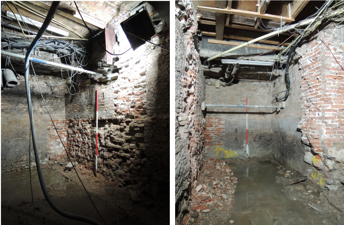
27 Oostelijke (links) en westelijke (rechts) compartiment na de sloop van het uitgemetselde blok en de dwarsmuur
