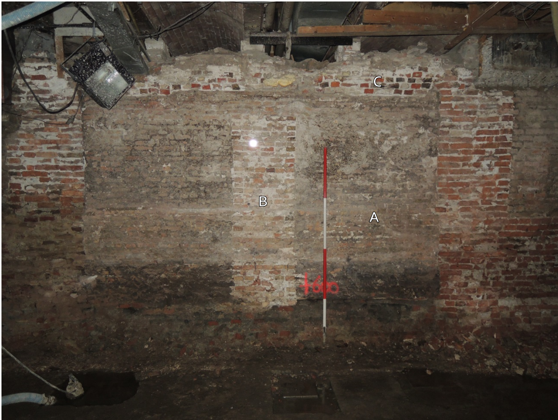
28 Zuidwand middelste compartiment (gezien naar de duiker) na de sloop van de dwarswanden
