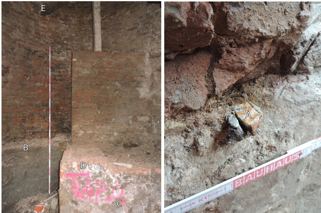
22 Links: Klompemakerstoren, uitgemetseld blok aan de binnenzijde. Rechts: Theatrum Anatomicumtoren, zijkant van een zandstenen plintblok voorzien van ijzeren kram (doorgezaagd), dat met lood is aangegoten
