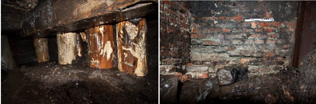
52 Links: De fundering van de westelijke poortgebouw muur. Rechts: De tegen de westgevel gebouwde stadsmuur
