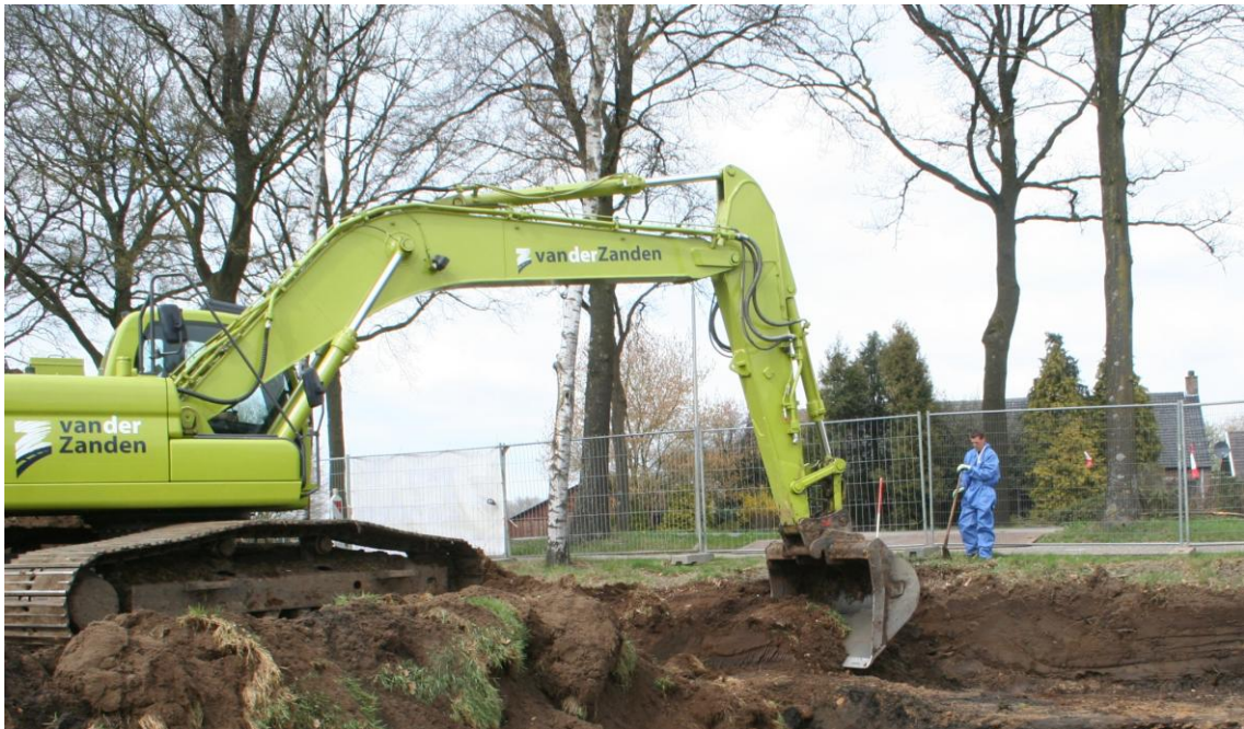
Afb. 4 Saneringswerkzaamheden aan de noordzijde van de ontgravingsput.
