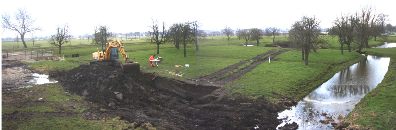
Afbeelding 2: de onderzoekslocatie aan de noordwestzijde van het plangebied (foto richting zuidwesten). Rechts op de foto ligt het centrale omgrachte gebied waar de resten van een stenen huis zijn aangetroffen.
