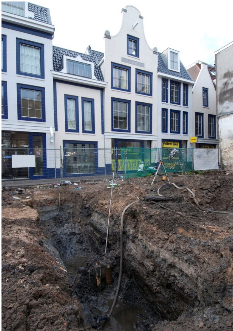
5 Werkput 1 met profiel, gezien naar de Oudezijds Armsteeg. De nieuwbouw ertegenover staat op de vindplaats ARM uit 2008
