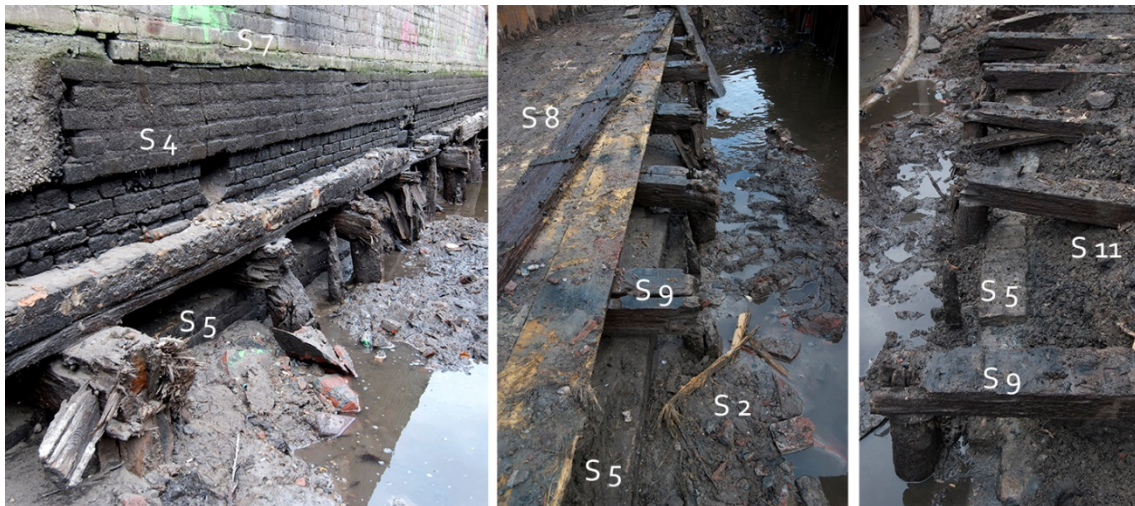
23 Verschillende fasen van ontmanteling van de bestaande kademuur S 4, die bleek te zijn aangelegd boven een gedeeltelijk afgesloopte voorganger S 5
