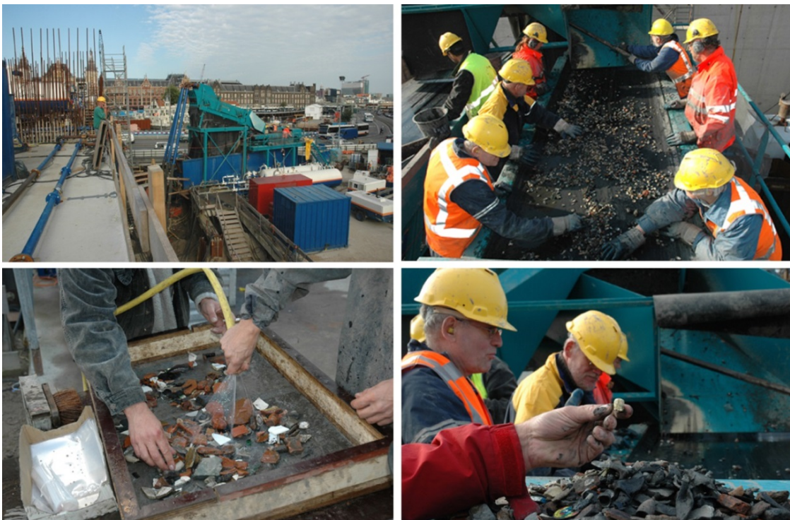
7 Alle grond die onder de caisson van de startschacht werd weggespoten is over een zeefinstallatie gevoerd waarbij circa 450.000 vondsten uit het Damrak werden geborgen
