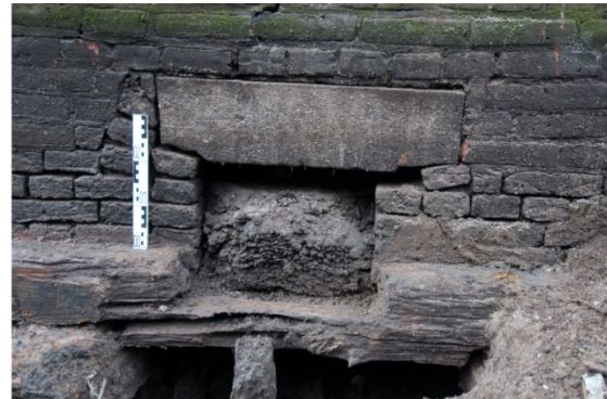
25 Baksteen uit de oudste kademuur (OZV15-8-1) en uit de meest recente (OZV15-3-1), en de dichtgezette riooldoorlaat in de kademuur gezien vanaf de grachtzijde
