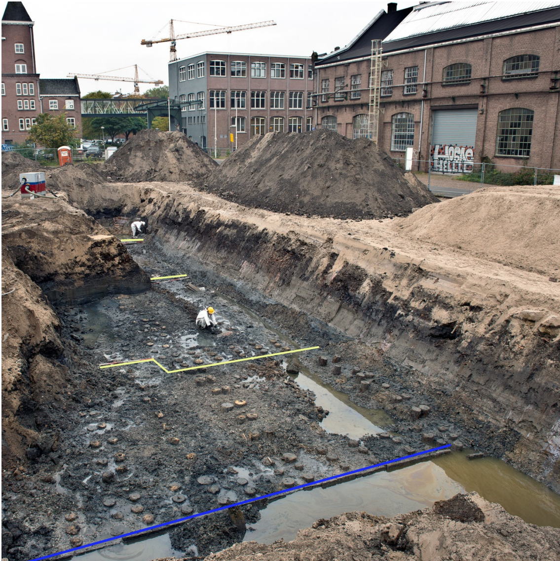
34 Werkput 7, fundering van het Zeemagazijn (in geel gemarkeerd) met op de voorgrond de damwand en de palen onder het laaddek (blauw)
