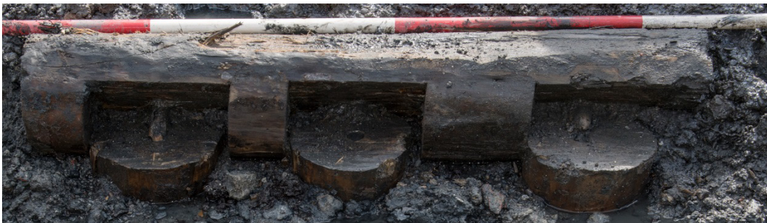
21 De funderingsconstructie van de bouwmuren van het Zeemagazijn: drie palen afgedekt door een kesp (werkput 5)
