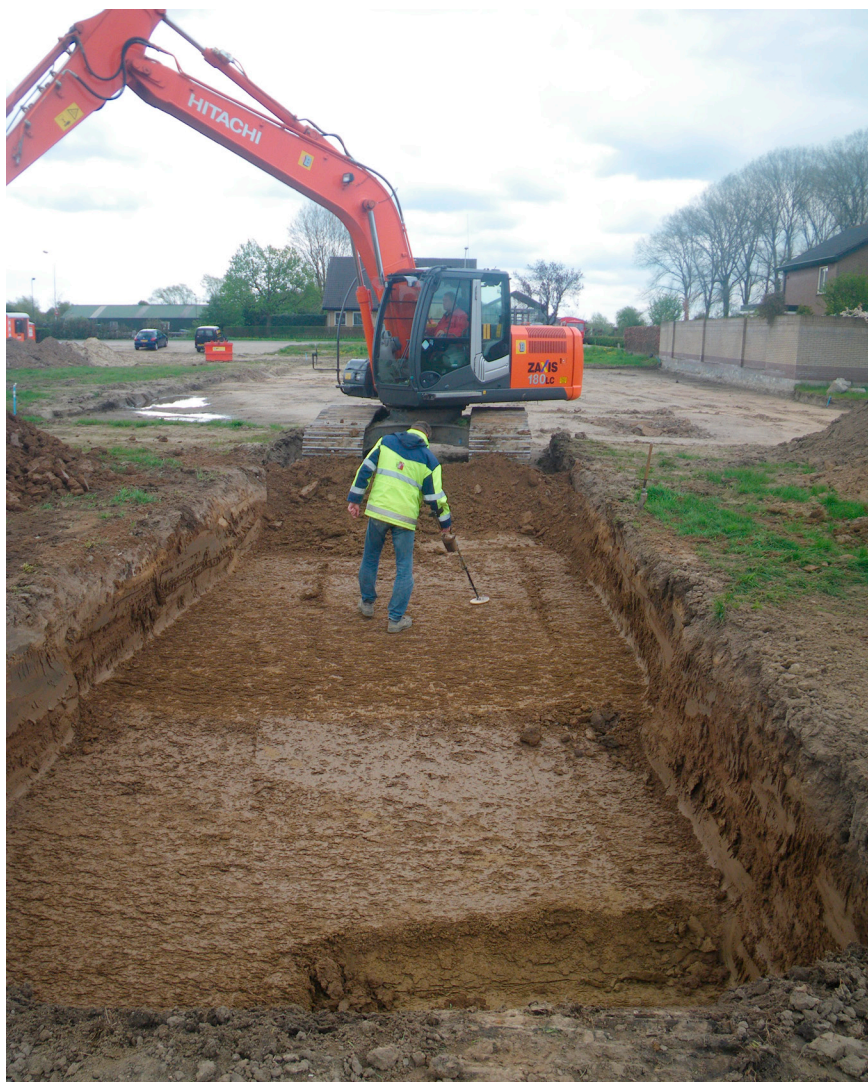
Figuur 1.3. Tijdens de aanleg wordt het vlak afgezocht met de metaaldetector. BAMN
