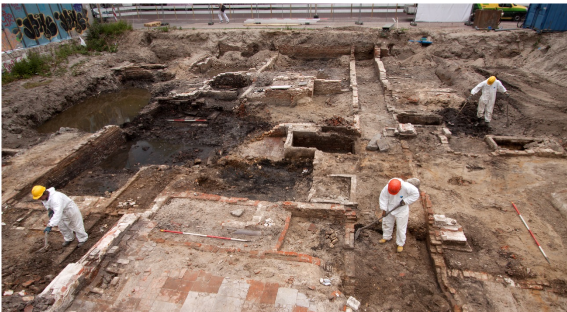
36 De fundering van huizen en gangwoningen, gezien naar de Valkenburgerstraat. In het midden ligt de Hartjesgang
