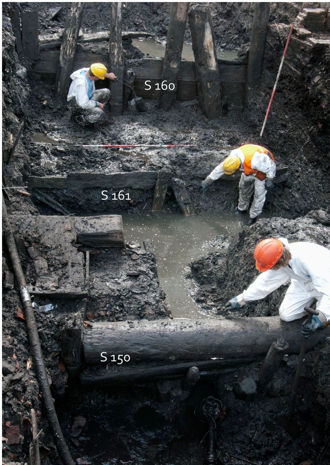
35 Perceel VII, landwinning in de Uilenburgergracht gezien richting zuiden met de kade uit circa 1602 (S 160) en op de voorgrond de rond 1700 gerealiseerde kade S 150. Rechts profiel 6
