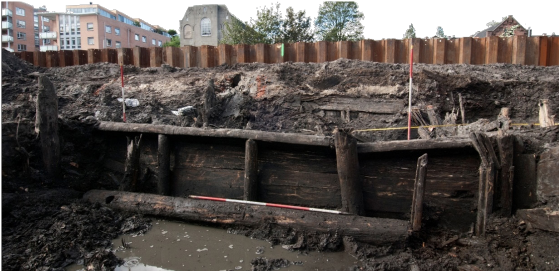
29 De binnenzijde van caisson S 219 op perceel III, gezien richting Uilenburgergracht met daar tegenaan de lenspomp
