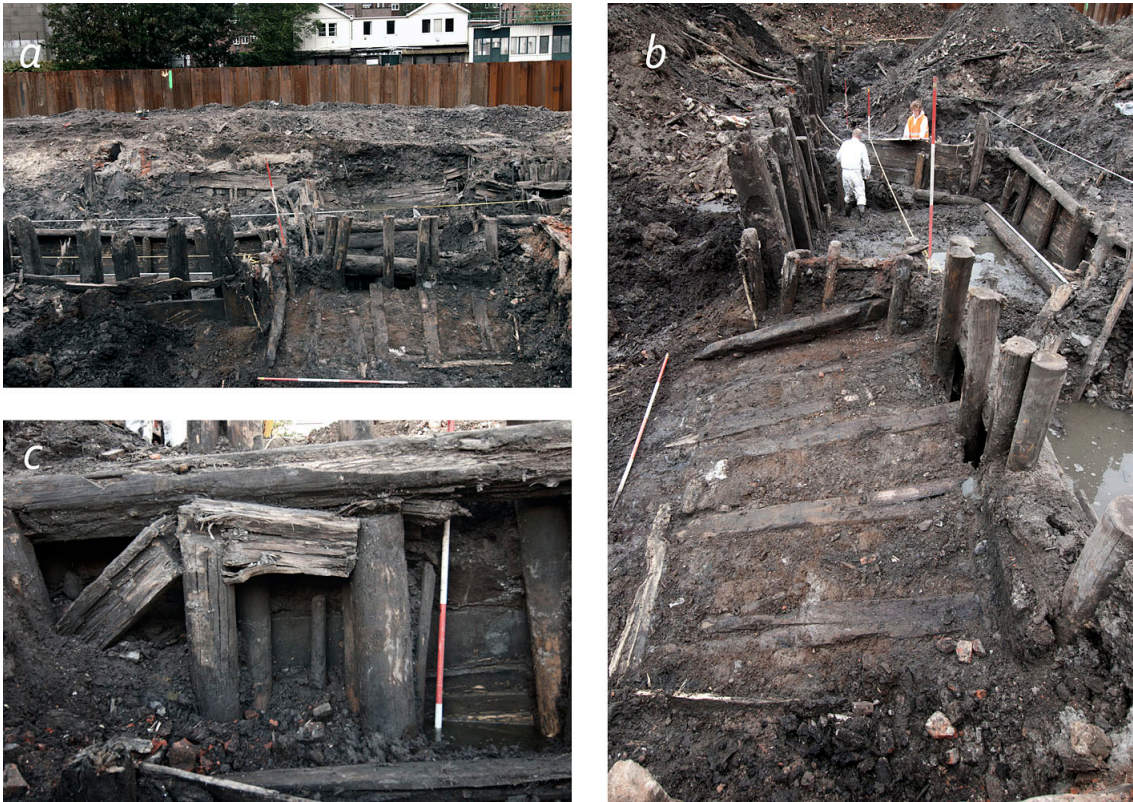
23 Perceel II, kade S 367: a. achterzijde, gezien richting Uilenburgergracht. Links kade S 160, rechts kade S 367 met daarvoor planken S 359 vanaf de grachtzijde; b. oeveruitbreiding met de fundering van een klein gebouw (S 359), gezien richting zuidwesten. Duidelijk is de verspringing te zien ten opzichte van kade S 160 van 'oerkavel' B. Rechtsachter de caisson van de overaansplemping op perceel III uit 1625-1650, c. kade S 367 gezien vanaf de grachtzijde
