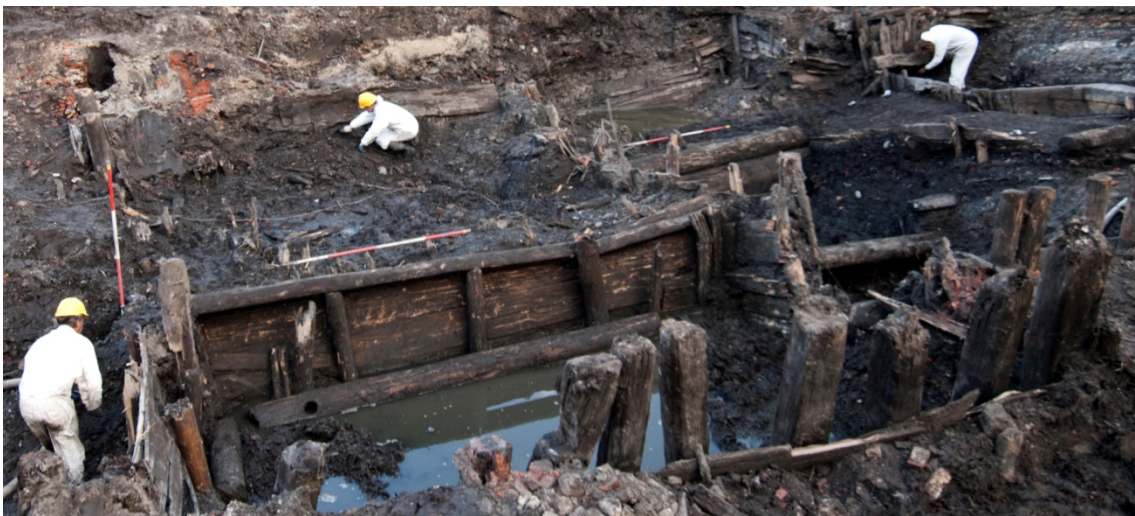
26 Caisson S 219 op perceel III gezien vanaf de oude kade S 160 richting noordoosten. Linksachter het fragment van de lenspomp met gat
