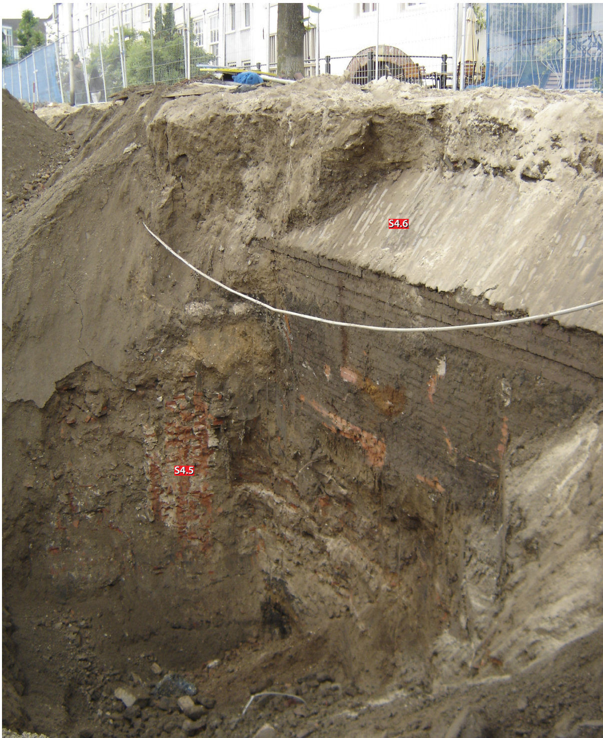
Figuur 4.38. Keermuur S4.6 met onderin het puinpakket en dieper gelegen en oudere keermuur S4.5.
