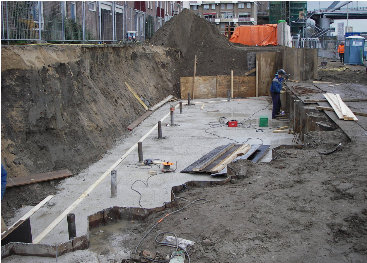
Figuur 7.4. De Rode Toren ter plaatse van de hoogwaterkering afgedekt met een betonnen plaat.
