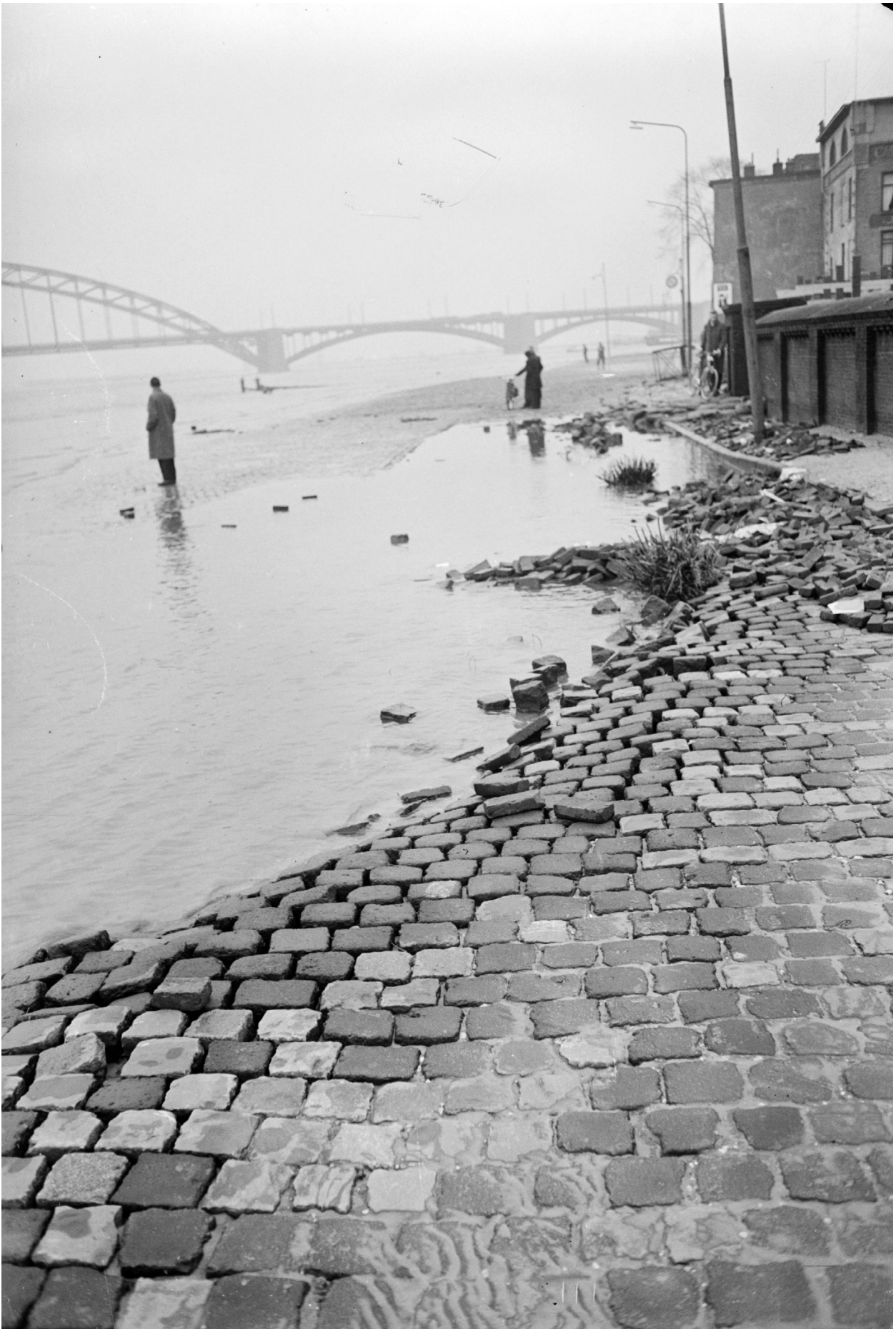
Figuur 2.46. Verzakking van de Waalkade (1958) ten gevolge van het hoge water. Op de achtergrond de Waal-Verkeersbrug (RAN, GN6460).
