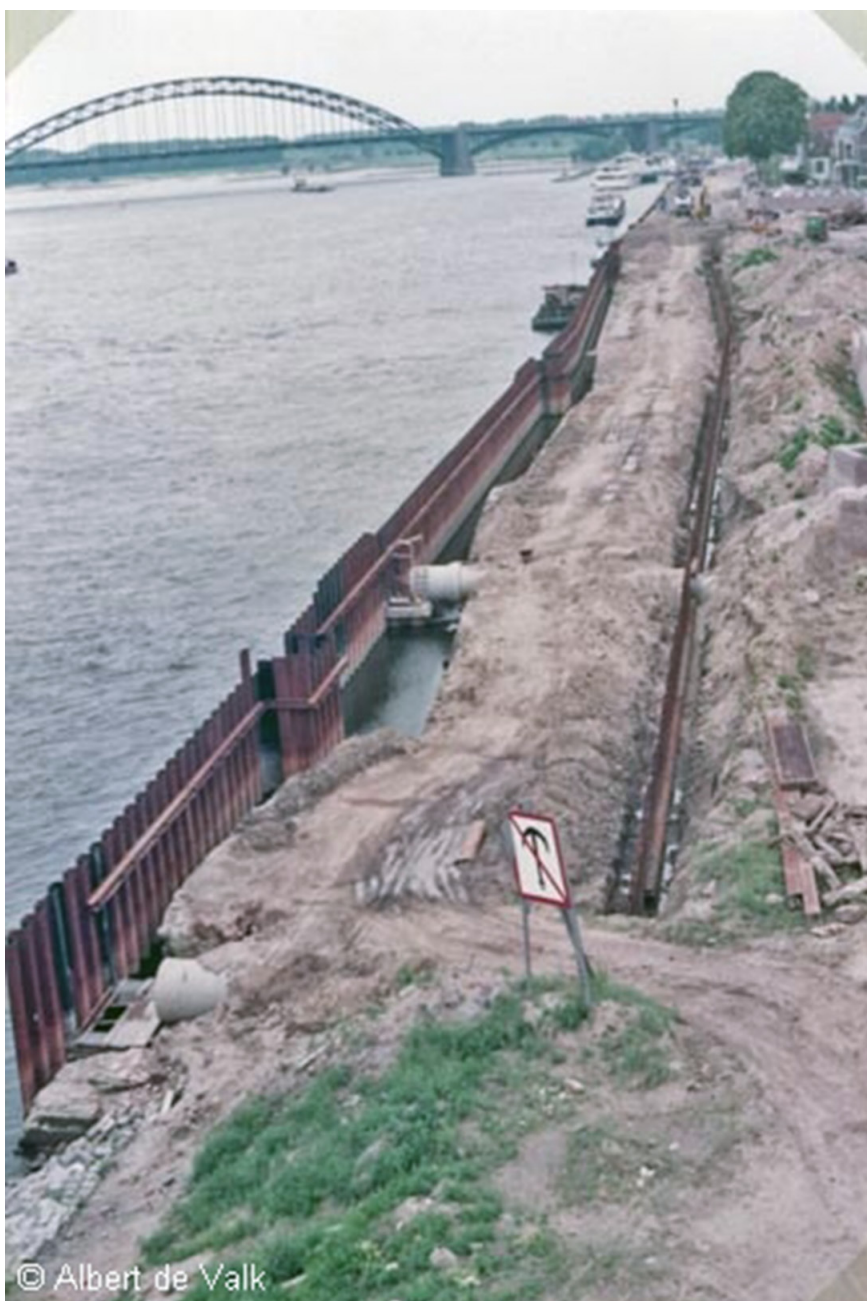
Figuur 8.4 Detailopname van de stalen damwand (1981). Goed te zien is dat de constructie van de stalen damwand om de noordelijke haven-/kademuur is heengebouwd. (Fotograaf A. van der Valk/www.noviomagus.nl).
