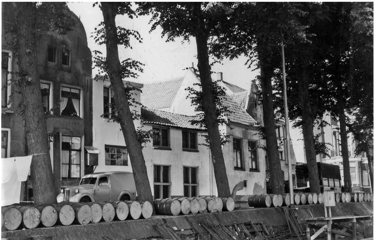
Figuur 6.21. Waalwal met aan de voorzijde de jongste keermuur, 1955. (RAN, foto F5894).
