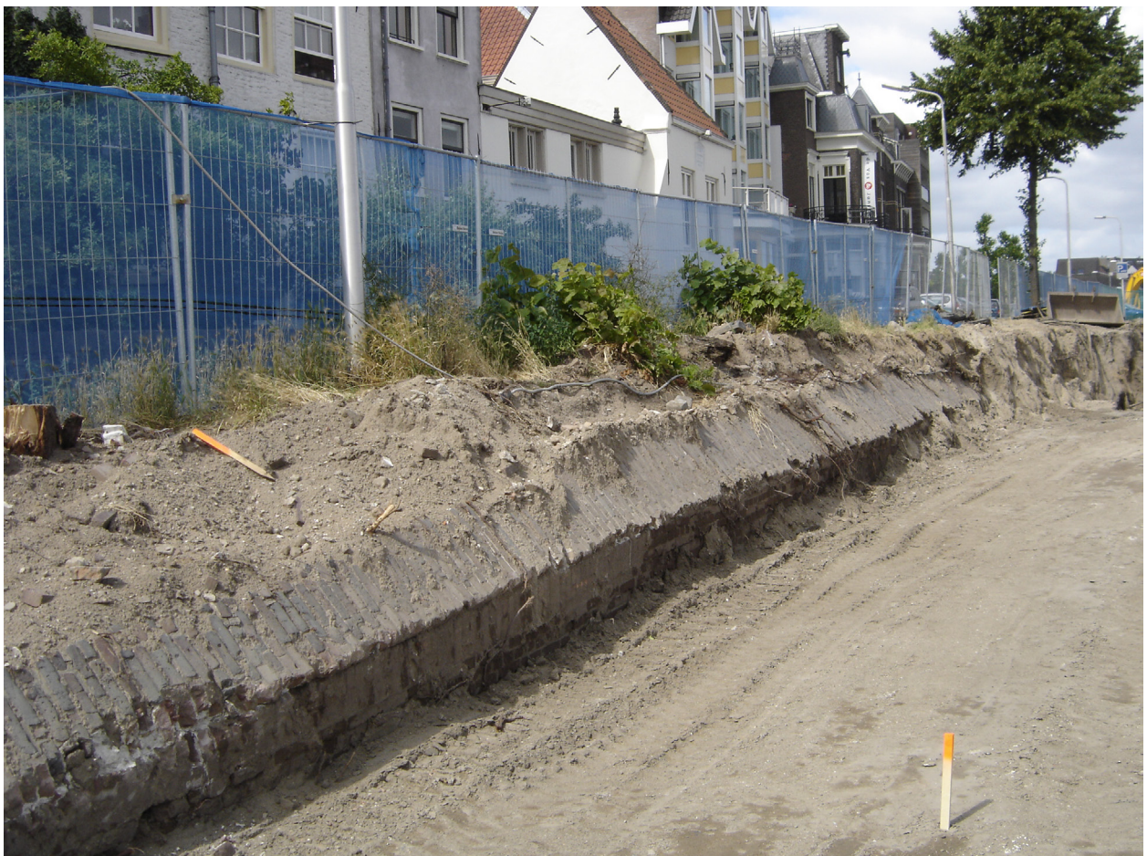
Figuur 4.37. Vrijgelegde keermuur S4.6. Kijkrichting naar het westen.
