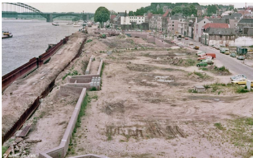
Figuur 2.48. Aanleg van de nieuwe hoogwaterkering en stalen damwand (1981). (Fotograaf A. de Valk/www.noviomagus.nl).
