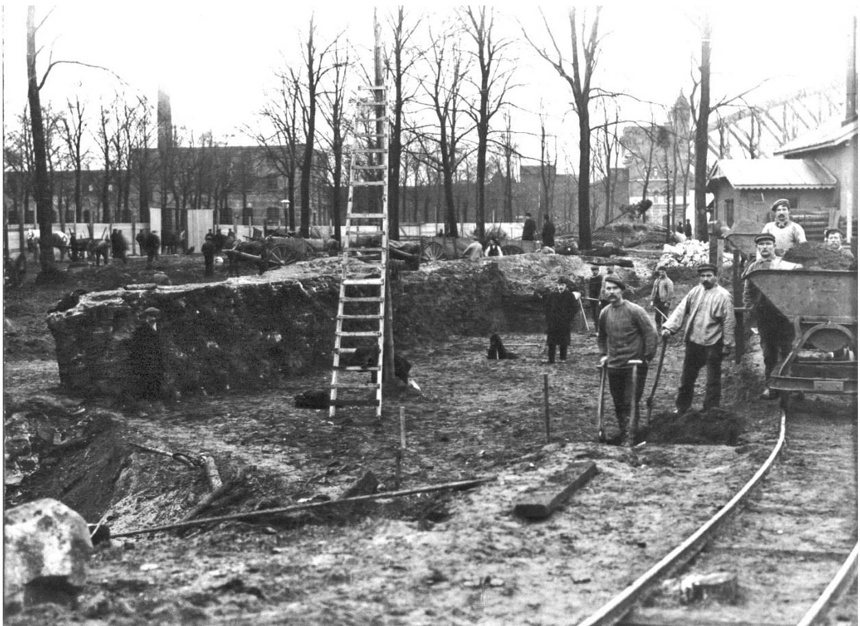
Figuur 2.34. Grondwerkzaamheden nabij de ruïne van de Boddelpoort ten behoeve van de bouw van de tramremise (1900-1910) (RAN, foto 1667).
