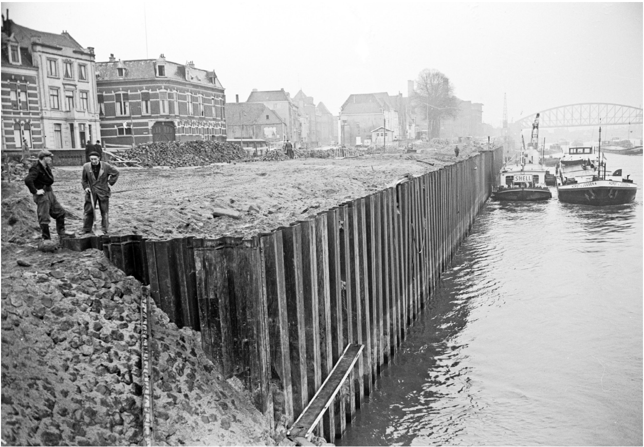
Figuur 2.42. Herstelwerkzaamheden aan de voet van de kademuur ter hoogte van de Grotestraat (december 1955). Op de achtergrond de Waal-Spoorbrug (RAN, glasnegatief GN6173).
