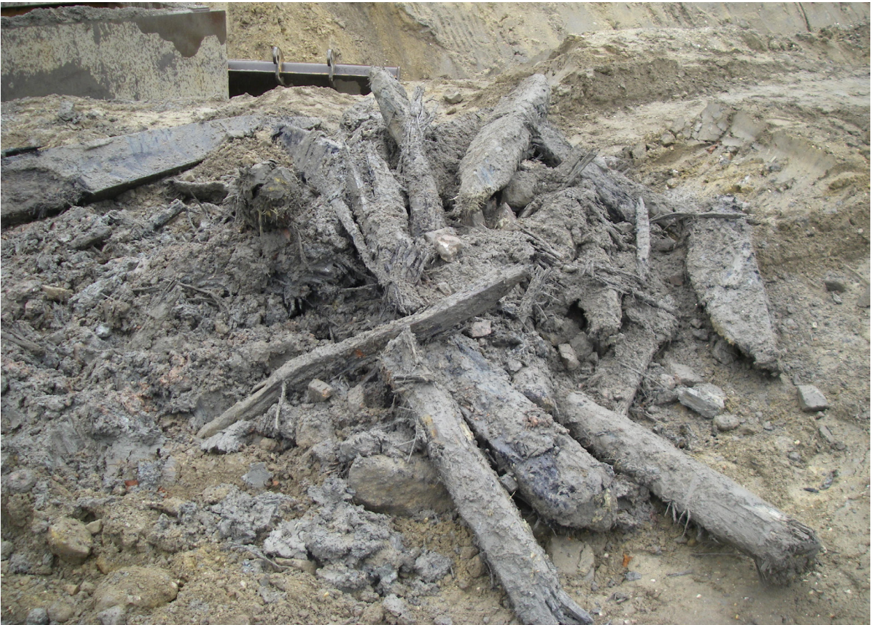
88 Figuur 4.24. Restanten van de machinaal verwijderde houten fundering.
