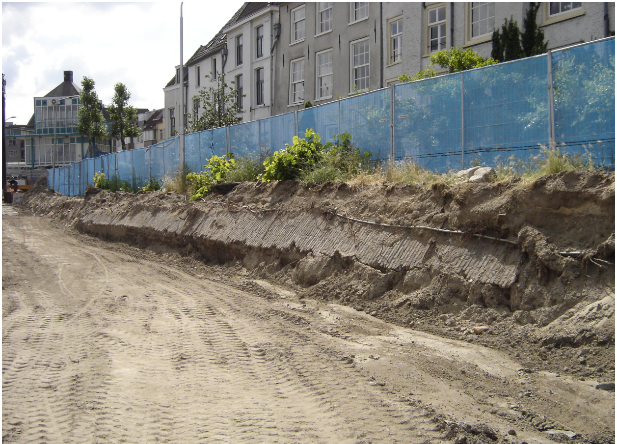
Figuur 4.36. Vrijgelegde keermuur S4.6. Kijkrichting naar het oosten.
