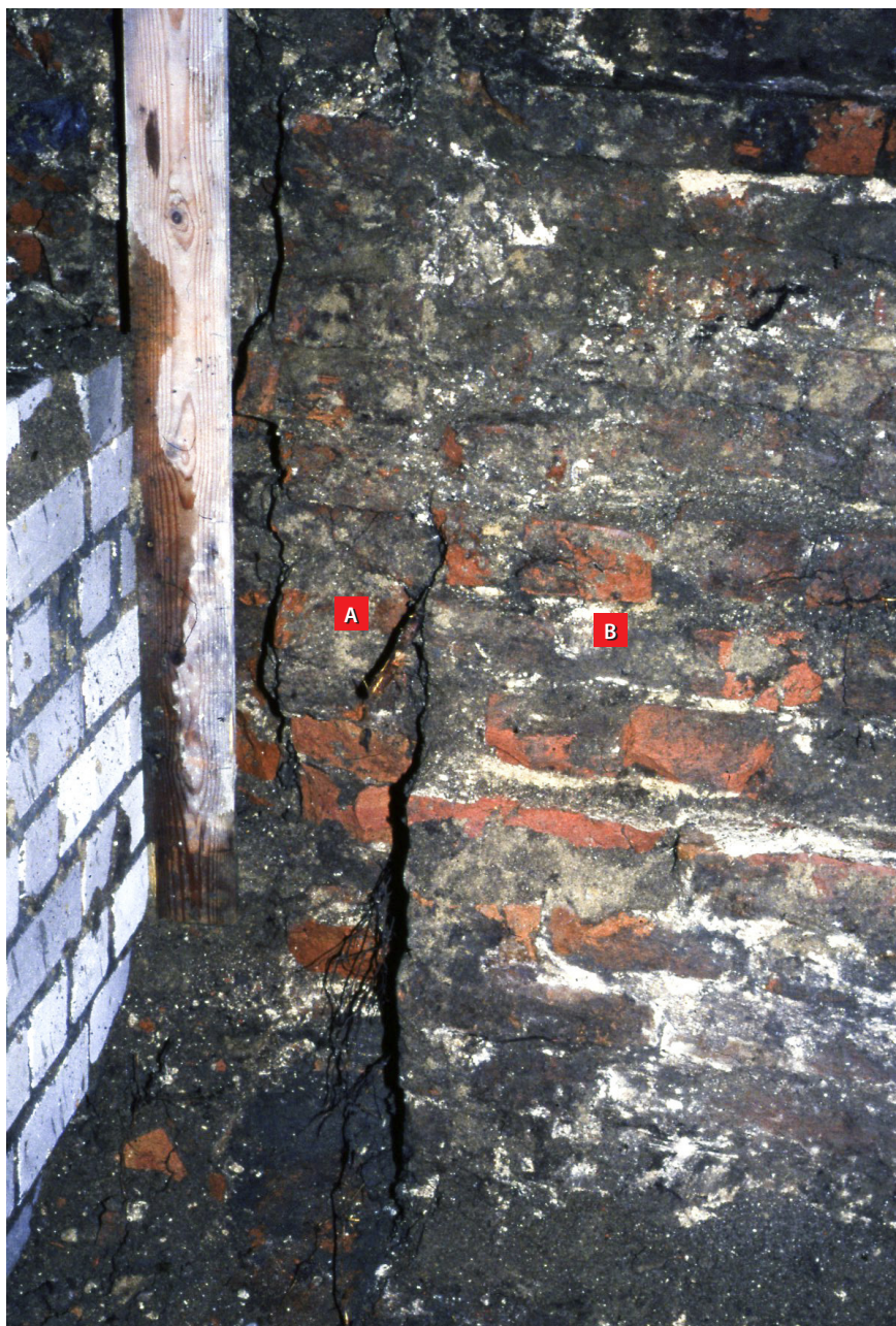
Figuur 4.46. Fragment van oudere fase van de St. Anthonispoort (A) en stadsmuur (B). Foto van de verschillende muren in de uitgegraven kelder Lage Markt 47d, kijkrichting naar het noordoosten.
