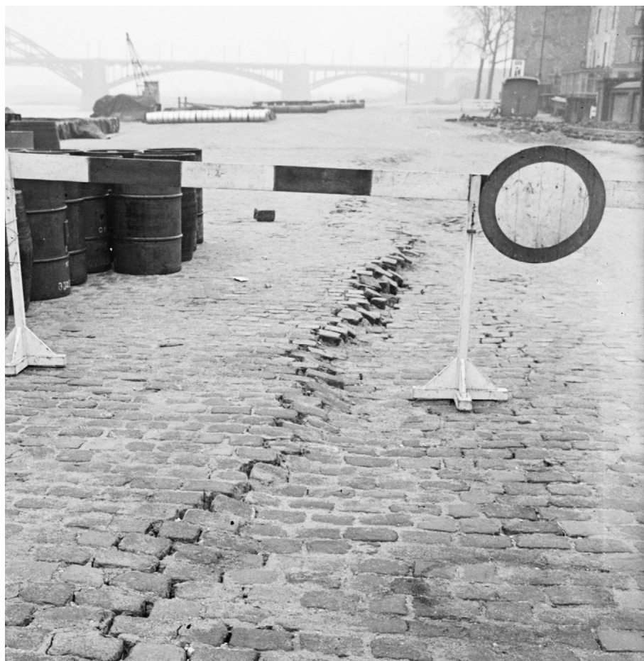
Figuur 2.44. Verzakking van de Waalkade (1957) ten gevolge van het hoge water. Op de achtergrond de Waal-Verkeersbrug (RAN, GN6463).
