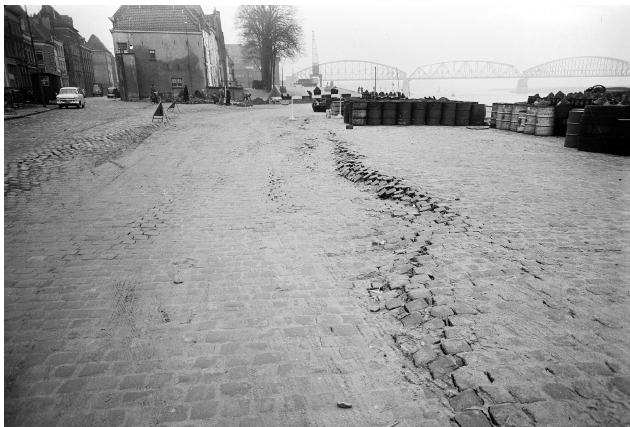
Figuur 2.45. Verzakking van de Waalkade (1957) ten gevolge van het hoge water. Op de achtergrond de Waal-Spoorbrug (RAN, GN6464).
