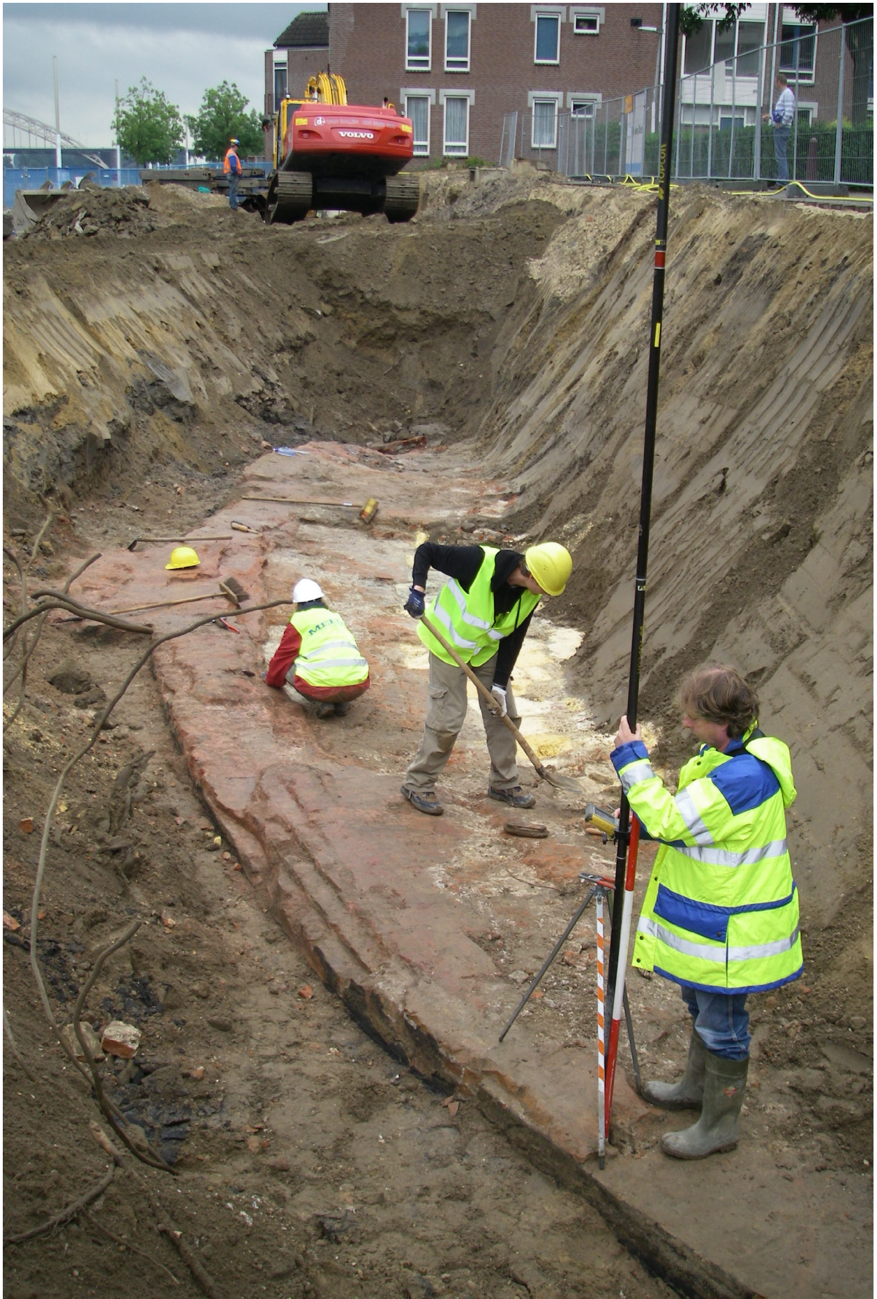
Figuur 4.22. Overzichtfoto van de Rode Toren, de westelijke havenmuur is op deze foto niet te zien. Kijkerichting west-oost.
