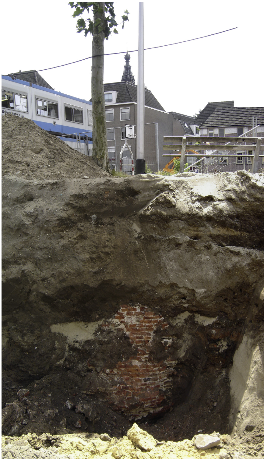
Figuur 4.20. De oostelijke havenmuur S5.1.
