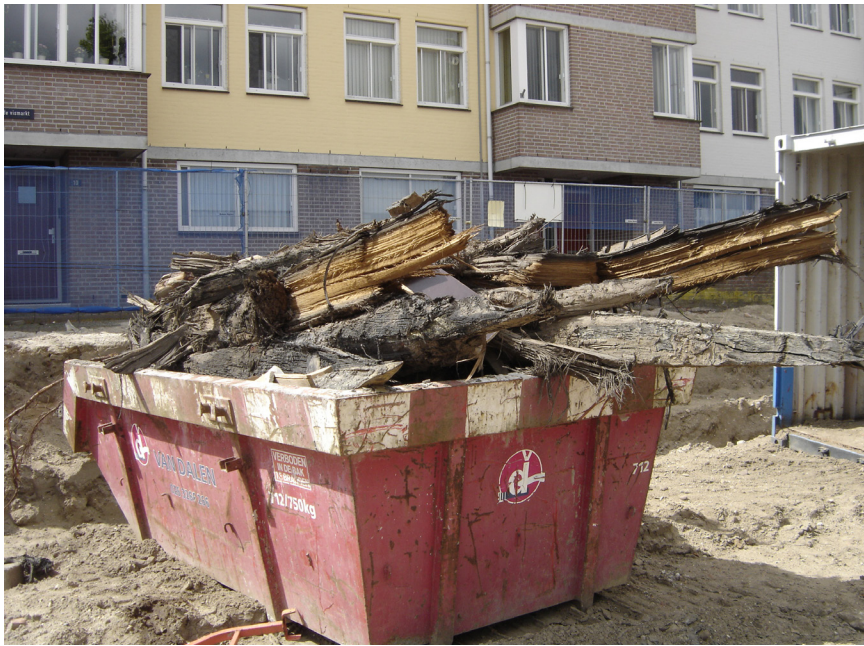
Figuur 4.34. Restanten van houten palen S4.1.
