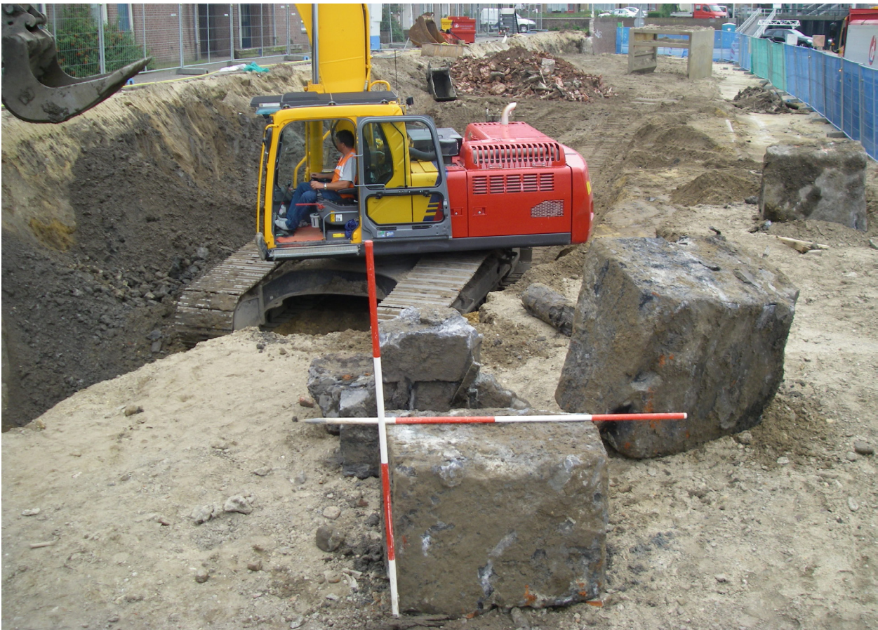
92 Figuur 4.30. Natuurstenen blokken nadat deze machinaal verwijderd zijn.
