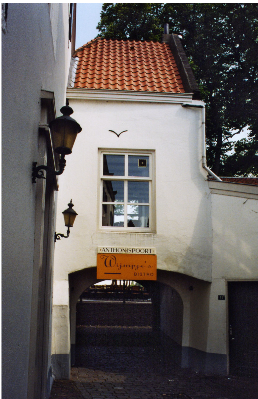
Figuur 4.47. Zuidgevel van het poortgebouw de St. Anthonispoort (Bureau voor bouwhistorisch onderzoek J.A. van der Hoeve, in opdracht van gemeente Nijmegen). RM
