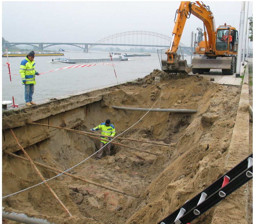
Figuur 3.7. Lastige omstandigheden bij de aanleg van een werkput.
