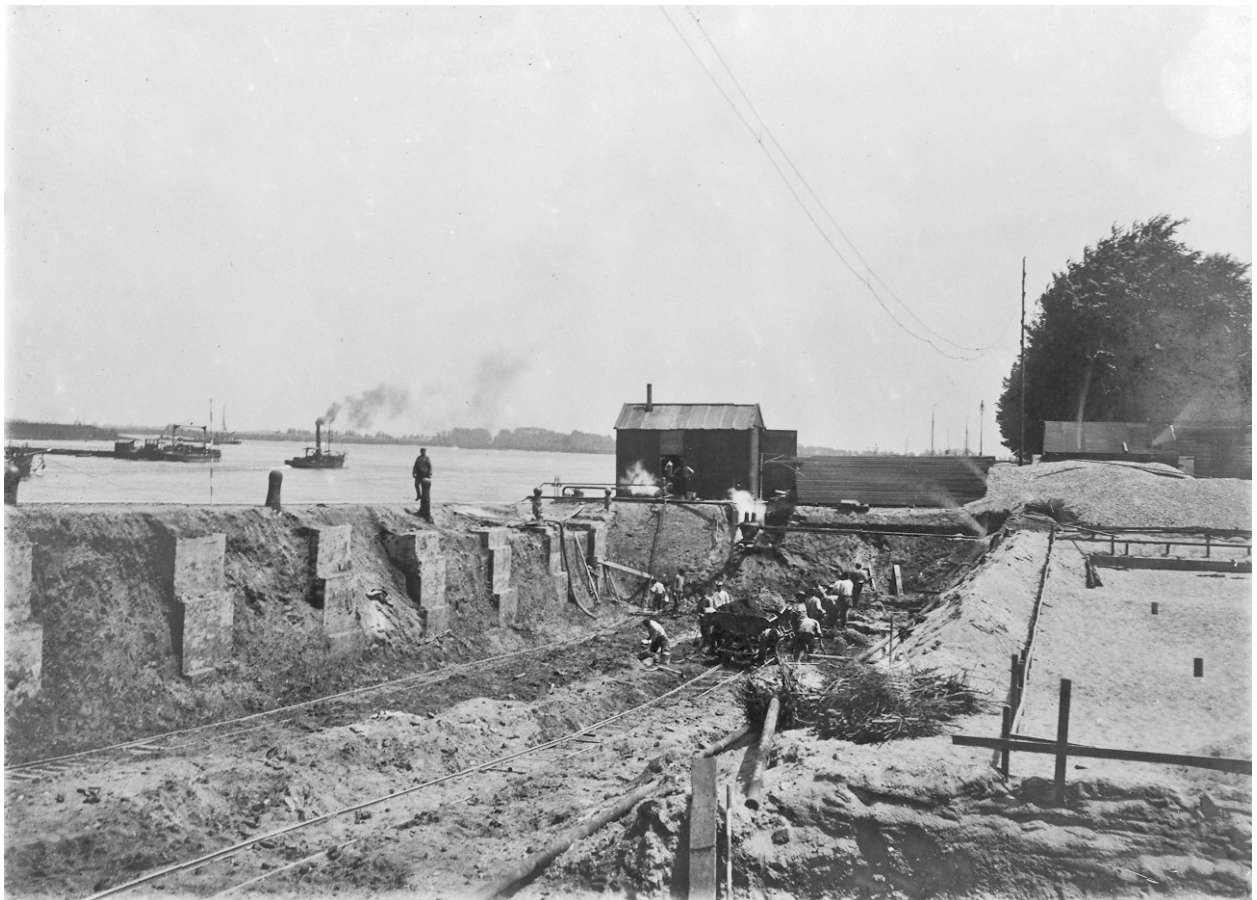
Figuur 2.30. Werkzaamheden ten behoeve van de bouw van de elektriciteitscentrale (1908) (RAN, foto F1857). Op de foto is ook de binnenzijde van het muurwerk van de Oude Haven nog goed te zien.
