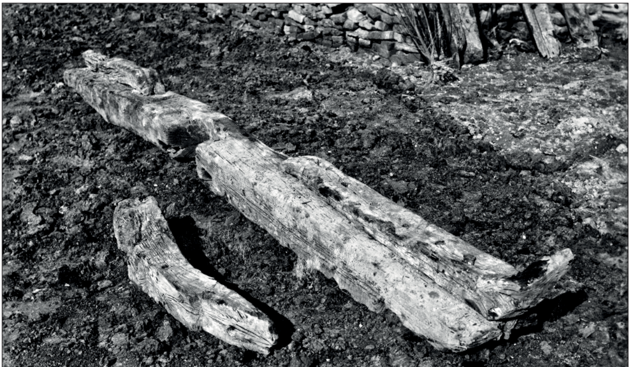
Fig. 3.27 Foto gemaakt tijdens het onderzoek in 1944. De zeilbalk. Ook bij deze dekbalk bevinden zich aan de bovenzijde twee knieën die voor extra stevigheid zorgen in de verbinding met de boorden. Op de foto is te zien dat de knieën met houten pennen aan de balk zijn vastgemaakt. Aan weerszijden van de halfronde inkeping, waar de mast in valt, zijn twee sponningen te zien. Mogelijk zijn deze bedoeld voor de bevestiging van schaarstokken. Op de achtergrond is waarschijnlijk een deel van de lading bakstenen zichtbaar (© Rijksuniversiteit Groningen, Groninger Instituut voor Archeologie).
