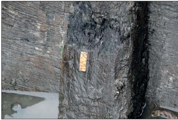
Fig. 3.10 Koperen plaatje met het spannummer, in dit geval 'XVII'. Aangebracht in 1944 (Foto: K. Blok, RUG/GIA).
