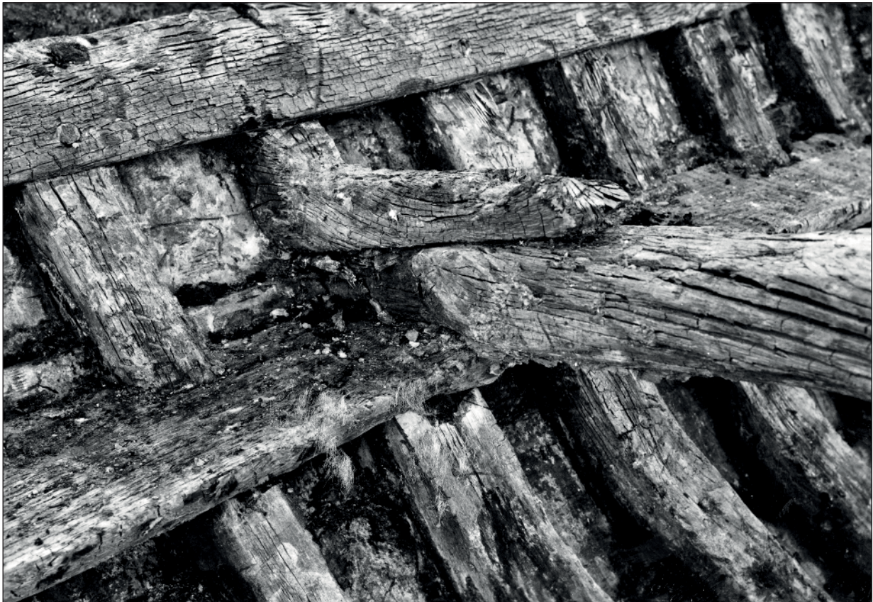
Fig. 3.26 Foto gemaakt tijdens het onderzoek in 1944. Detail van de in situ aangetroffen dekbalk. Duidelijk zichtbaar is de knie bovenop de balk, die voor een (extra) verbinding zorgt met het boord. Onder de balk is een deel van het gangboord te zien. De foto maakt daarnaast duidelijk dat het scheepshout al deels is uitgedroogt, wat zich uit in bijvoorbeeld de scheuren in de dekbalk en het geschilferde oppervlak van het potdeksel (© Rijksuniversiteit Groningen, Groninger Instituut voor Archeologie).
