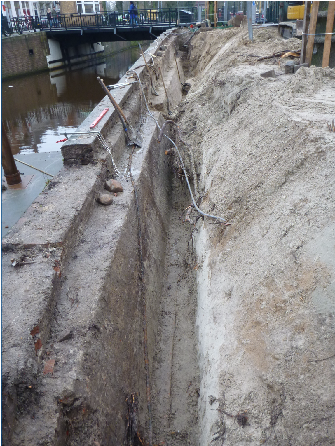
Figuur 3. Ontgraving ten behoeve van het kadeherstel.
