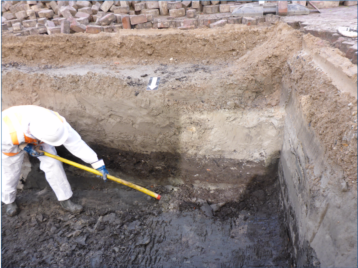
Figuur 3. Uitgraven van de put voor de afvalcontainers in de Pijpstraat.
