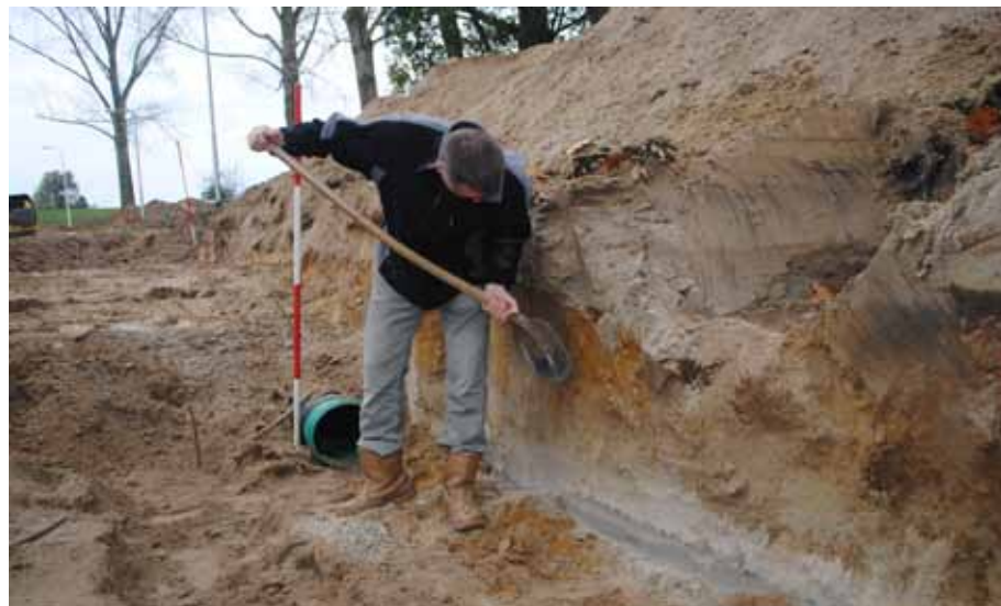
3. Afsteken van een profiel in de rioolsleuf.
